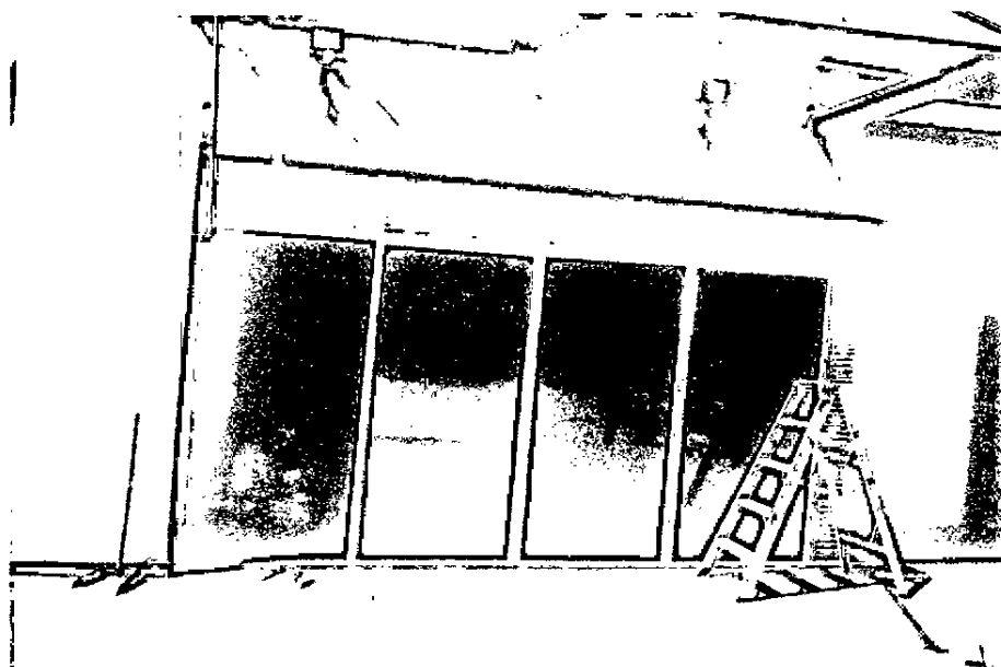
Desmante, traslado y colocación de división exterior en aluminio.
