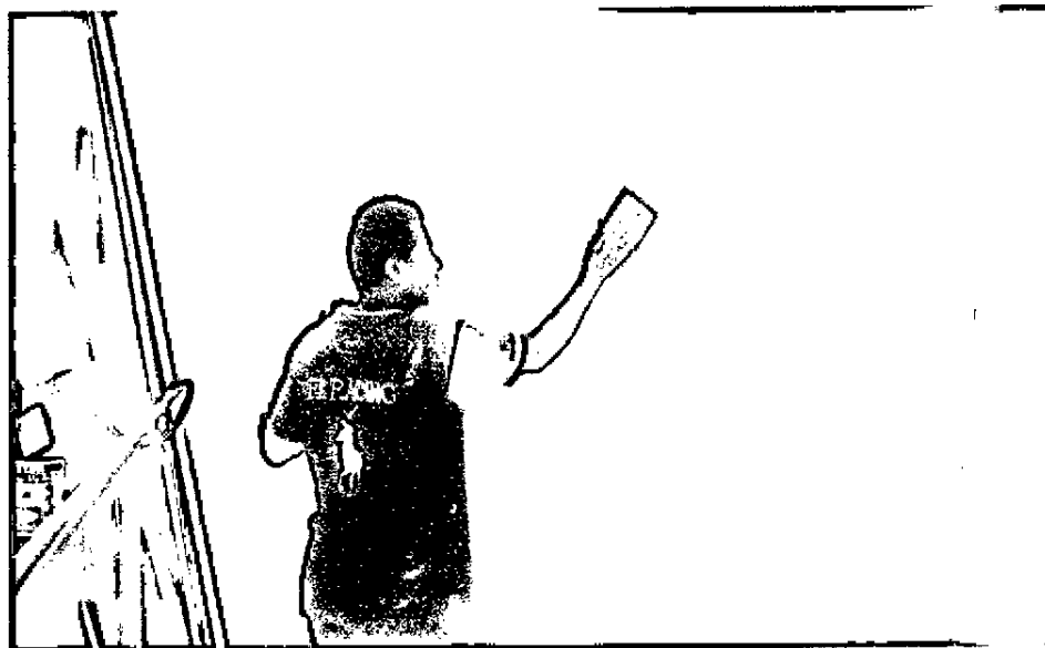
Estuco y lijado de muros.
