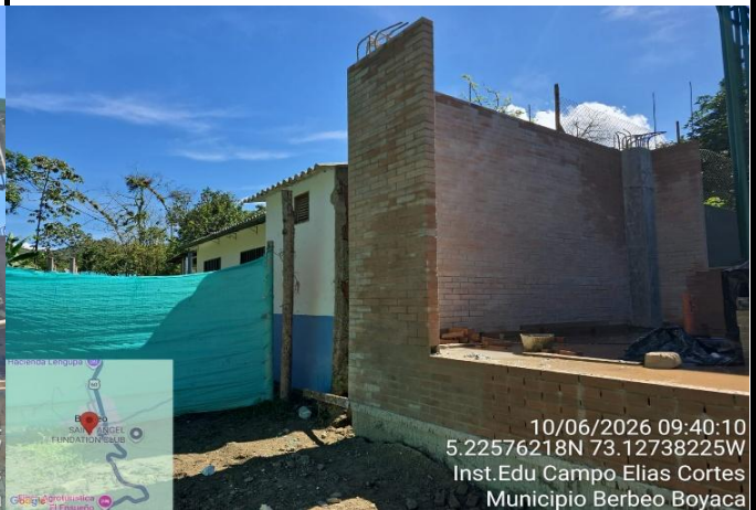
FOTO 24. CONSTRUCCIÓN DE MURO EN LADRILLO PRENSADO TIPO SANTAFE
