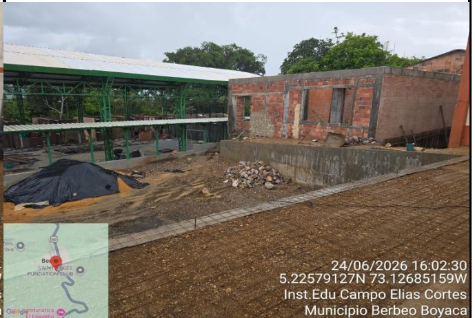
FOTO 28. INSTALACIÓN DE CONCRETO DE REFUERZO RAMPA
