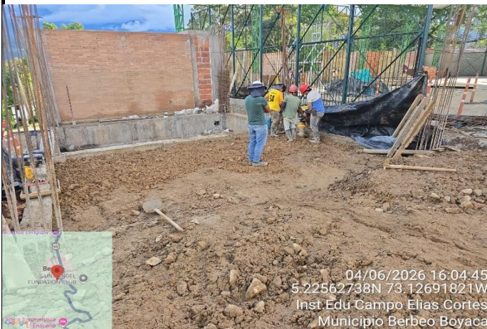
FOTO 23. CONSTRUCCIÓN DE MURO EN LADRILLO PRENSADO TIPO SANTAFE
