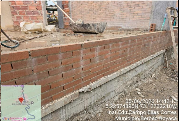
FOTO 22. RELLENO CON MATERIAL DE AFIRMADO
