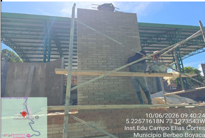
FOTO 23. CONSTRUCCIÓN DE MURO EN LADRILLO PRENSADO TIPO SANTAFE
