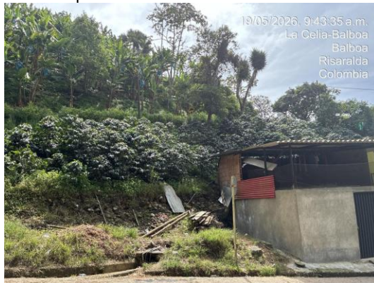
Imagen 5. Vivienda ubicada en inmediaciones del corredor vial sobre el costado externo de la curva evaluada. Fuente: Registro fotográfico visita técnica, 2026.
