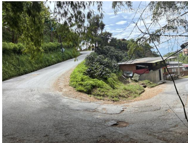
Imagen 2. Curva de radio reducido con presencia de viviendas ubicadas sobre el costado externo del corredor vial. Fuente: Registro fotográfico visita técnica, 2026.
