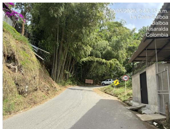
Imagen 4. Señalización preventiva vertical existente en el sector objeto de evaluación técnica. Fuente: Registro fotográfico visita técnica, 2026.
