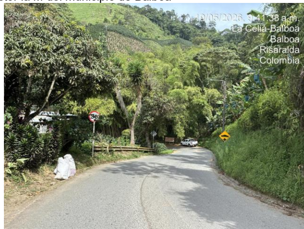
Imagen 3. Señalización preventiva y condiciones actuales de seguridad vial en el sector evaluado. Fuente: Registro fotográfico visita técnica, 2026.
