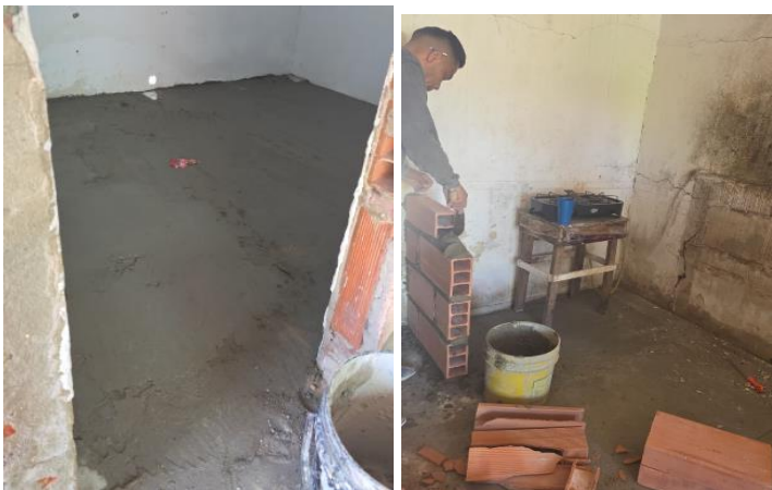
Actividad: Demolición de pisos, plantillas para pisos, construcción de cocina, construcción y levante de muro en cocina. Vivienda: Martha Herrera, K 22 117-13.
