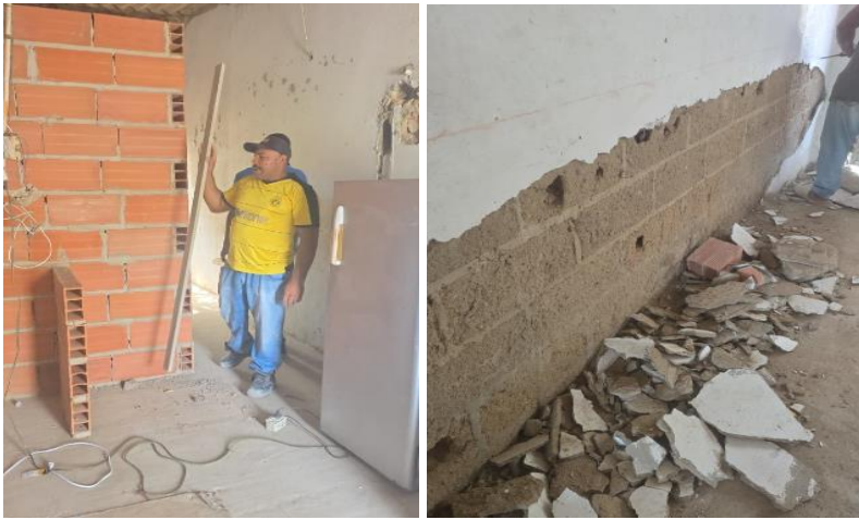
Actividad: Demolición de enchape antiguo, construcción de cocina, demolición pared en mal estado, estuco en paredes y enchape de pisos. Vivienda: Rosa Acuña Contreras, C 120 37 34
