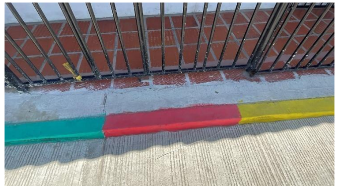
MODULO 1 / OBRA AD16 / OVALLE CARRERA 14 ENTRE CALLE 12B Y DIAGONAL 5 - LA CHINITA.
