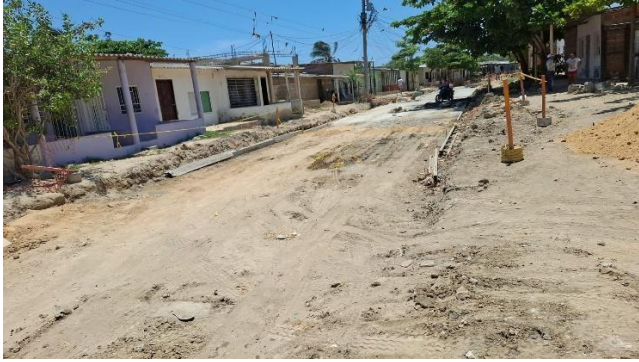
MODULO 3 / OBRA 35 / SAADE CALLE 18 ENTRE CARRERAS 7 Y 10 - CORREGIMIENTO LA PLAYA.
