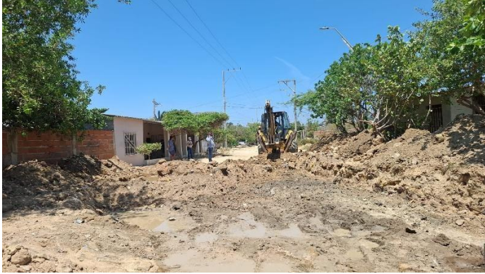
MODULO 3 / OBRA 37 / SAADE CARRERA 9 ENTRE CARRERA 10 Y CALLE 20B - CORREGIMIENTO LA PLAYA
