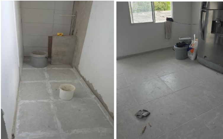
Actividad: Demolición de pisos, plantillas para pisos y enchape, construcción de baño, enchape de pisos de cocina y baño. Vivienda: Luz Herrera Duque, C 121 26-39.
