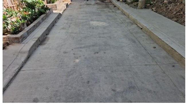
MODULO 3 / OBRA 5 / SAADE CALLE 45F ENTRE CARRERAS 15 SUR Y 18 SUR - VILLA SEVILLA.
