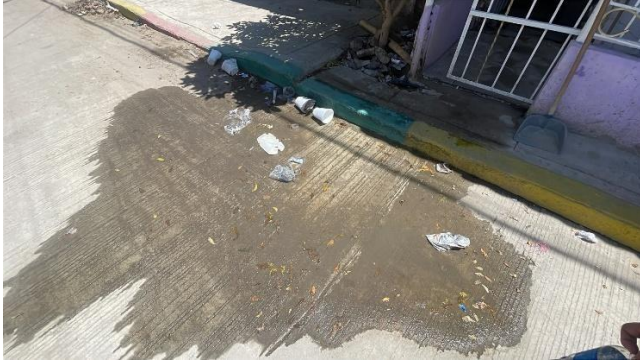
MODULO 1 / OBRA AD16 / OVALLE CARRERA 14A ENTRE CALLE 12B Y DIAGONAL 5 - LA CHINITA.
