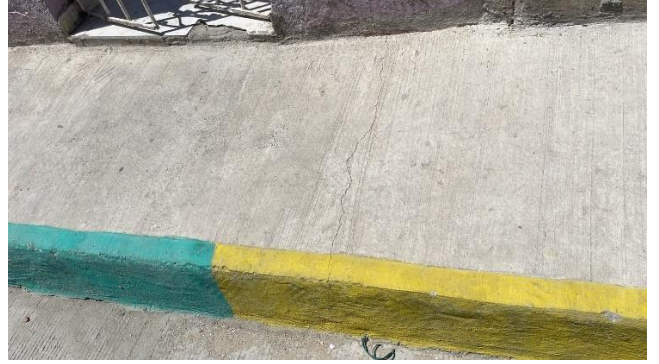
MODULO 1 / OBRA / OVALLE CARRERA 14A ENTRE CALLES 17 Y 15 - LA CHINITA.
