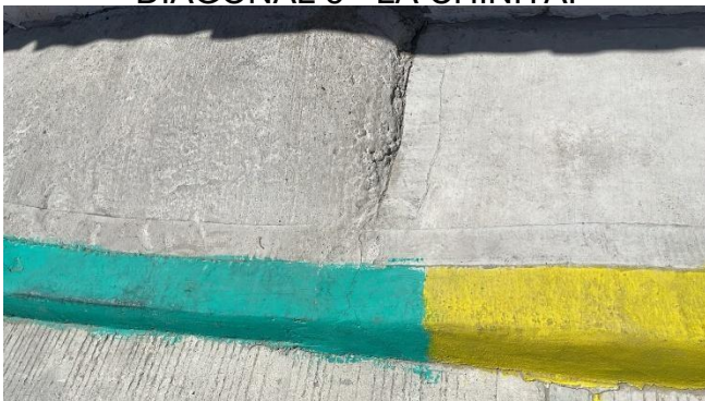
MODULO 1 / OBRA AD16 / OVALLE CARRERA 14 ENTRE CALLE 12B Y DIAGONAL 5 - LA CHINITA.
