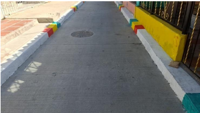
MODULO 3 / OBRA AD7 / SAADE CALLE 45D ENTRE CARRERAS 16 SUR Y 18 SUR - VILLA SEVILLA.
