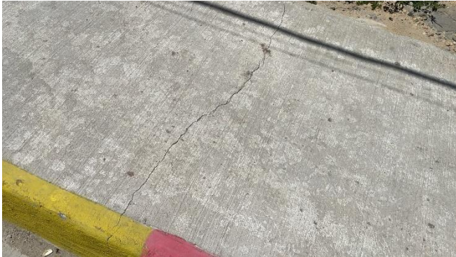
MODULO 1 / OBRA / OVALLE CARRERA 14A ENTRE CALLES 17 Y 15 - LA CHINITA.
