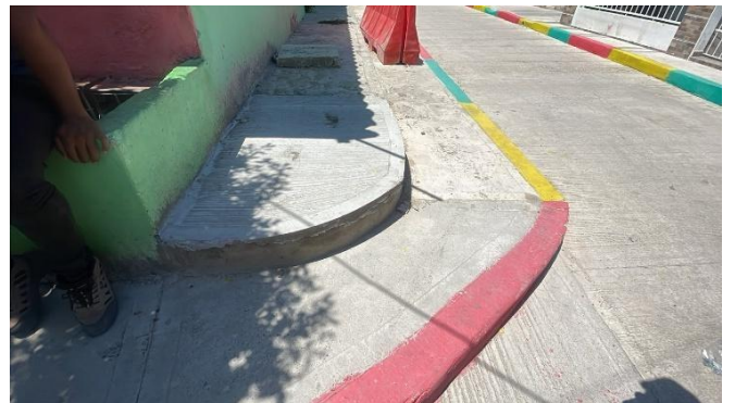
MODULO 1 / OBRA AD16 / OVALLE CARRERA 14A ENTRE CALLE 12B Y DIAGONAL 5 - LA CHINITA
