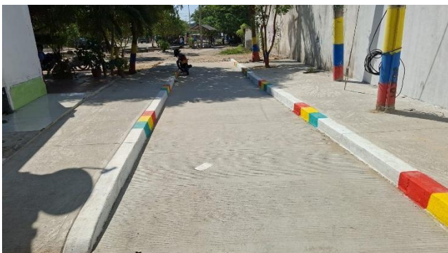
MODULO 3 / OBRA AD8 / SAADE CARERRA 16A SUR CON CALLE 45D (BOLSILLO) - VILLA SEVILLA.
