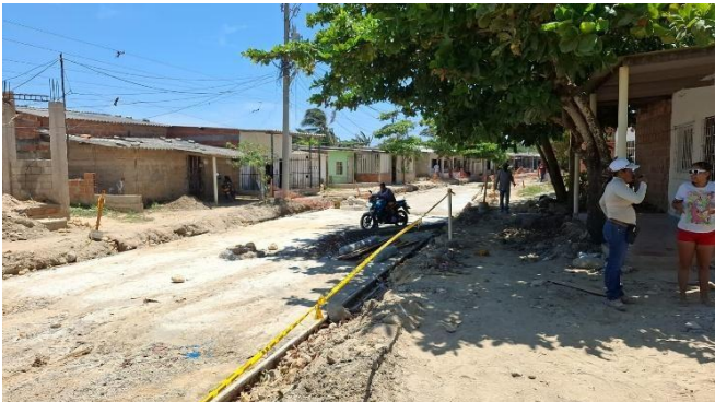
MODULO 3 / OBRA 35 / SAADE CALLE 18 ENTRE CARRERAS 7 Y 10 - CORREGIMIENTO LA PLAYA.
