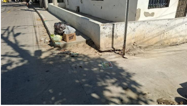
MODULO 3 / OBRA 5 / SAADE CALLE 45F ENTRE CARRERAS 15 SUR Y 18 SUR - VILLA SEVILLA.
