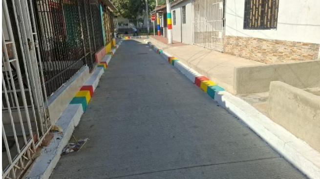
MODULO 3 / OBRA AD7 / SAADE CALLE 45D ENTRE CARRERAS 16 SUR Y 18 SUR - VILLA SEVILLA.
