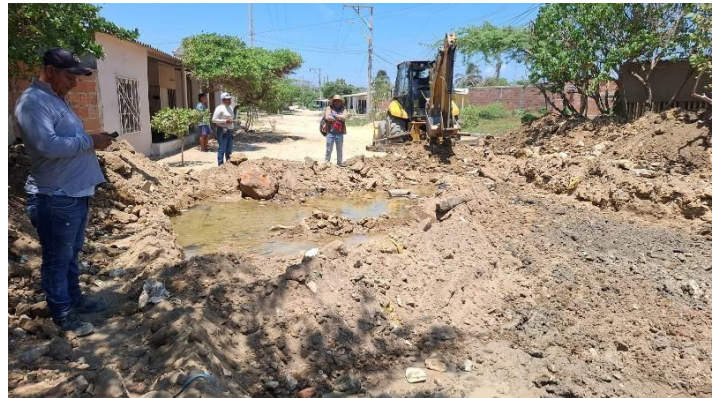
MODULO 3 / OBRA 37 / SAADE CARRERA 9 ENTRE CARRERA 10 Y CALLE 20B - CORREGIMIENTO LA PLAYA
