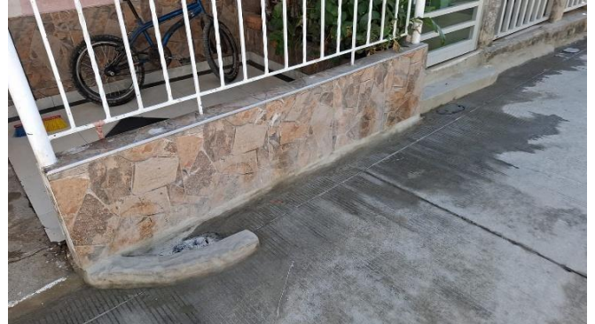
MODULO 3 / OBRA AD8 / SAADE CARERRA 16A SUR CON CALLE 45D (BOLSILLO) - VILLA SEVILLA.
