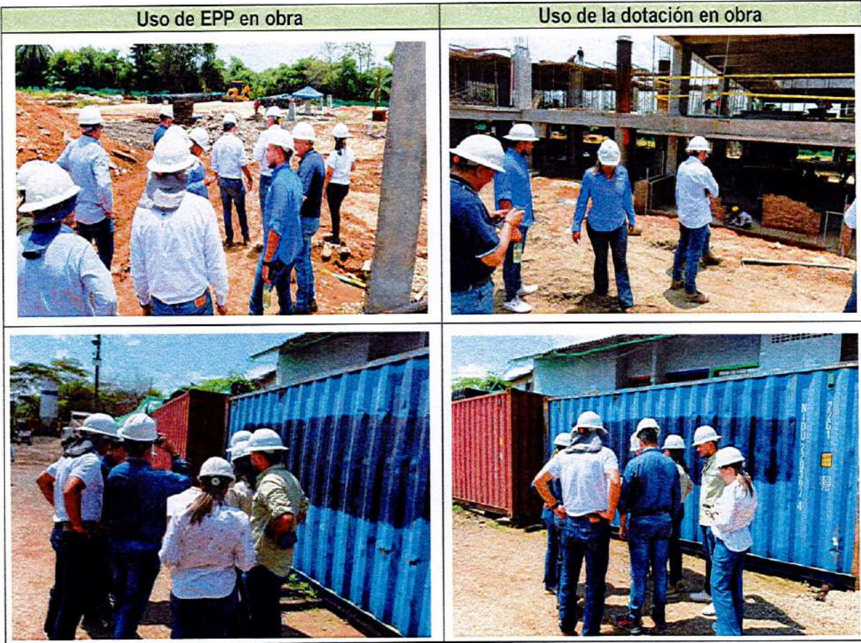
Anexo N°5 -CI-CA-FT-04 Inspección de EPP
