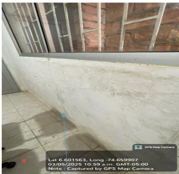
Foto 01: Detalle estado de pisos área salón este tipo de acabado no garantiza la salubridad exigida para este servicio de salud.
