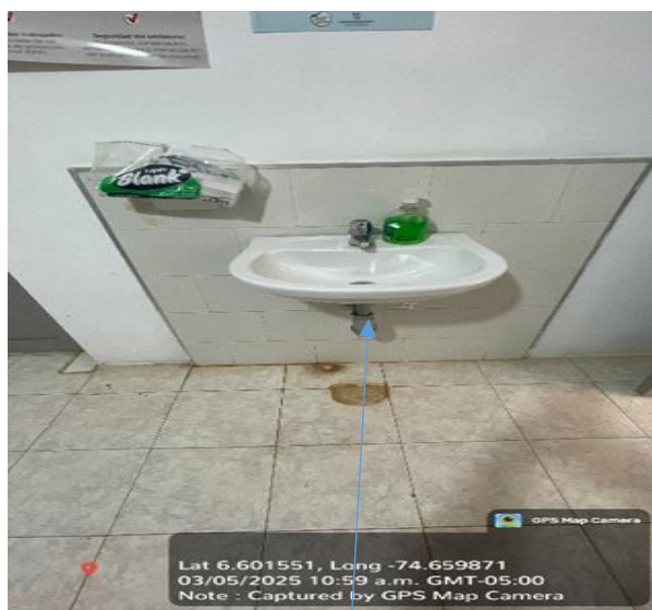
Foto 02: se observa los aparatos sanitarios – lavamanos los cuales presentan riesgo para los usuarios y no cumple norma de salubridad y mucho menos para discapacitados.
