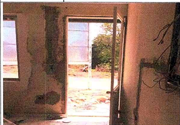
Foto: instalacion puerta cold rolled
