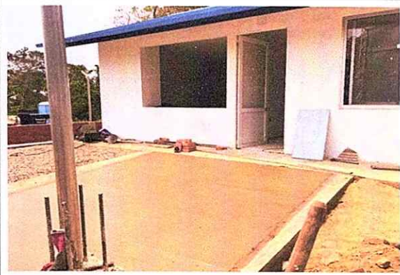
Foto: construcción placa en concreto
