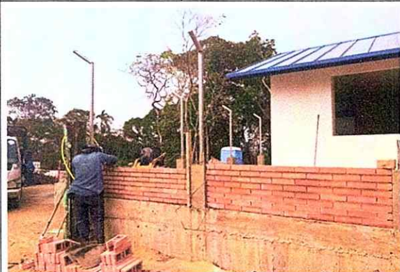
Foto: construcción cerramiento
