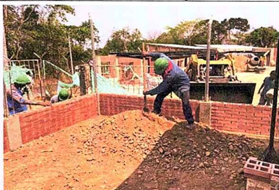
Foto: construcción cerramiento
