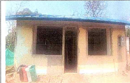
Fotografía No. 01 – Vista Frontal
