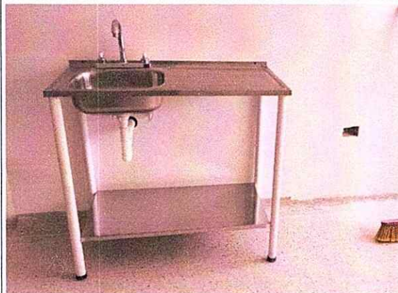
Foto: instalación mesón en acero
