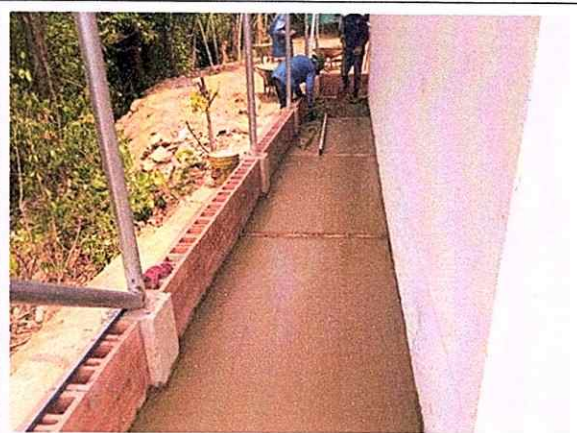
Foto: construcción placa en concreto
