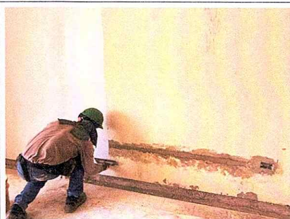
Foto: instalación estuco pared
