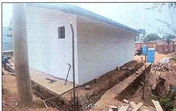
Fotografía No. 33 – Vista Posterior izquierda
