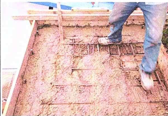
Foto: construcción placa tanque
