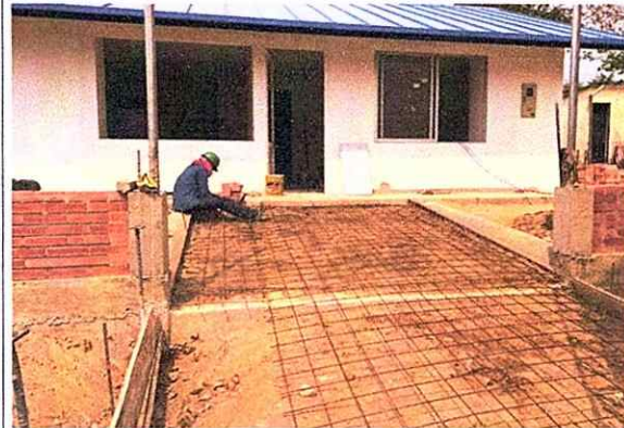
Foto: construcción placa en concreto
