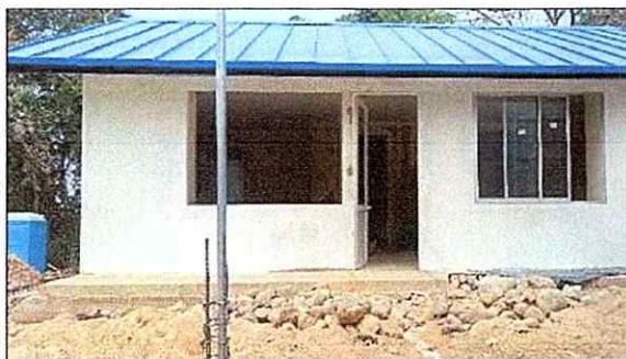
Fotografía No. 31 – Vista Frontal
