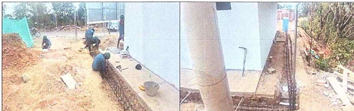
Fotografía No. 25 – Instalación De Canastas De Encerramiento 1
