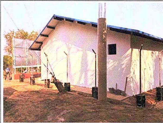
Foto: instalación estuco pared
