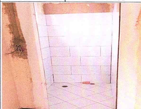
Foto: instalación enchape pared
