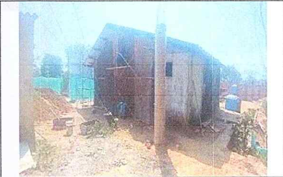
Fotografía No. 04 – Vista Posterior trasera1
