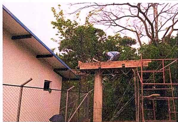
Foto: construcción placa tanque
