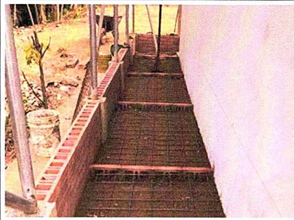
Foto: construcción placa en concreto
