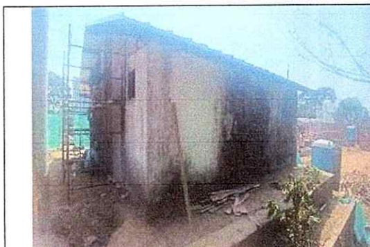
Fotografía No. 05 – Vista Posterior trasera 2
