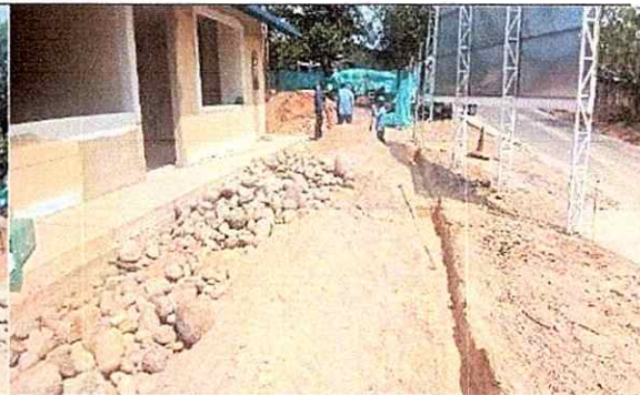
Fotografía No. 20 – Zanja de Encerramiento
