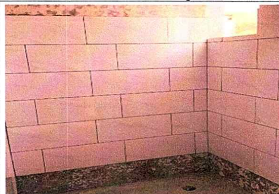
Foto: instalación enchape pared
