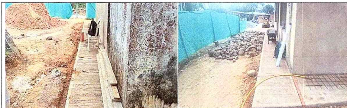
Fotografía No. 13 – Anden 1
