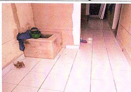
Foto: instalación piso ceramica
