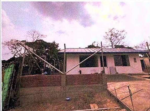
Foto: construcción cerramiento
