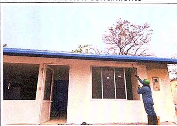
Foto: instalacion puerta cold rolled
