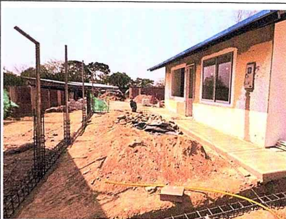
Foto: construcción cerramiento
