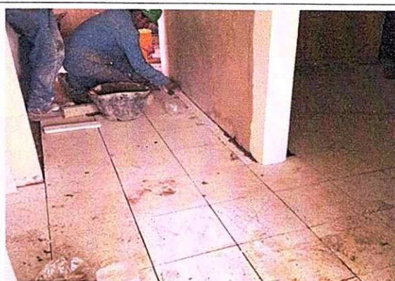
Foto: instalación baldosa grano mármol
