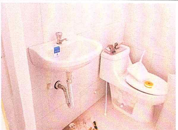
Foto: instalación lavamanos
