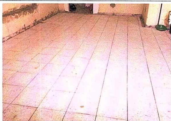
Foto: instalación baldosa grano mármol
