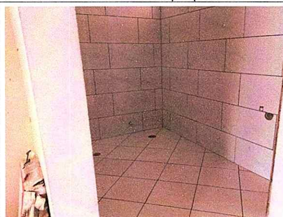
Foto: instalación enchape pared
