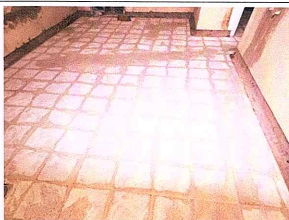
Foto: instalación baldosa grano mármol
