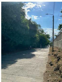
Fotografía 019. Evidencia de ejecución y condición del frente intervenido – Centro Zonal Buga.
