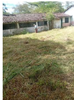
Fotografía 014. Evidencia de ejecución y condición del frente intervenido – Casa Hernando Ospina – sector piscina.
