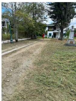
Fotografía 001. Evidencia de ejecución y condición del frente intervenido – Centro Zonal Buga.
