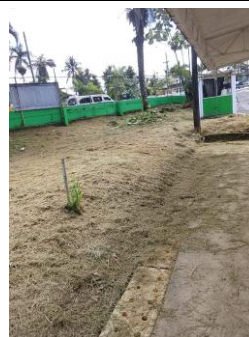
Fotografía 004. Evidencia de ejecución y condición del frente intervenido – Centro Zonal Suroriental.
