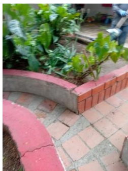
Fotografía 001. Evidencia de ejecución y condición del frente intervenido – Centro Zonal Cartago.
