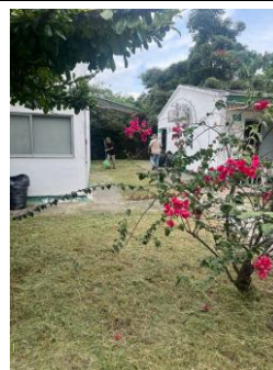
Fotografía 022. Evidencia de ejecución y condición del frente intervenido – Centro Zonal Suroriental.
