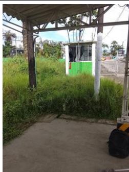
Fotografía 003. Evidencia de ejecución y condición del frente intervenido – Centro Zonal Suroriental.
