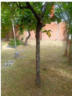
Fotografía 023. Evidencia de ejecución y condición del frente intervenido – Sede Regional.
