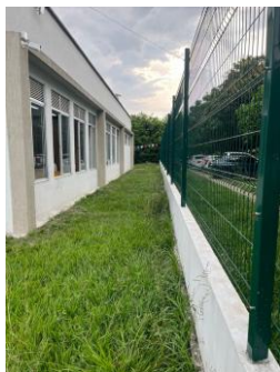
Fotografía 029. Evidencia de ejecución y condición del frente intervenido – Centro Zonal Suroriental.
