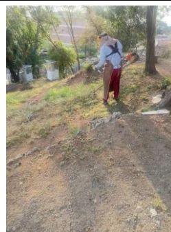
Fotografía 004. Evidencia de ejecución y condición del frente intervenido – Centro Zonal Yumbo.
