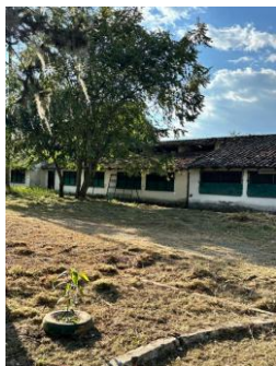
Fotografía 023. Evidencia de ejecución y condición del frente intervenido – Centro Zonal Buga.
