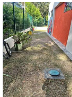
Fotografía 010. Evidencia de ejecución y condición del frente intervenido – Centro Zonal Buga.
