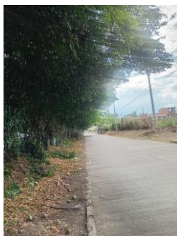
Fotografía 085. Evidencia de ejecución y condición del frente intervenido – Centro Zonal Buga.
