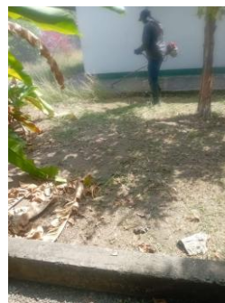
Fotografía 068. Evidencia de ejecución y condición del frente intervenido – Centro Zonal Suroriental.
