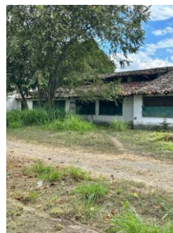
Fotografía 020. Evidencia de ejecución y condición del frente intervenido – Centro Zonal Buga.
