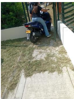
Fotografía 013. Evidencia de ejecución y condición del frente intervenido – CDI Manitos con Amor.
