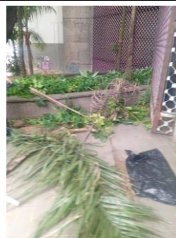
Fotografía 004. Evidencia de ejecución y condición del frente intervenido – Centro Zonal Centro.
