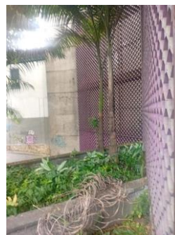
Fotografía 014. Evidencia de ejecución y condición del frente intervenido – Centro Zonal Centro.
