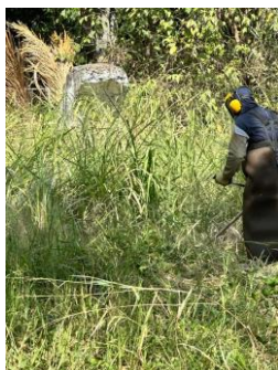
Fotografía 031. Evidencia de ejecución y condición del frente intervenido – Centro Zonal Buga.
