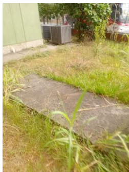
Fotografía 011. Evidencia de ejecución y condición del frente intervenido – Sede Regional.
