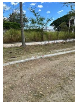
Fotografía 008. Evidencia de ejecución y condición del frente intervenido – Centro Zonal Buga.
