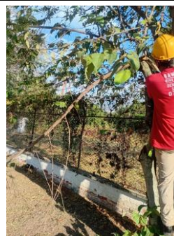
Fotografía 070. Evidencia de ejecución y condición del frente intervenido – Centro Zonal Buga.
