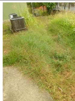
Fotografía 004. Evidencia de ejecución y condición del frente intervenido – Sede Regional.
