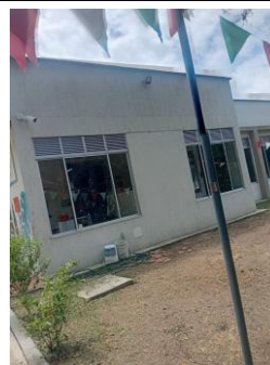
Fotografía 058. Evidencia de ejecución y condición del frente intervenido – Centro Zonal Suroriental.
