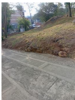
Fotografía 005. Evidencia de ejecución y condición del frente intervenido – Centro Zonal Yumbo.
