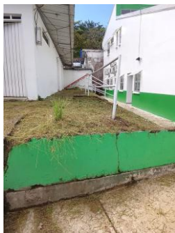
Fotografía 005. Evidencia de ejecución y condición del frente intervenido – Centro Zonal Suroriental.
