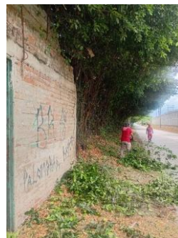
Fotografía 090. Evidencia de ejecución y condición del frente intervenido – Centro Zonal Buga.
