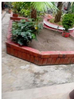
Fotografía 005. Evidencia de ejecución y condición del frente intervenido – Centro Zonal Cartago.
