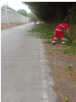
Fotografía 083. Evidencia de ejecución y condición del frente intervenido – Centro Zonal Buga.
