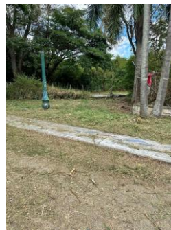
Fotografía 006. Evidencia de ejecución y condición del frente intervenido – Centro Zonal Buga.
