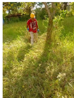
Fotografía 044. Evidencia de ejecución y condición del frente intervenido – Centro Zonal Buga.
