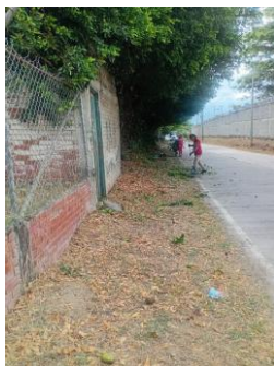
Fotografía 089. Evidencia de ejecución y condición del frente intervenido – Centro Zonal Buga.
