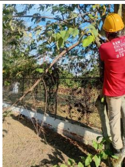
Fotografía 069. Evidencia de ejecución y condición del frente intervenido – Centro Zonal Buga.
