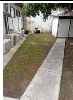
Fotografía 010. Evidencia de ejecución y condición del frente intervenido – Centro Zonal Cartago.
