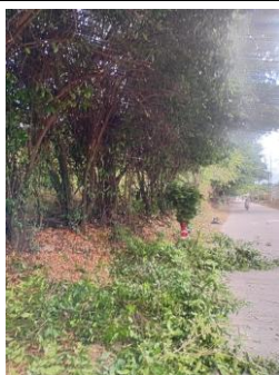
Fotografía 087. Evidencia de ejecución y condición del frente intervenido – Centro Zonal Buga.
