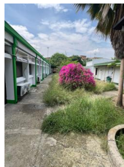
Fotografía 026. Evidencia de ejecución y condición del frente intervenido – Centro Zonal Suroriental.
