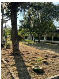
Fotografía 025. Evidencia de ejecución y condición del frente intervenido – Centro Zonal Buga.
