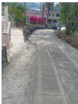
Fotografía 001. Evidencia de ejecución y condición del frente intervenido – Centro Zonal Yumbo.
