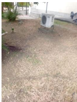
Fotografía 001. Evidencia de ejecución y condición del frente intervenido – Sede Regional.
