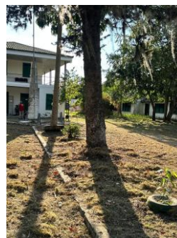
Fotografía 026. Evidencia de ejecución y condición del frente intervenido – Centro Zonal Buga.
