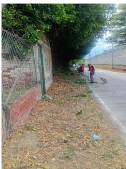
Fotografía 079. Evidencia de ejecución y condición del frente intervenido – Centro Zonal Buga.
