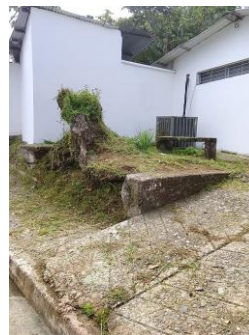
Fotografía 006. Evidencia de ejecución y condición del frente intervenido – Centro Zonal Buenaventura.
