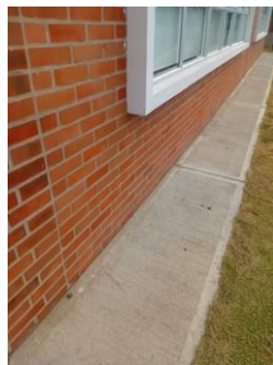
Fotografía 012. Evidencia de ejecución y condición del frente intervenido – Casa Atrapasueños Jamundí.
