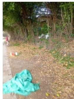
Fotografía 084. Evidencia de ejecución y condición del frente intervenido – Centro Zonal Buga.
