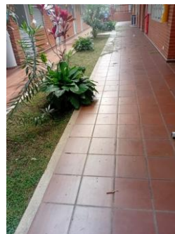
Fotografía 004. Evidencia de ejecución y condición del frente intervenido – Casa Atrapasueños Jamundí.
