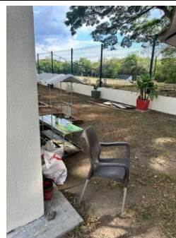
Fotografía 016. Evidencia de ejecución y condición del frente intervenido – Centro Zonal Buga.
