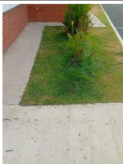
Fotografía 009. Evidencia de ejecución y condición del frente intervenido – Casa Atrapasueños Jamundí.
