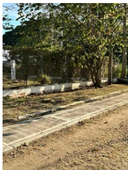
Fotografía 029. Evidencia de ejecución y condición del frente intervenido – Centro Zonal Buga.
