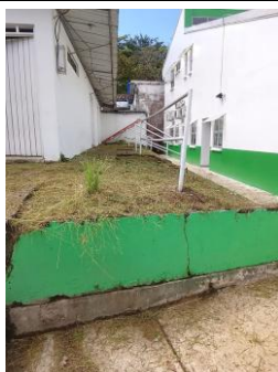
Fotografía 003. Evidencia de ejecución y condición del frente intervenido – Centro Zonal Buenaventura.
