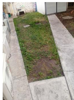
Fotografía 014. Evidencia de ejecución y condición del frente intervenido – Centro Zonal Cartago.
