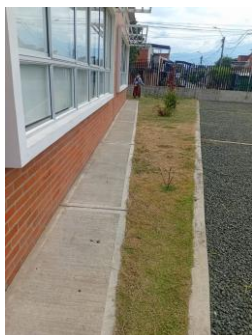
Fotografía 007. Evidencia de ejecución y condición del frente intervenido – Casa Atrapasueños Jamundí.
