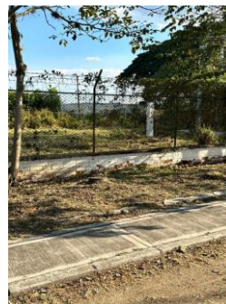
Fotografía 030. Evidencia de ejecución y condición del frente intervenido – Centro Zonal Buga.
