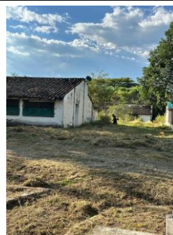
Fotografía 022. Evidencia de ejecución y condición del frente intervenido – Centro Zonal Buga.
