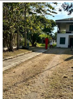
Fotografía 028. Evidencia de ejecución y condición del frente intervenido – Centro Zonal Buga.
