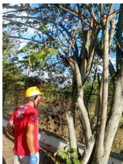
Fotografía 067. Evidencia de ejecución y condición del frente intervenido – Centro Zonal Buga.
