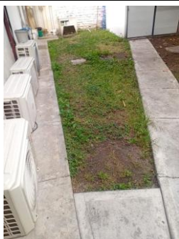
Fotografía 015. Evidencia de ejecución y condición del frente intervenido – Centro Zonal Cartago.
