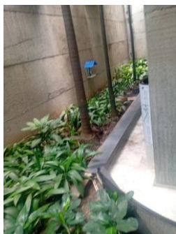
Fotografía 013. Evidencia de ejecución y condición del frente intervenido – Centro Zonal Centro.
