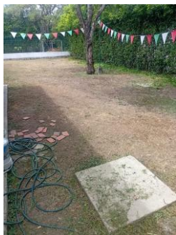
Fotografía 053. Evidencia de ejecución y condición del frente intervenido – Centro Zonal Suroriental.
