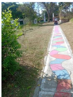
Fotografía 007. Evidencia de ejecución y condición del frente intervenido – CDI Manitos con Amor.
