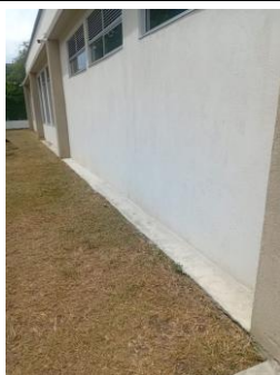
Fotografía 051. Evidencia de ejecución y condición del frente intervenido – Centro Zonal Suroriental.
