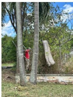
Fotografía 007. Evidencia de ejecución y condición del frente intervenido – Centro Zonal Buga.
