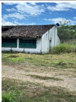
Fotografía 009. Evidencia de ejecución y condición del frente intervenido – Centro Zonal Buga.
