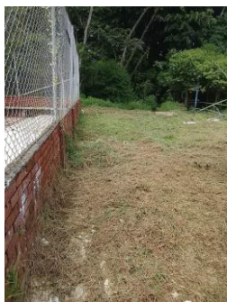
Fotografía 001. Evidencia de ejecución y condición del frente intervenido – Centro Zonal Suroriental.
