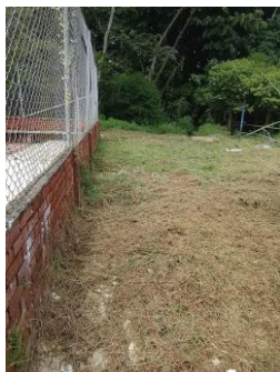
Fotografía 005. Evidencia de ejecución y condición del frente intervenido – Centro Zonal Buenaventura.
