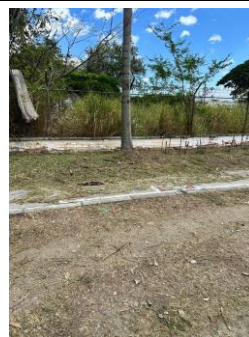
Fotografía 004. Evidencia de ejecución y condición del frente intervenido – Centro Zonal Buga.
