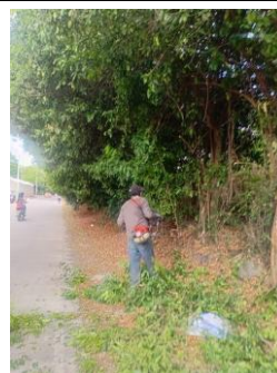
Fotografía 094. Evidencia de ejecución y condición del frente intervenido – Centro Zonal Buga.
