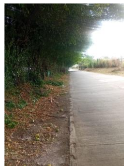
Fotografía 086. Evidencia de ejecución y condición del frente intervenido – Centro Zonal Buga.
