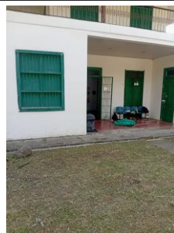
Fotografía 046. Evidencia de ejecución y condición del frente intervenido – Centro Zonal Buga.
