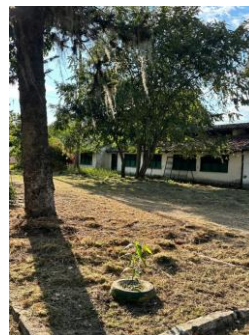
Fotografía 024. Evidencia de ejecución y condición del frente intervenido – Centro Zonal Buga.
