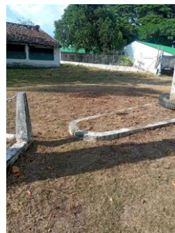
Fotografía 048. Evidencia de ejecución y condición del frente intervenido – Centro Zonal Buga.
