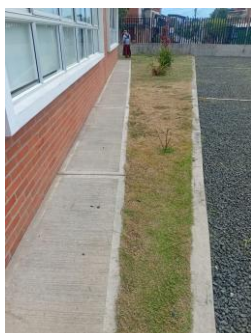
Fotografía 005. Evidencia de ejecución y condición del frente intervenido – Casa Atrapasueños Jamundí.
