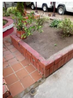
Fotografía 006. Evidencia de ejecución y condición del frente intervenido – Centro Zonal Cartago.
