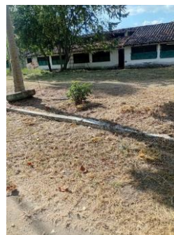
Fotografía 050. Evidencia de ejecución y condición del frente intervenido – Centro Zonal Buga.
