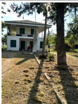
Fotografía 027. Evidencia de ejecución y condición del frente intervenido – Centro Zonal Buga.
