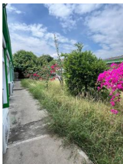
Fotografía 025. Evidencia de ejecución y condición del frente intervenido – Centro Zonal Suroriental.
