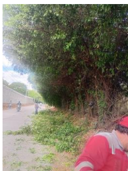
Fotografía 095. Evidencia de ejecución y condición del frente intervenido – Centro Zonal Buga.
