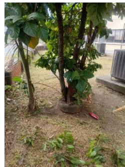
Fotografía 026. Evidencia de ejecución y condición del frente intervenido – Sede Regional.
