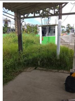
Fotografía 004. Evidencia de ejecución y condición del frente intervenido – Centro Zonal Buenaventura.
