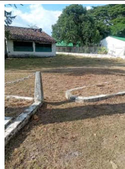
Fotografía 052. Evidencia de ejecución y condición del frente intervenido – Centro Zonal Buga.
