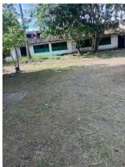
Fotografía 049. Evidencia de ejecución y condición del frente intervenido – Centro Zonal Buga.
