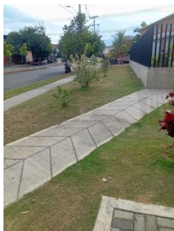
Fotografía 003. Evidencia de ejecución y condición del frente intervenido – Casa Atrapasueños Jamundí.
