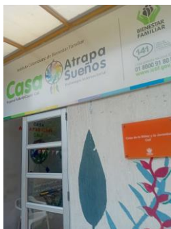
Fotografía 055. Evidencia de ejecución y condición del frente intervenido – Centro Zonal Suroriental.
