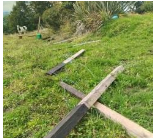
Foto 4: Suministro y disposición de postes en campo
