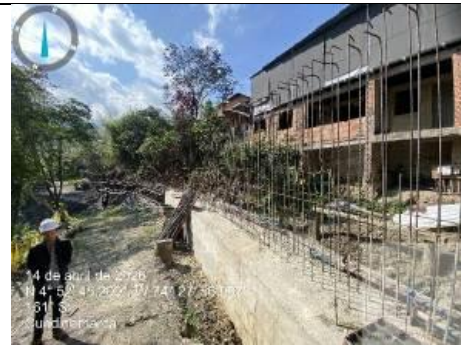
Foto 8. Ejecución de Obras de Ingeniería
