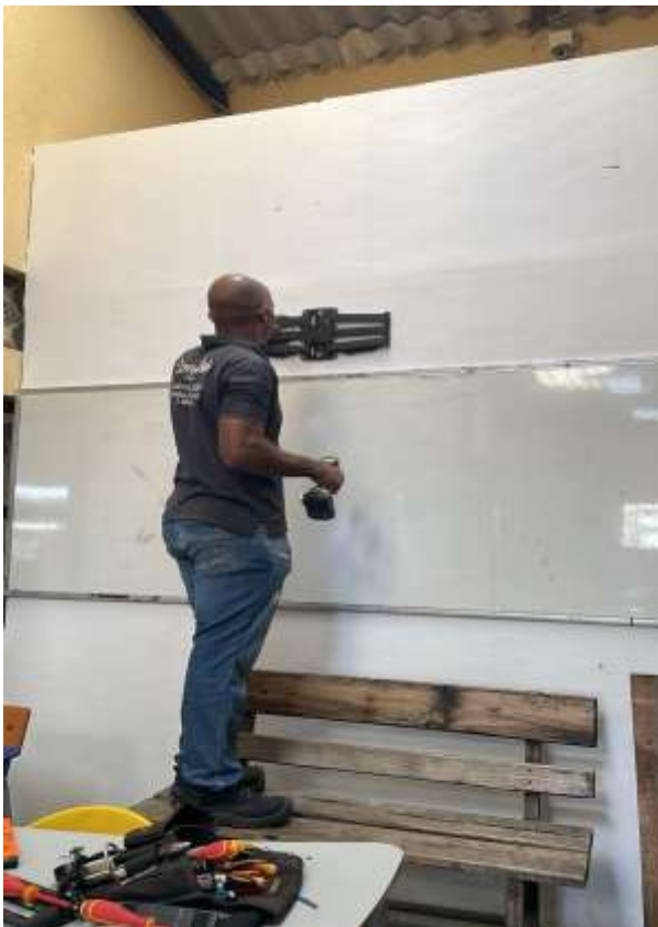
Instalación tablero y televisor salón 6
