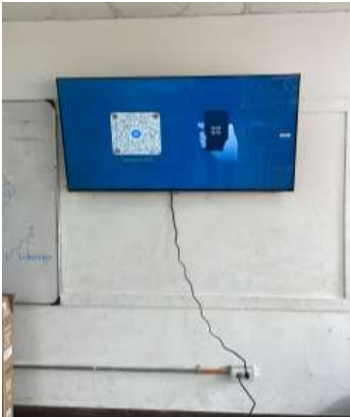
Instalación televisor aula 16
