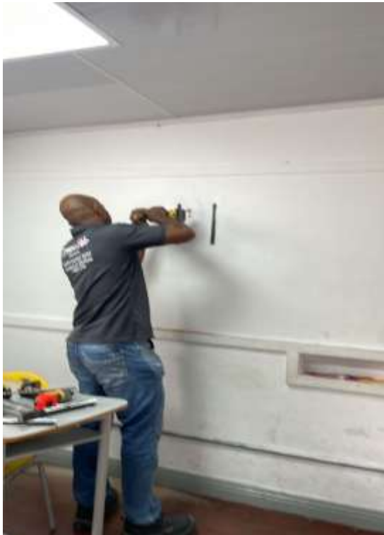
Instalación televisor aula 9
