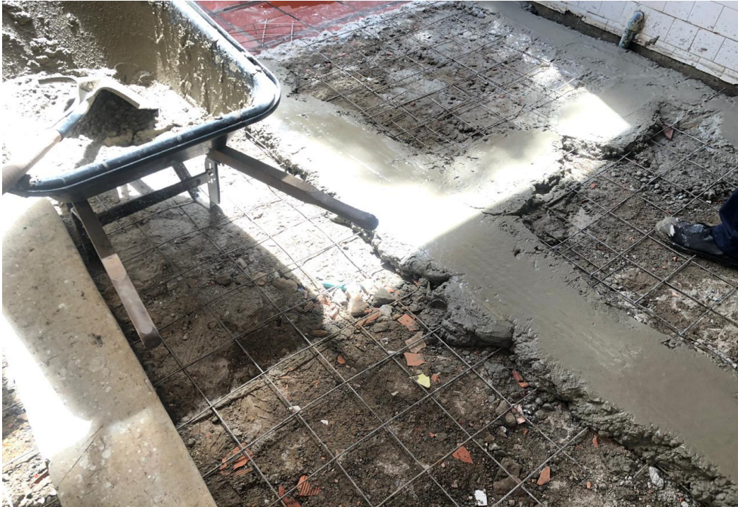
PLACA DE CONTRAPISO E=0,10 CONCRETO 3000 PSI
