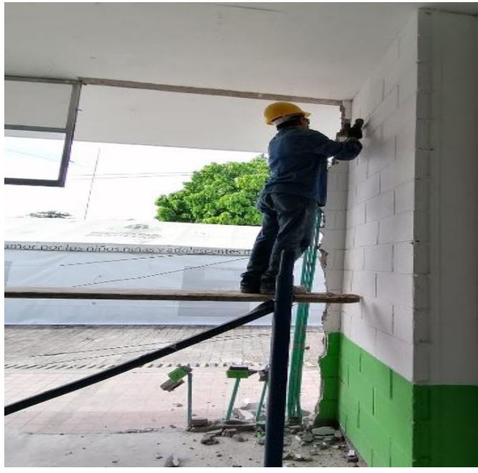
DEMOLICION DE MURO EN BLOQUE
