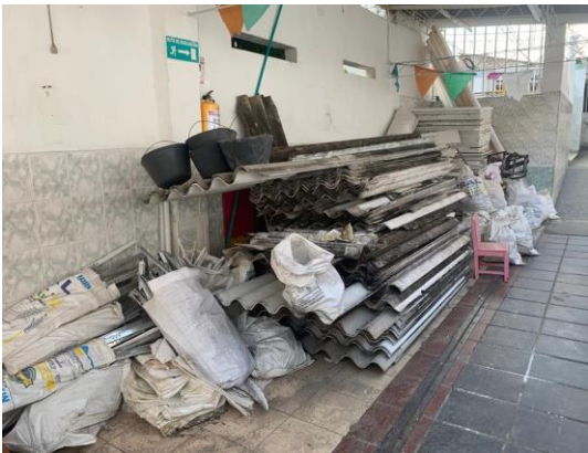
ACOPIO DE ESCOMBROS
