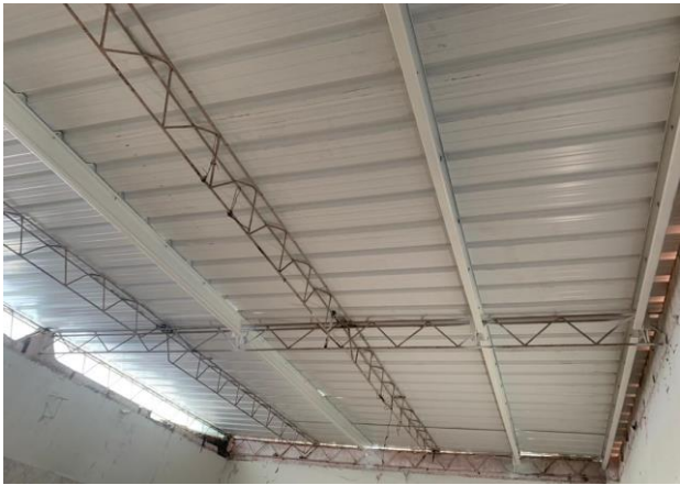
ESTRUCTURA METALICA Y CUBIERTA UPVC
