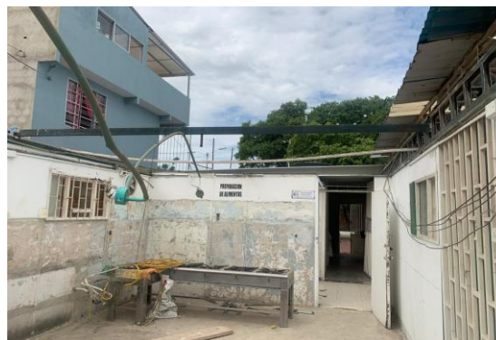
DESMONTE DE CUBIERTA
