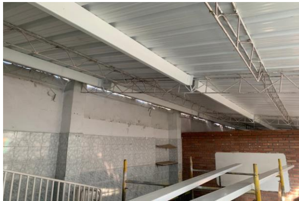
ESTRUCTURA METALICA Y CUBIERTA UPVC
