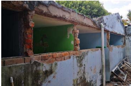
DESMONTE DE VENTANAS Y DEMOLICIÓN DE PAÑETE
