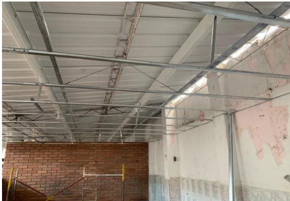
ESTRUCTURA DE CIELO RASO
