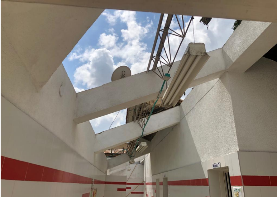
DESMONTE DE CIELO RASO FALSO
