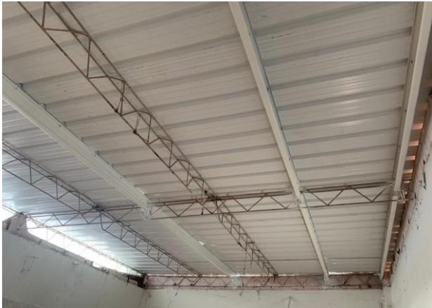
ESTRUCTURA METALICA Y CUBIERTA UPVC
