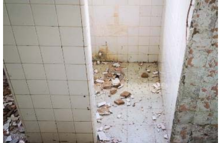
DESMONTE APARATOS SANITARIOS
