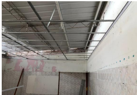
ESTRUCTURA DE CIELO RASO
