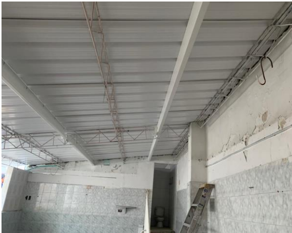
SUMINISTRO E INSTALACION DE ESTRUCTURA METALICA
