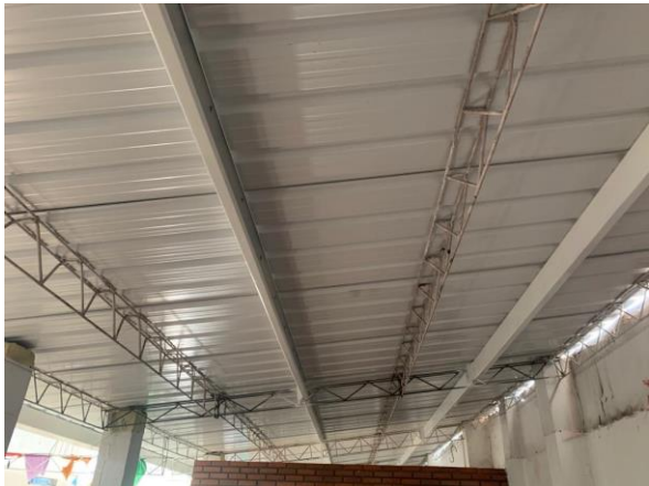
ESTRUCTURA METALICA Y CUBIERTA UPVC
