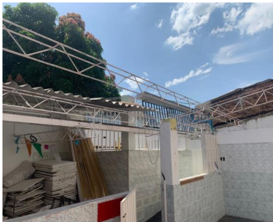
DESMONTE DE CUBIERTA
