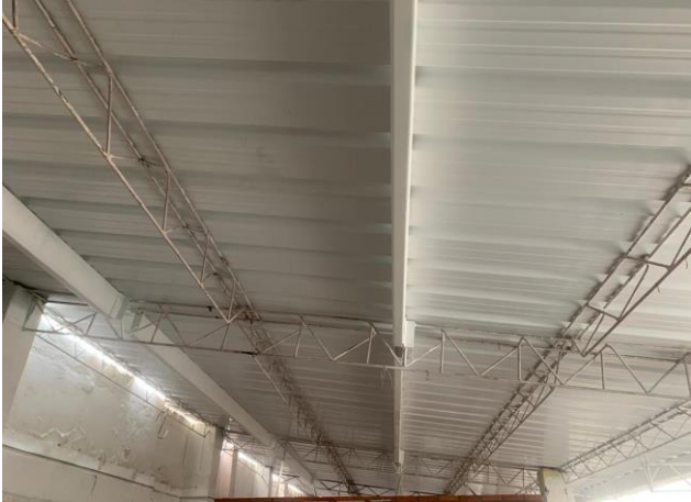
SUMINISTRO E INSTALACION DE ESTRUCTURA METALICA
