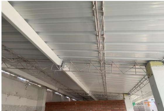
ESTRUCTURA METALICA Y CUBIERTA UPVC
