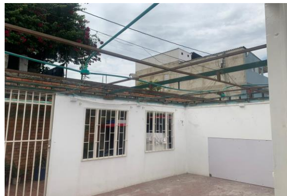
DESMONTE DE CUBIERTA
