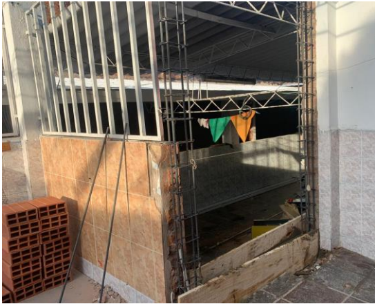
CONCRETO PARA COLUMNAS 3000 PSI (INCLUYE FORMALETA)
