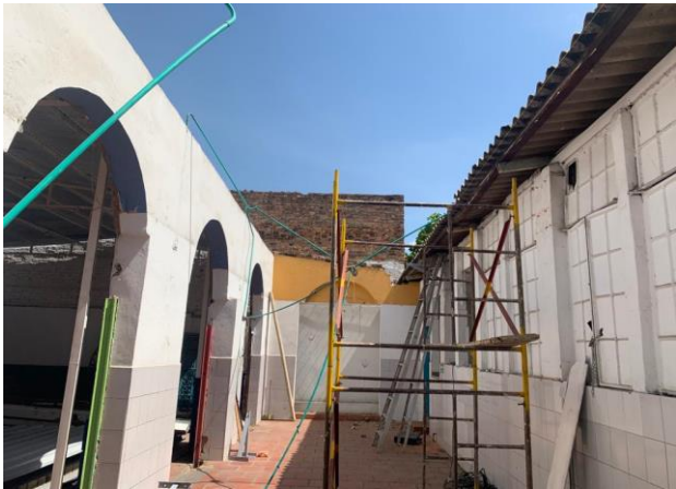
DESMONTE DE CANAL
