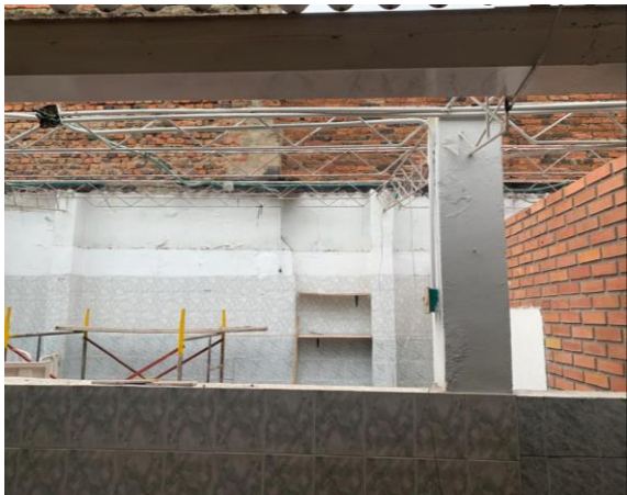
DESMONTE DE CUBIERTA
