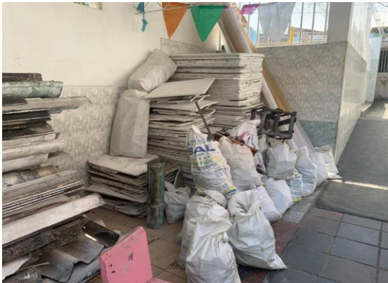
ACOPIO DE ESCOMBROS
