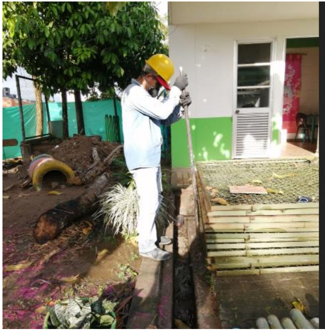
DEMOLICION CARCARMO EN CONCRETO
