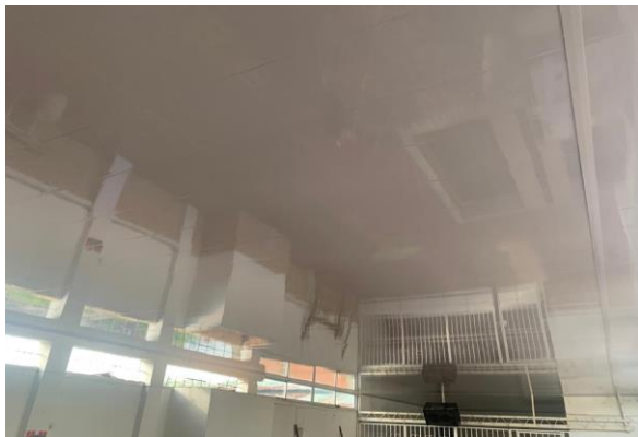
SUMINISTRO E INSTALACION DE CIELO RASO EN PVC
