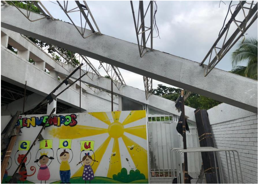
DESMONTE DE CIELO RASO FALSO
