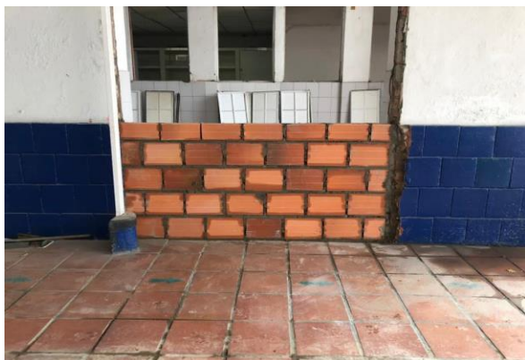
MURO EN BLOQUE DE ARCILLA
