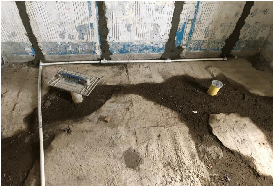
PUNTO DESAGUE PVC Ø 2" (INCLUYE ACCESORIOS)
