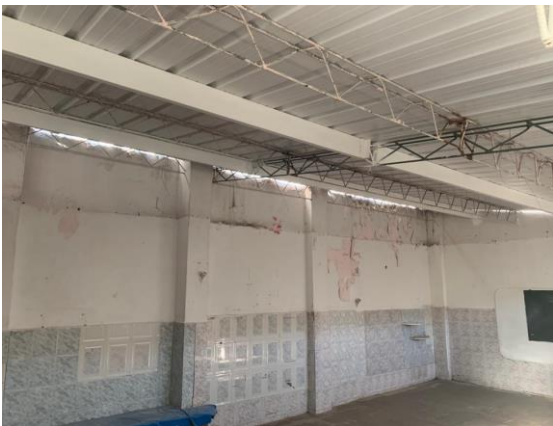
ESTRUCTURA METALICA Y CUBIERTA UPVC
