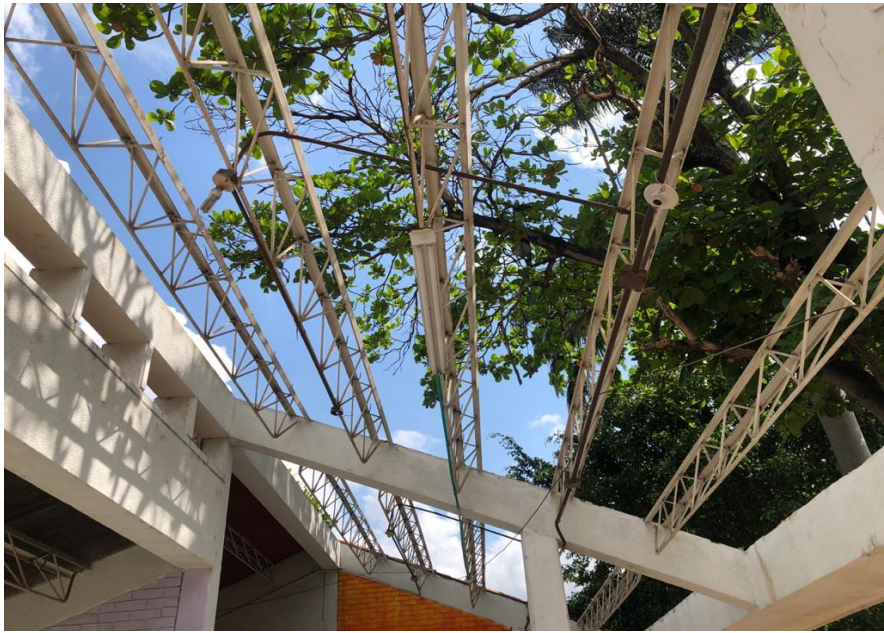
DESMONTE DE CIELO RASO FALSO
