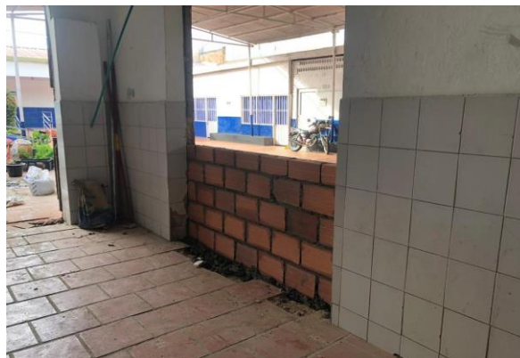
MURO EN BLOQUE DE ARCILLA
