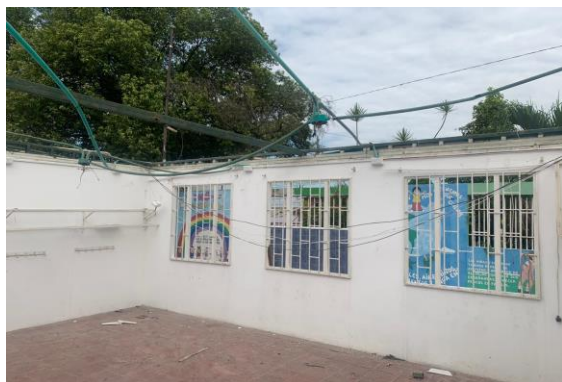
DESMONTE DE CUBIERTA
