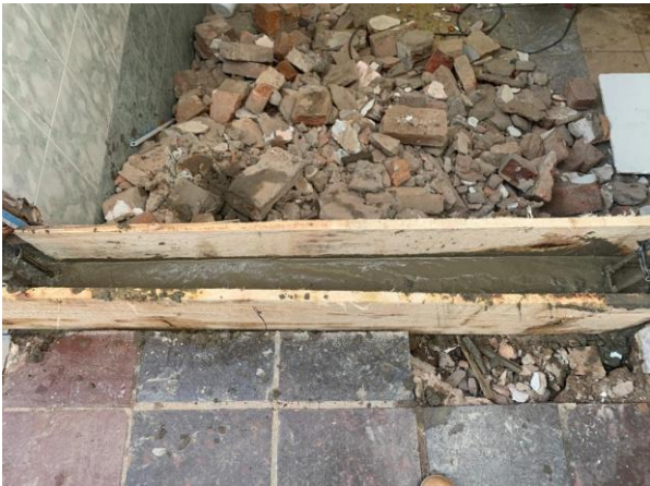
MURO LADRILLO ESTRUCTURAL E=0.12 cm, A LA VISTA- VIGA DE CIMENTACION
