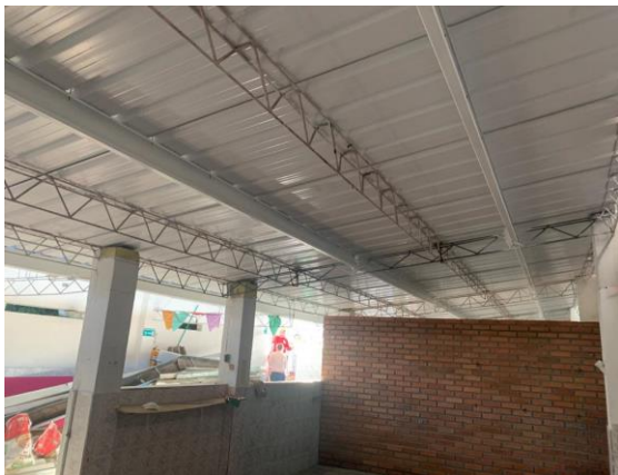
ESTRUCTURA METALICA Y CUBIERTA UPVC
