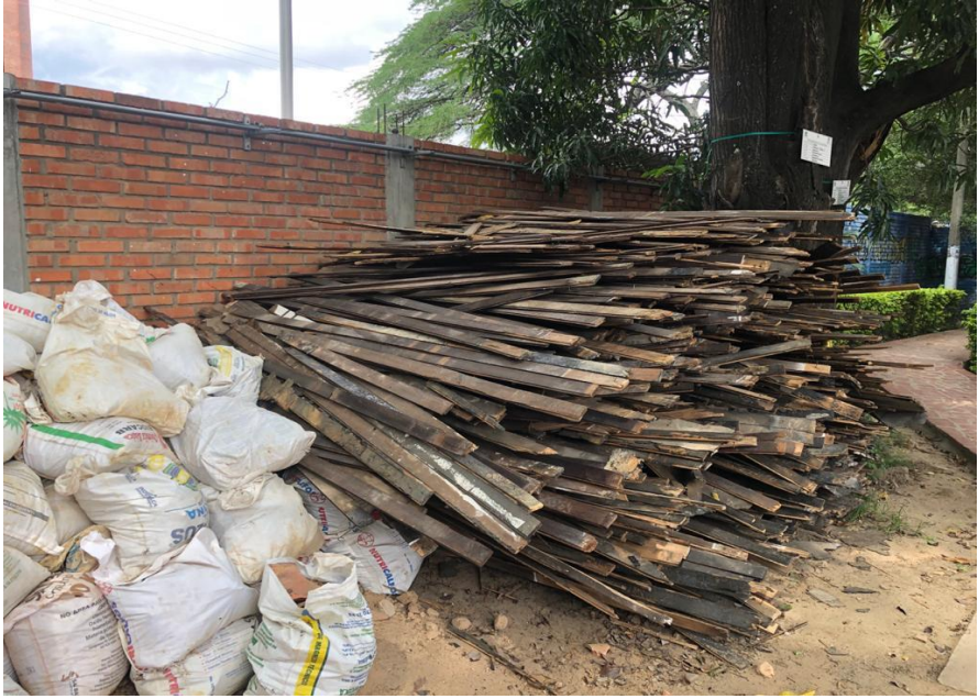
DESMONTE DE CIELO RASO FALSO
