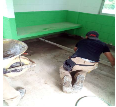
MORTERO DE NIVELACION ACCESO
