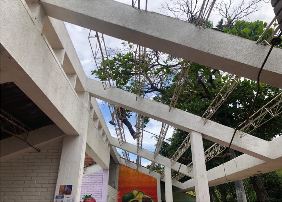
DESMONTE DE CIELO RASO FALSO
