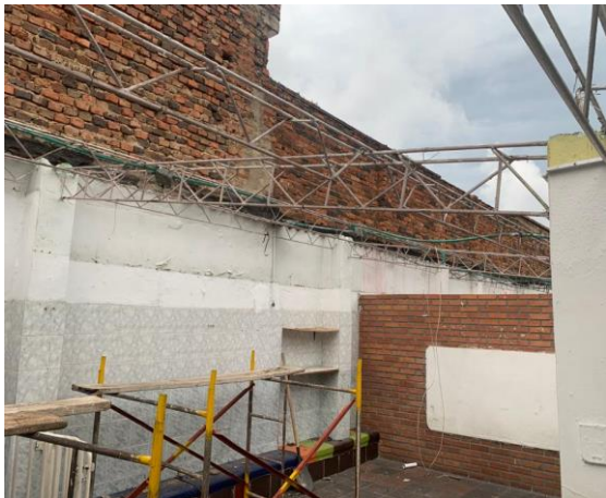
DESMONTE DE CUBIERTA
