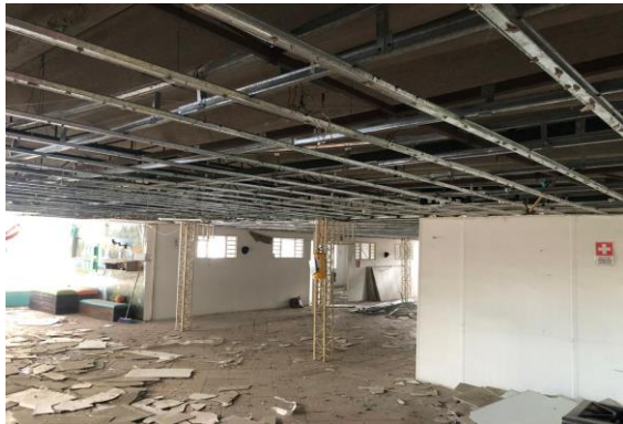
DESMONTE DE CIELO RASO
