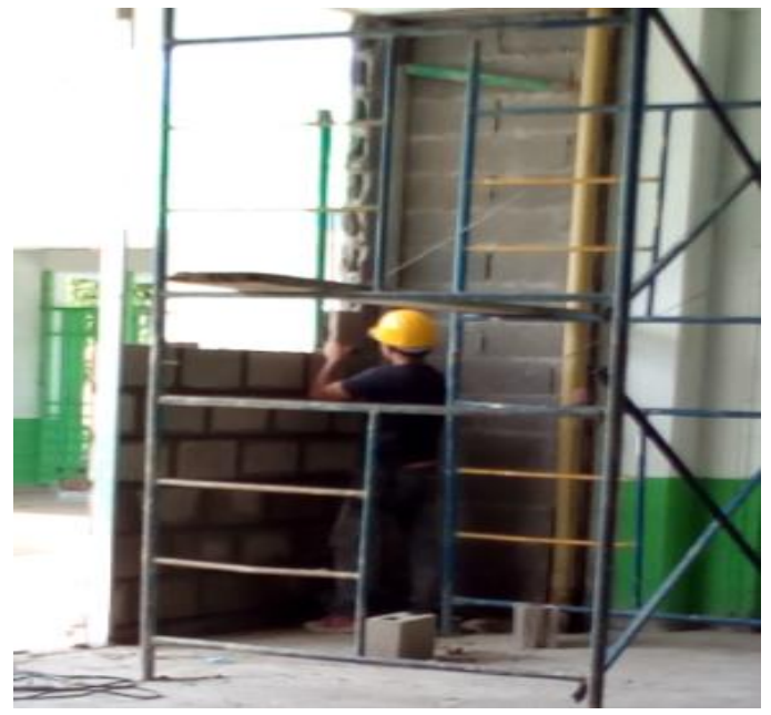
MAMPOSTERIA LADRILLO ESTRUCTURAL
