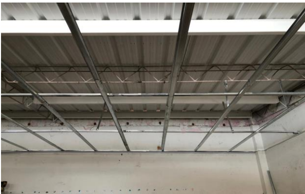
ESTRUCTURA DE CIELO RASO
