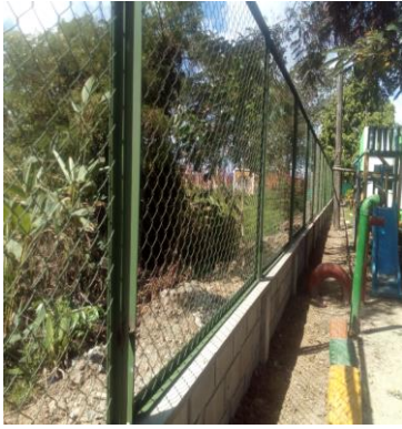
INSTALACION DE MALLA ESLABONADA
