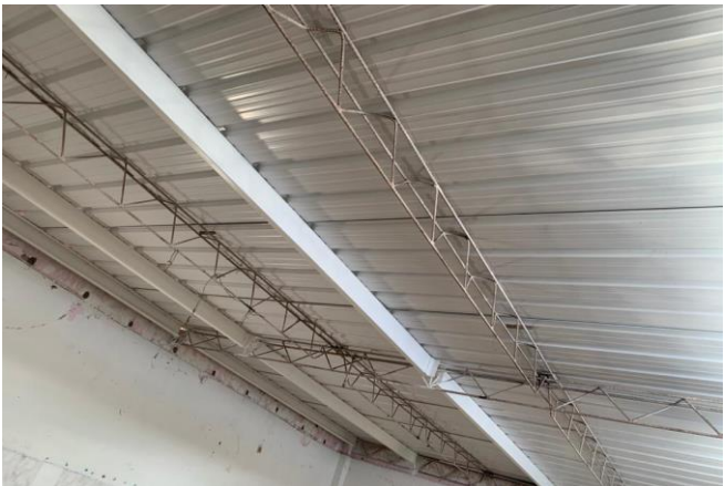
ESTRUCTURA METALICA Y CUBIERTA UPVC
