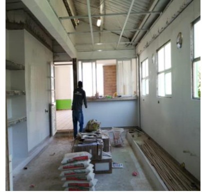
INSTALACION DE ENCHAPE DE MURO
