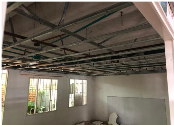
DESMONTE DE CIELO RASO
