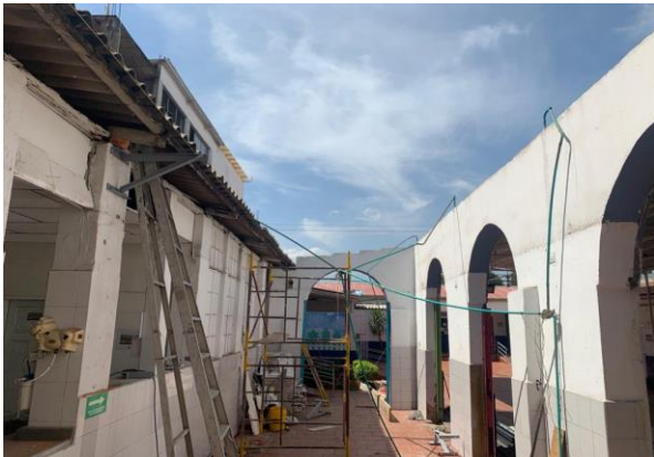
DESMONTE DE CUBIERTA
