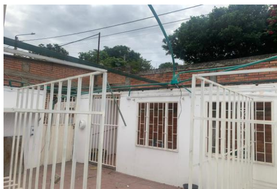
DESMONTE DE CUBIERTA
