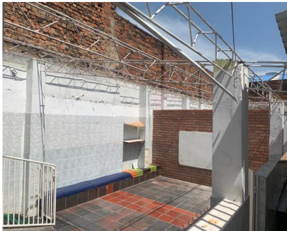
DESMONTE DE CUBIERTA
