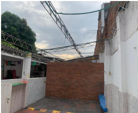
DESMONTE DE CUBIERTA
