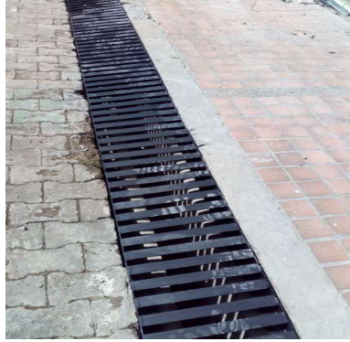
INSTALACION REJA EN HIERRO
