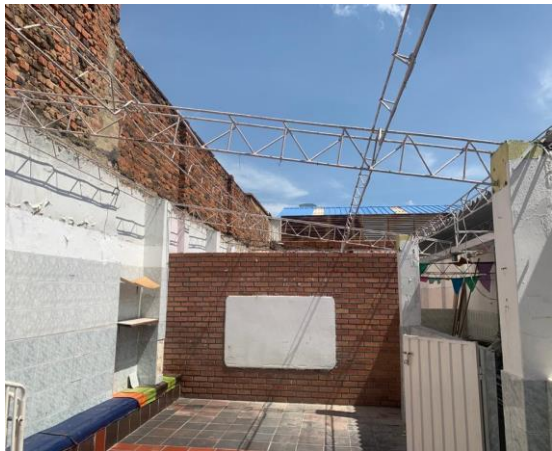
DESMONTE DE CUBIERTA
