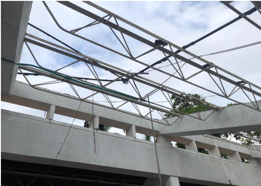
DESMONTE DE CIELO RASO FALSO
