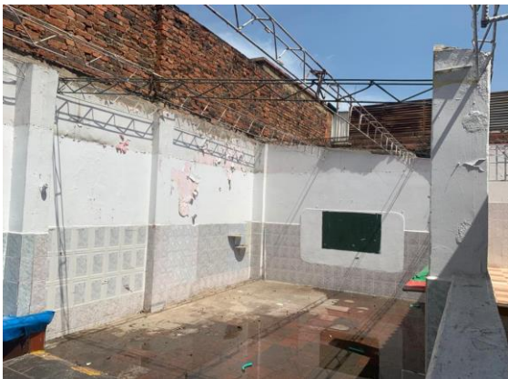
DESMONTE DE CUBIERTA
