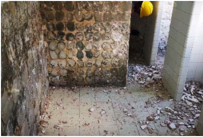
DESMONTE DE VENTANAS Y DEMOLICIÓN DE PAÑETE
