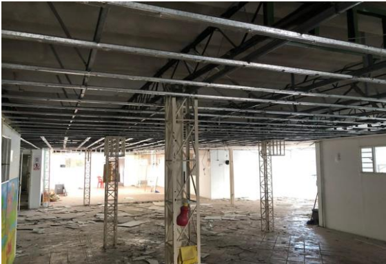
DESMONTE DE CIELO RASO
