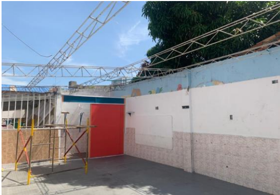
DESMONTE DE CUBIERTA
