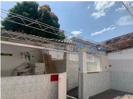
DESMONTE DE CUBIERTA
