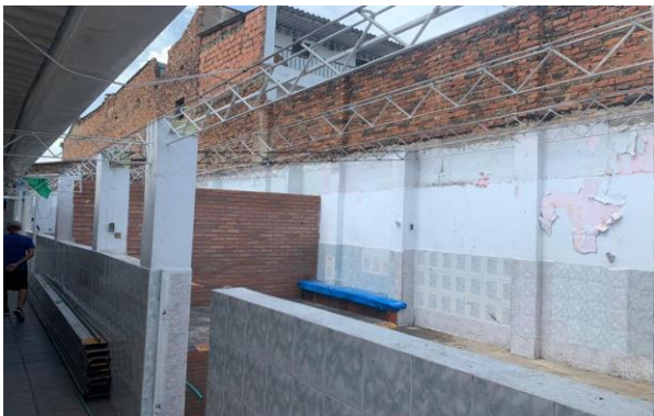
DESMONTE DE CUBIERTA
