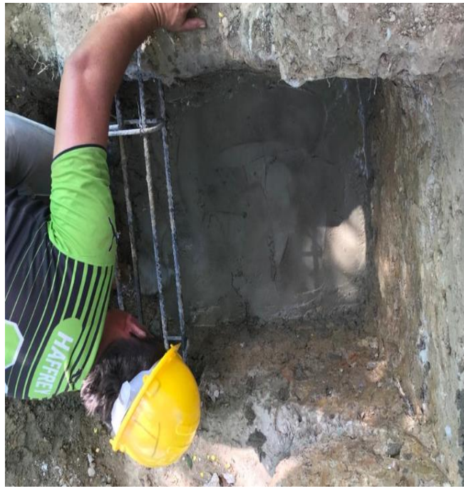
CONCRETO DE LIMPIEZA
