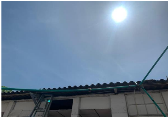
DESMONTE DE CUBIERTA
