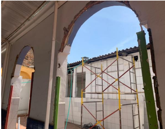
DESMONTE DE CANAL
