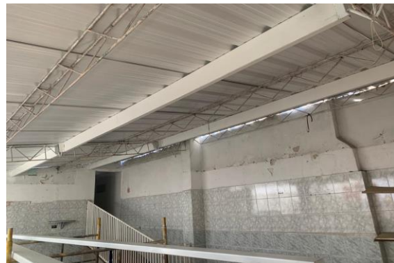
ESTRUCTURA METALICA Y CUBIERTA UPVC
