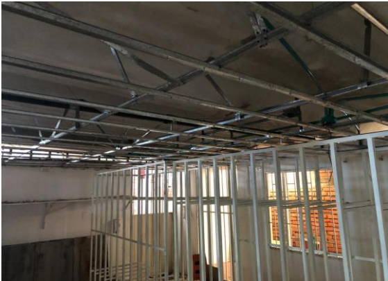
DESMONTE DE CIELO RASO
