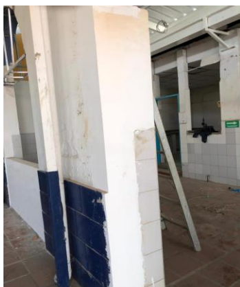
ESTUCO SOBRE MUROS
