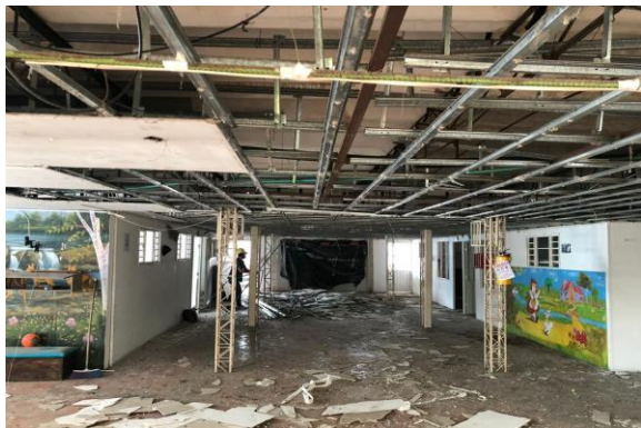
DESMONTE DE CIELO RASO
