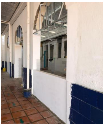
ESTUCO SOBRE MUROS
