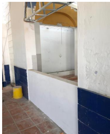
ESTUCO SOBRE MUROS
