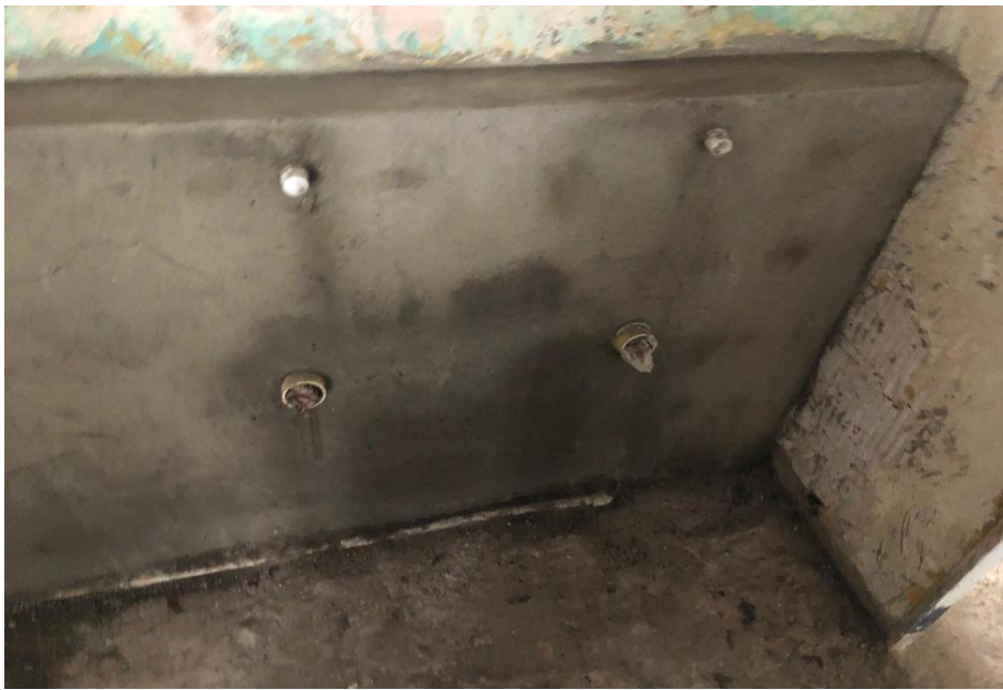
PUNTO DESAGUE PVC Ø 2" (INCLUYE ACCESORIOS)
