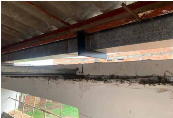
SUMINISTRO E INSTALACION DE SOPORTE PARA CANAL METALICA RAINING
