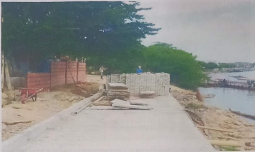
IMAGEN 5: VISITA OBRA GAVIONES FERRY
