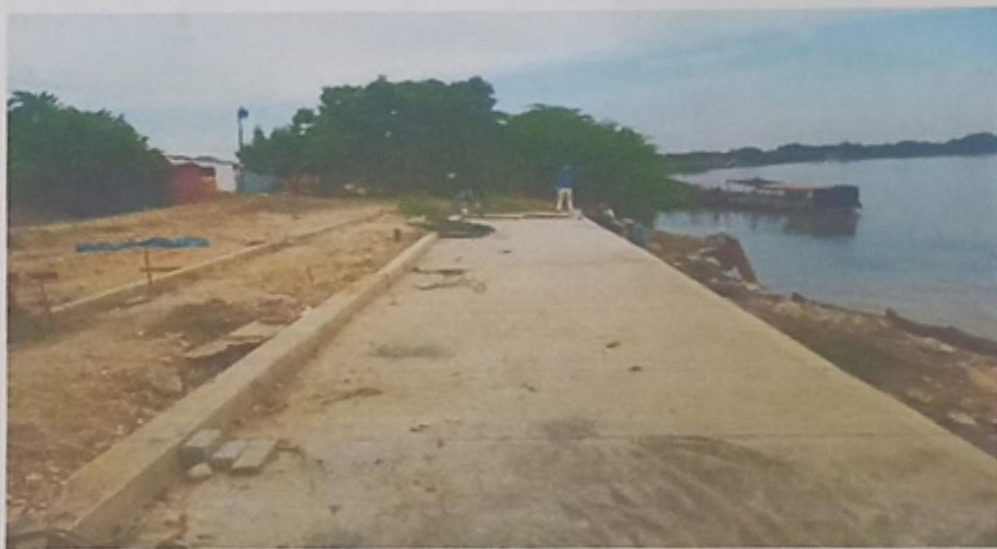
IMAGEN 6: VISITA OBRA GAVIONES FERRY
