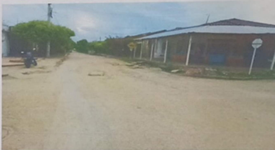
IMAGEN 8: INSPECCION OCULAR VIA BARRIO EL CARMEN
