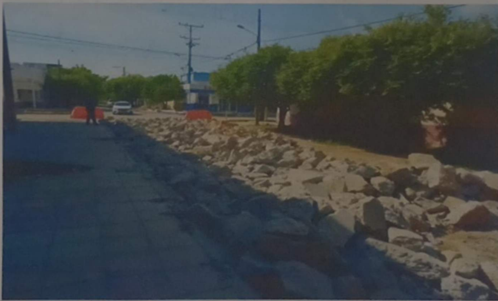
IMAGEN 2: VISITA A OBRA PAVIMENTO BARRIO FATIMA
