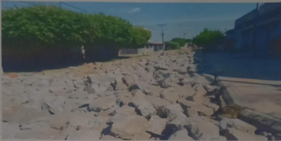
IMAGEN 1: VISITA A OBRA PAVIMENTO BARRIO FATIMA
