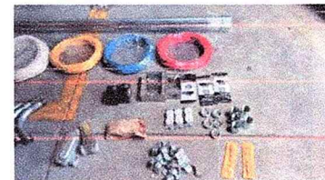
Fotografía 15 Cables, tomas dobles, cajas, conduletas, abrazaderas y brocas
