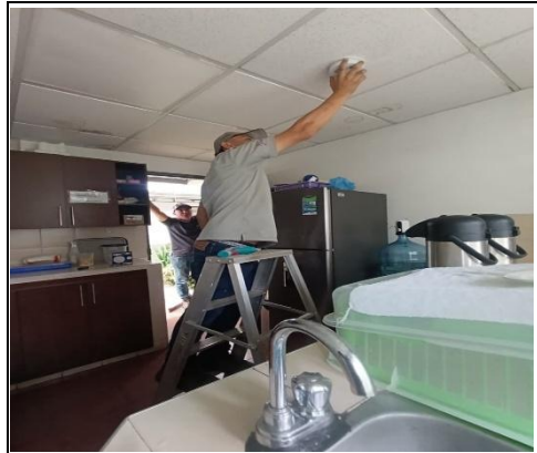
INSTALACION COCINA FINANCIERA
