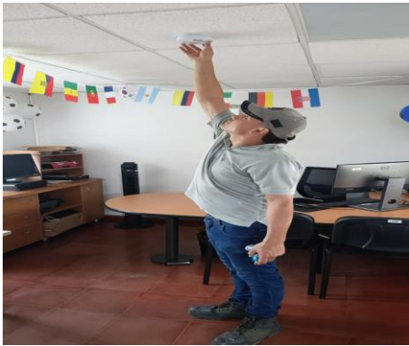
INSTALACION OF. ING ARIEL
