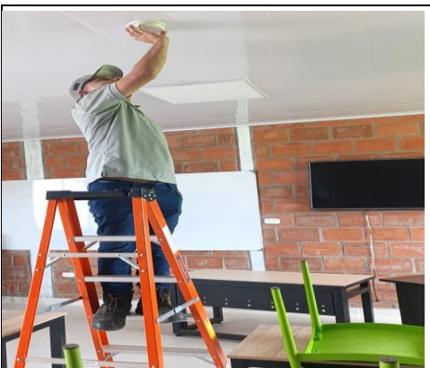
INSTALACION AMBIENTE NUEVO 2
