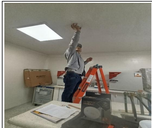
INSTALACION CIENCIAS BASICAS
