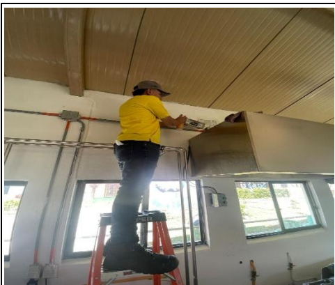
MANTENIMIENTO LAMPARAS DE EMERGENCIA
