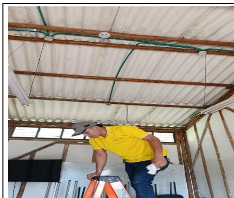
INSTALACION BODEGA GRANJA
