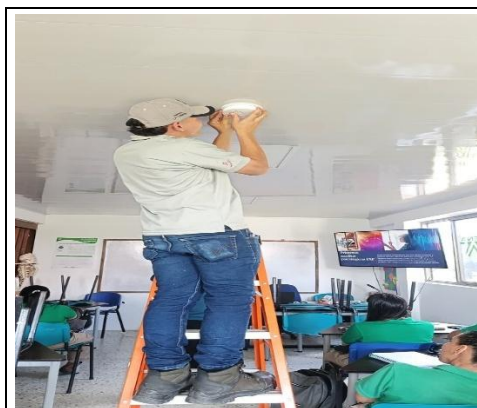
INSTALACION AMBIENTE SST 2
