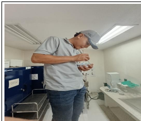
MANTENIMIENTO SENSORES DE HUMO
