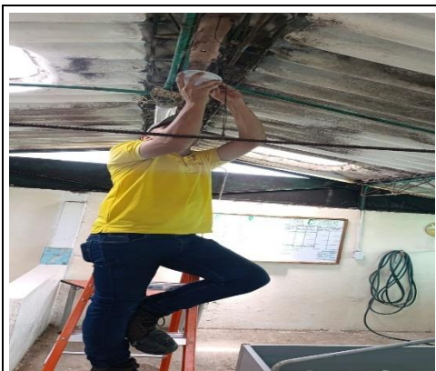
INSTALACION UNIDAD PORCINA
