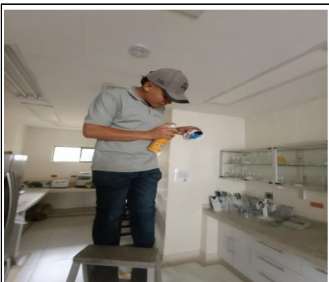
MANTENIMIENTO SENSORES DE HUMO
