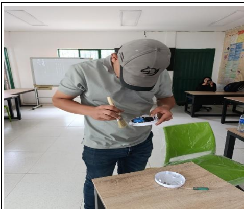
MANTENIMIENTO SENSORES DE HUMO
