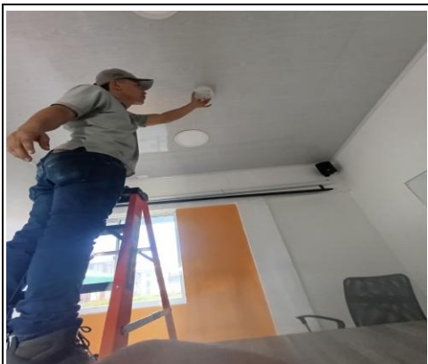
INSTALACION SALA DE INSTRUCTORES
