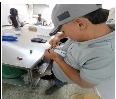
MANTENIMIENTO SENSORES DE HUMO
