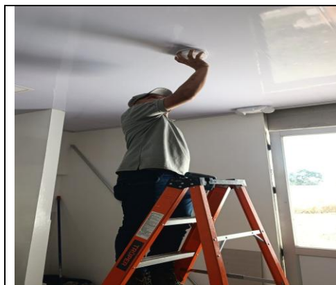
INSTALACION CAFETERIA AGRICOLA
