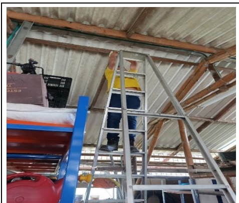
INSTALACION BODEGA UNIDAD FLORES
