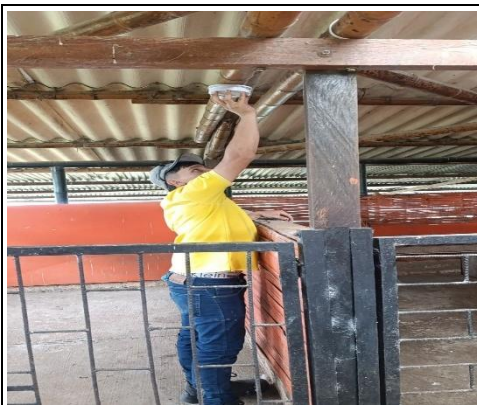
INSTALACION UNIDAD OVINA
