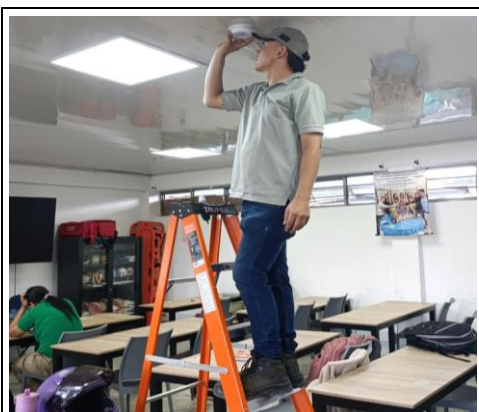
INSTALACION AMBIENTE SST 1
