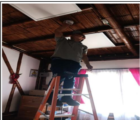
INSTALACION ADMINISTRACION FINCA
