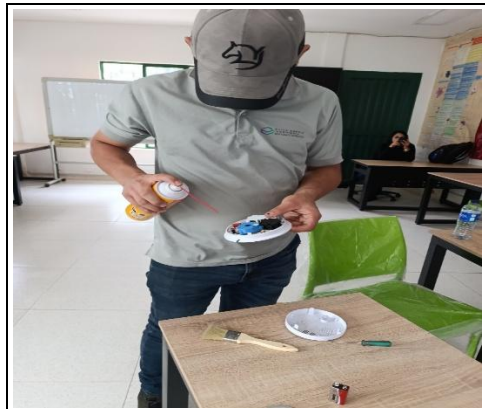
MANTENIMIENTO SENSORES DE HUMO
