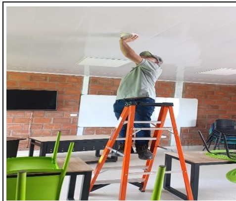
INSTALACION AMBIENTE NUEVO 3
