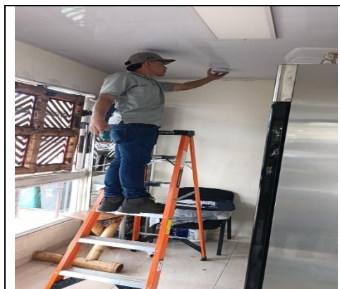
INSTALACION TIENDA FRUTAS Y FLORES
