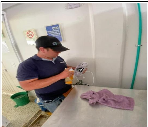
MANTENIMIENTO LAMPARAS DE EMERGENCIA
