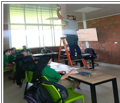
INSTALACION AMBIENTE NUEVO 1
