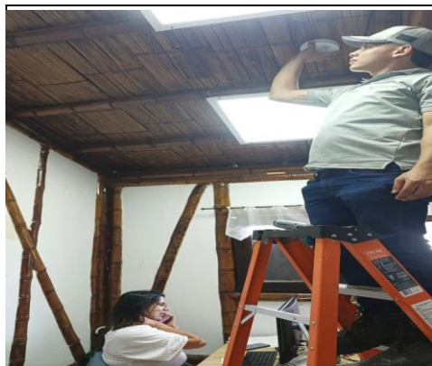
INSTALACION ADMINISTRACION FINCA
