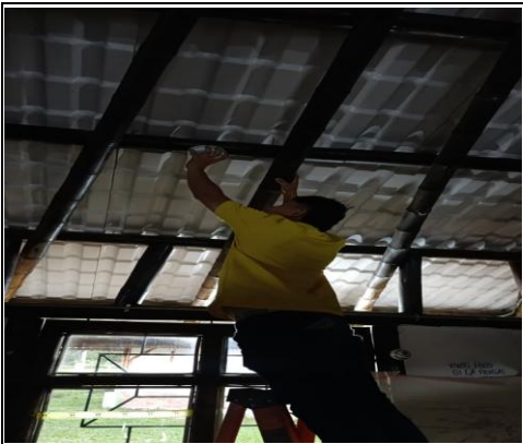
INSTALACION AMBIENTE HEXAGONAL
