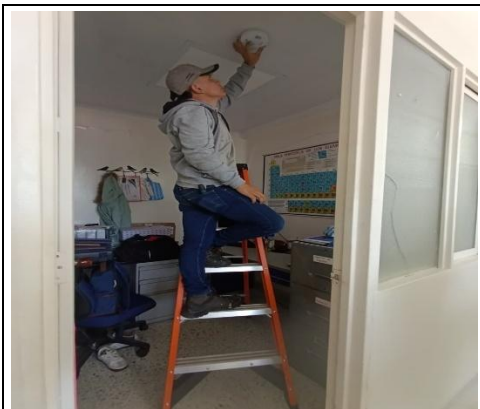
INSTALACION CIENCIAS BASICAS
