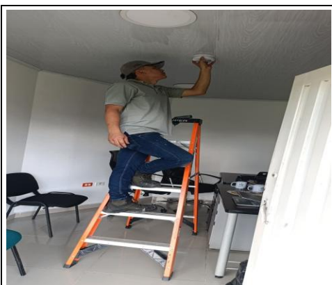
INSTALACION CONSULTORIO EMPRESARIAL
