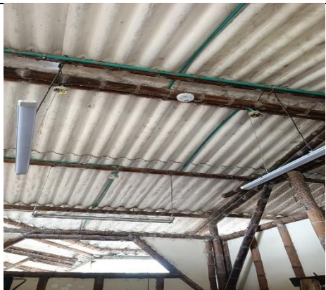
INSTALACION BODEGA GRANJA
