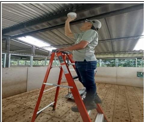
INSTALACION AMBIENTE CAPRINOS
