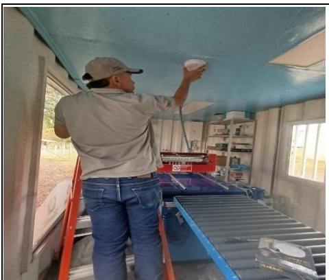
INSTALACION AREA IILA
