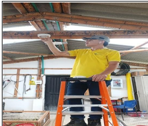
INSTALACION UNIDAD CUYICULA
