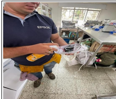
MANTENIMIENTO LAMPARAS DE EMERGENCIA
