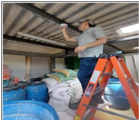
INSTALACION MAQUINARIA DE PELADORAS
