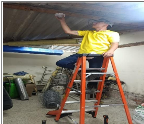
INSTALACION UNIDAD OVINA
