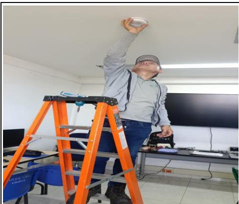
INSTALACION LABORATORIO DE ANALISIS
