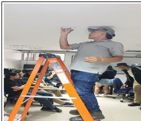
INSTALACION AMBIENTE TICS 2
