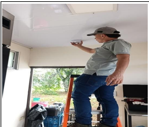
INSTALACION TIENDA FRUTAS Y FLORES
