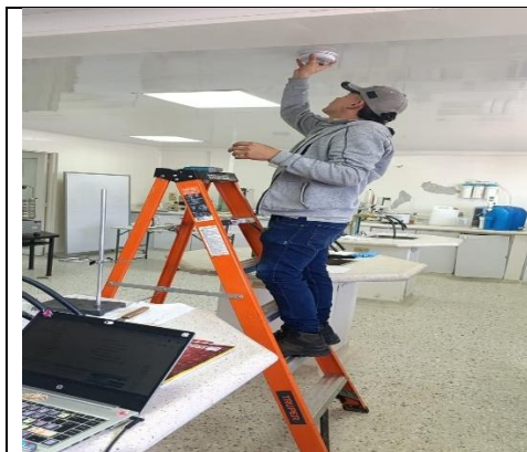
INSTALACION CIENCIAS BASICAS
