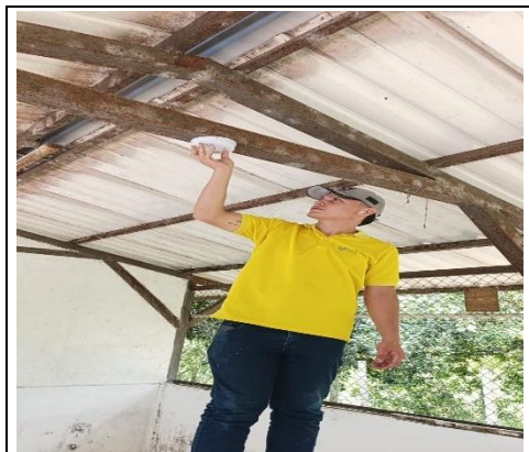
INSTALACION UNIDAD PORCINA 2
