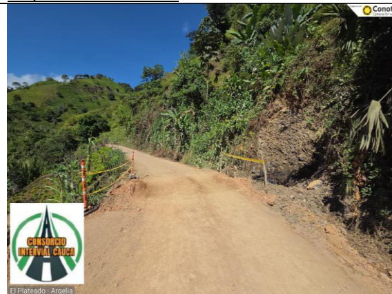
Fotografía 3: Excavaciones para Explanaciones, Ampliación de la Banca
