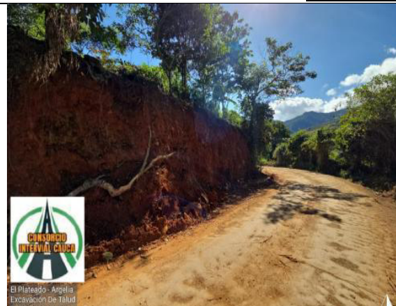
Fotografía 3: Excavaciones para Explanaciones, Ampliación de la Banca
