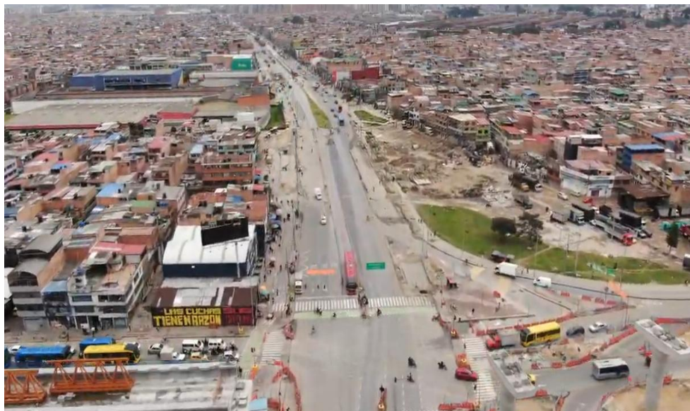
Ilustración 25. Estado obras ejecutadas, vuelo en Dron 16 de octubre de 2025-9
