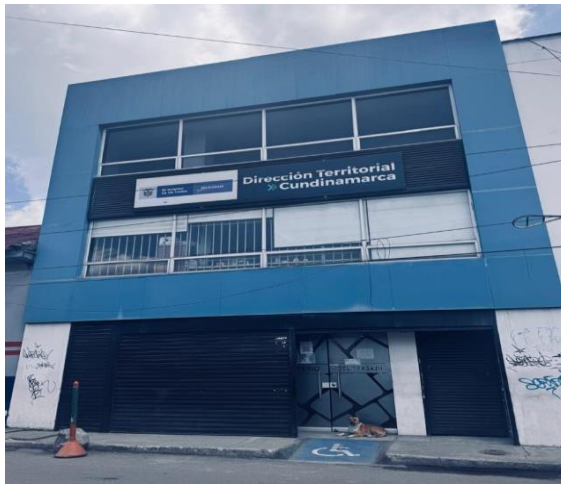
Foto 25 cortina enrollable para mantenimiento
