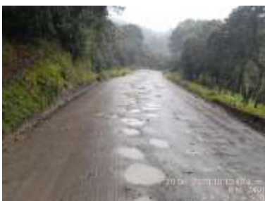
PR21+0049, PR23+0320, PR30+0740 Sectores con cabezas duras y baches generalizados.
