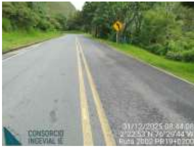
PR19+0200, PR24+0000 y PR25+0900 Sector con pavimento flexible en buen estado. Requiere la renovación de la señalización horizontal.
