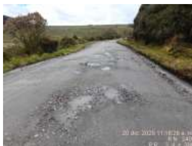
PR34+0380, PR46+0420, PR54+0600 Sectores con baches generalizados y cabezas duras.
