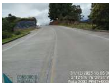
PR36+0400, PR47+0000 y PR50+0100 Pavimento rígido, presenta buena transitabilidad. Requiere renovación de la señalización horizontal e instalación de señalización vertical faltante.
