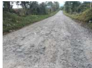
PR34+0380, PR46+0420, PR54+0600 Sectores con baches generalizados y cabezas duras.
