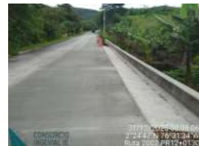
PR12+0130 al PR12+0190, losas del carril derecho.
