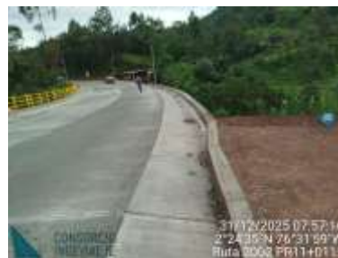
PR11+0115 al PR11+0200 Cuneta
