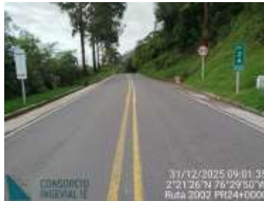
PR19+0200, PR24+0000 y PR25+0900 Sector con pavimento flexible en buen estado. Requiere la renovación de la señalización horizontal.
