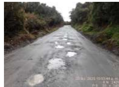
PR21+0049, PR23+0320, PR30+0740 Sectores con cabezas duras y baches generalizados.
