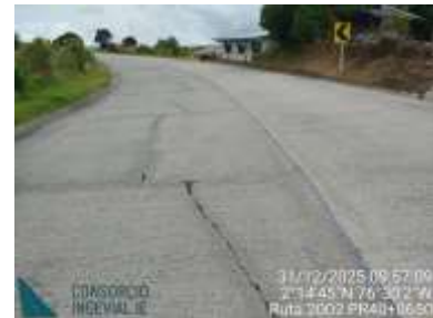
PR30+0960, PR36+0300 y PR40+0650 Pavimento rígido con grietas sectorizadas. Deficiente señalización.
