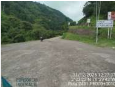
PR00+0010, PR00+0570 y PR01+0780 Sectores en afirmado con baches y cabezas duras.
