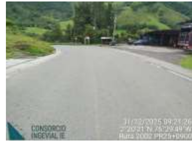
PR19+0200, PR24+0000 y PR25+0900 Sector con pavimento flexible en buen estado. Requiere la renovación de la señalización horizontal.
