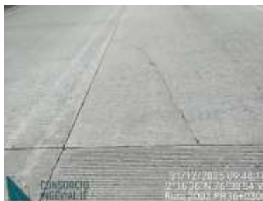
PR30+0960, PR36+0300 y PR40+0650 Pavimento rígido con grietas sectorizadas. Deficiente señalización.
