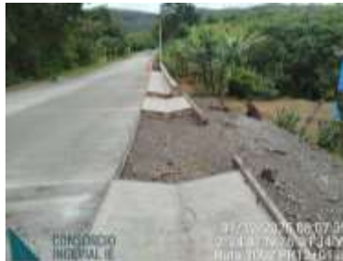
PR12+0140 al PR12+0155, cuneta del carril derecho.
