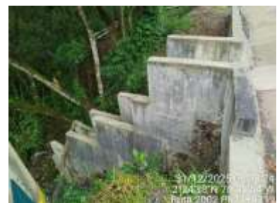
PR11+0319 Disipador, carril izquierdo.
