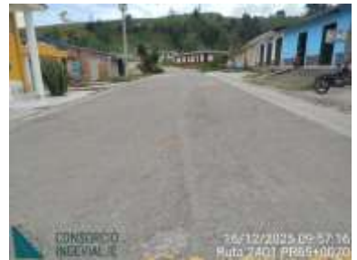
PR07+0040, PR08+0500, PR65+0070 sectores con baches, descascamientos y grietas.
