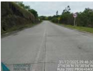
PR36+0400, PR47+0000 y PR50+0100 Pavimento rígido, presenta buena transitabilidad. Requiere renovación de la señalización horizontal e instalación de señalización vertical faltante.
