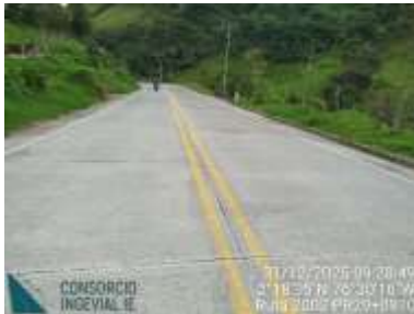
PR29+0910, PR30+0650, PR34+0150 Sector de pavimento rígido, presenta buena transitabilidad. Requiere renovación de la señalización horizontal e instalación de señalización vertical faltante.
