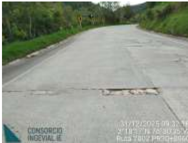
PR30+0960, PR36+0300 y PR40+0650 Pavimento rígido con grietas sectorizadas. Deficiente señalización.
