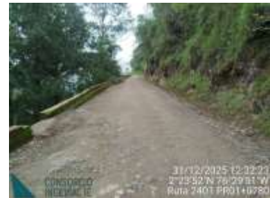
PR00+0010, PR00+0570 y PR01+0780 Sectores en afirmado con baches y cabezas duras.
