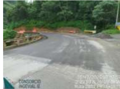
PR17+0875 al PR17+0910, sobre la losa del pontón.
