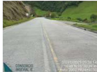
PR29+0910, PR30+0650, PR34+0150 Sector de pavimento rígido, presenta buena transitabilidad. Requiere renovación de la señalización horizontal e instalación de señalización vertical faltante.
