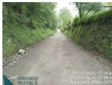
PR00+0010, PR00+0570 y PR01+0780 Sectores en afirmado con baches y cabezas duras.
