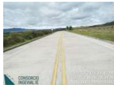
PR36+0400, PR47+0000 y PR50+0100 Pavimento rígido, presenta buena transitabilidad. Requiere renovación de la señalización horizontal e instalación de señalización vertical faltante.
