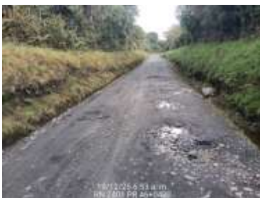
PR34+0380, PR46+0420, PR54+0600 Sectores con baches generalizados y cabezas duras.
