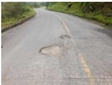
PR07+0040, PR08+0500, PR65+0070 sectores con baches, descascamientos y grietas.
