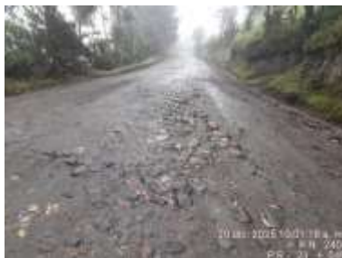
PR21+0049, PR23+0320, PR30+0740 Sectores con cabezas duras y baches generalizados.
