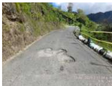
PR07+0040, PR08+0500, PR65+0070 sectores con baches, descascamientos y grietas.
