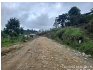
PR12+0000, PR14+0000, PR17+0000, sectores en mal estado, con daños como cabezas duras, pérdida de material granular y baches.
