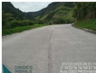
PR29+0910, PR30+0650, PR34+0150 Sector de pavimento rígido, presenta buena transitabilidad. Requiere renovación de la señalización horizontal e instalación de señalización vertical faltante.
