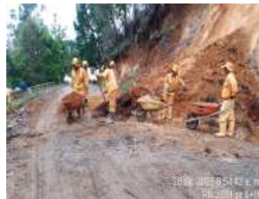
DURANTE PR06+0400 Despeje de derrumbe
