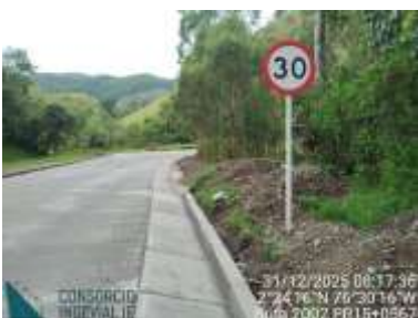
PR15+0500 al PR15+0690 Cuneta
