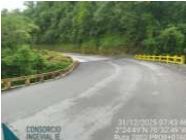
PR08+0160 al PR08+0230, sobre la losa del puente
