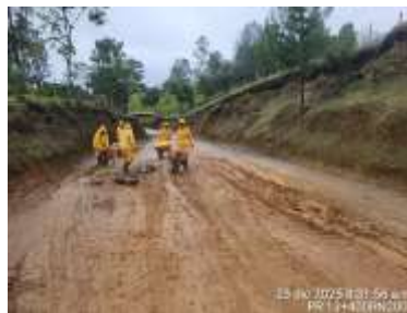
DURANTE PR13+0400 Bacheo en afirmado
