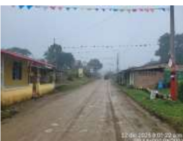
PR12+0000, PR14+0000, PR17+0000, sectores en mal estado, con daños como cabezas duras, pérdida de material granular y baches.
