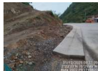
PR17+0600 al PR17+0870 carril derecho, cuneta.
