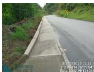
PR17+0480 al PR17+0860 del carril izquierdo, cuneta.
