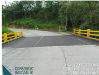
PR14+0637 al PR14+0647, sobre la losa del pontón.
