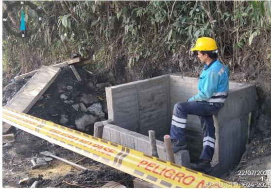
Imagen 1. Vaciado de concreto para encofe de alcantarilla K1+061 en tramo 2.
