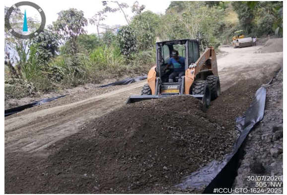
Imagen 2. Instalación de geotextil para colocación de subbase granular en tramo 2.
