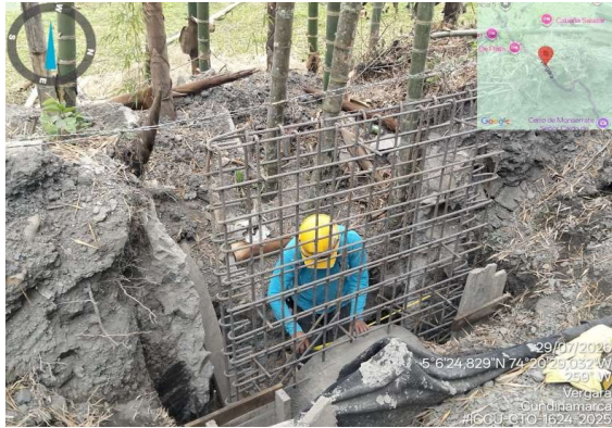
Imagen 1. Armado de acero para descoles de alcantarillas K0+925 y K1+061 en tramo 2.
