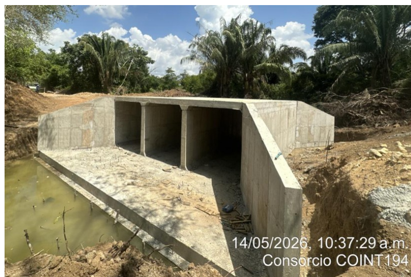
Estado actual box coulvert triple (K3+220)
