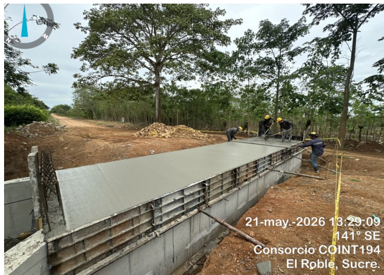
Estado actual box culvert 2.5X1 (K2+275)
