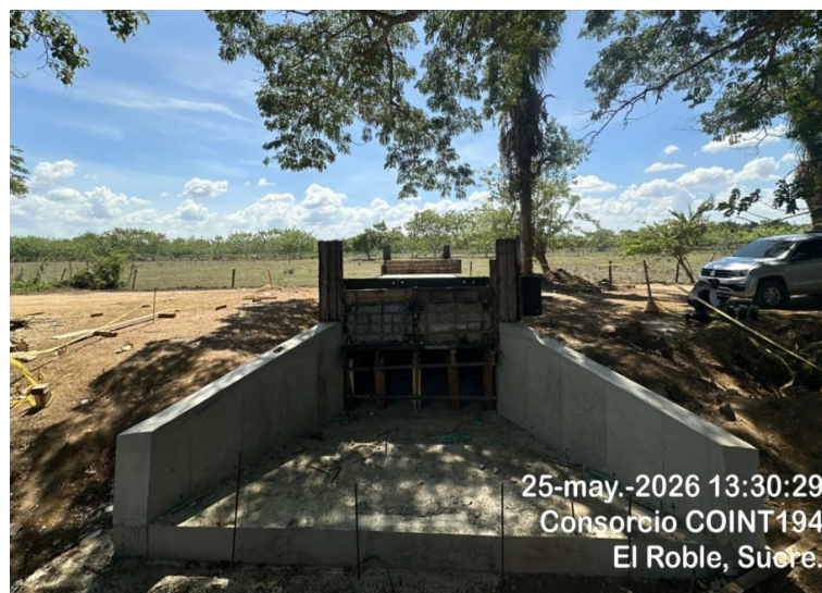
Estado actual box culvert 2X1 (K2+570)
