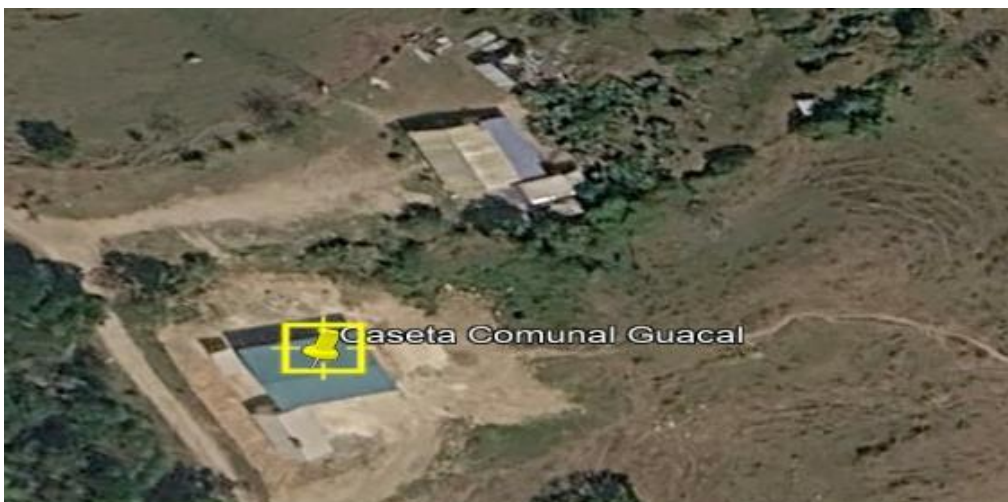
Imagen 4. construcción de zonas comunales cocina, bodega, unidad sanitaria y salón en la vereda Guacal, 5°36'29" N, 72°28'39" O.
