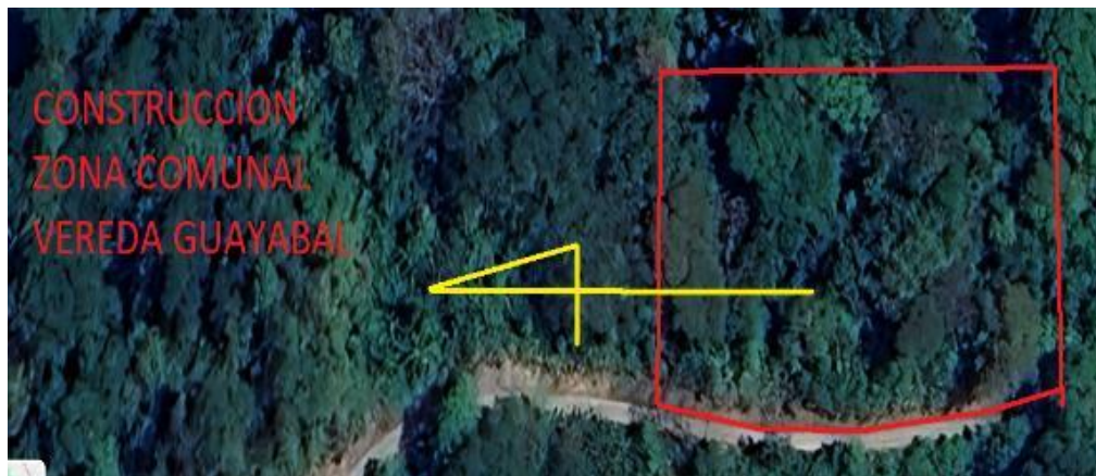
Imagen 2. construcción de zonas comunales cocina, bodega, unidad sanitaria y salón en la vereda Guayabal 5°36'40" N, 72°19'57" O.
