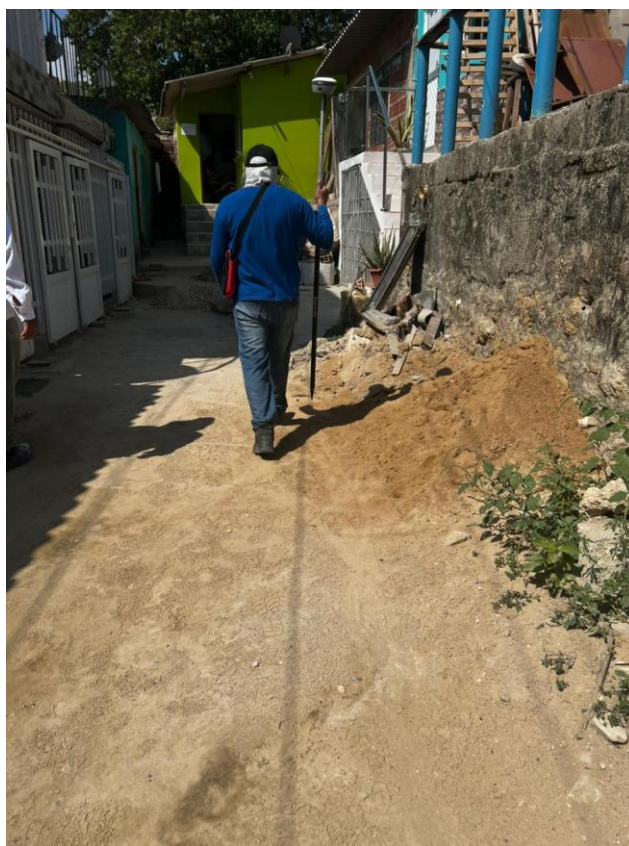
Imagen 5. Calle 18 entre carreras 5A y 3ª
