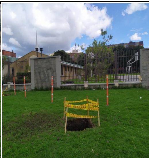
Foto No. 2. Señalización transitoria del ahoyado realizado, esta se retira una vez se llenan los ahoyados.
