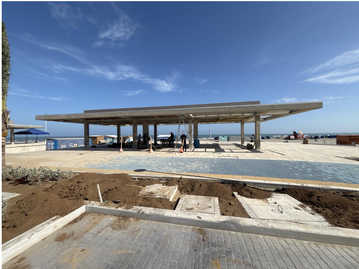
Chiringuito No. 1: estructura y cubierta con trabajos de acabados e instalaciones.
