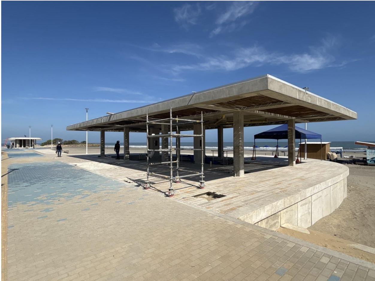
Chiringuito No. 2: estructura terminada y acabados superiores en ejecución.
