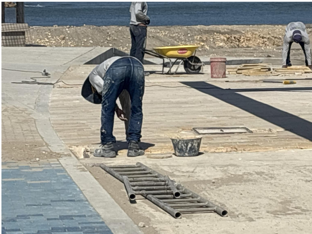
Trabajos de preparación e instalación de acabados exteriores en el Chiringuito No. 3.
