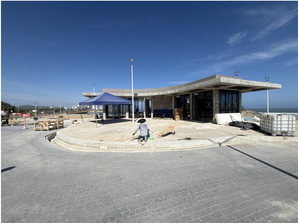
Centro de Atención al Turista: fachadas en vidrio y trabajos de mármol exterior.
