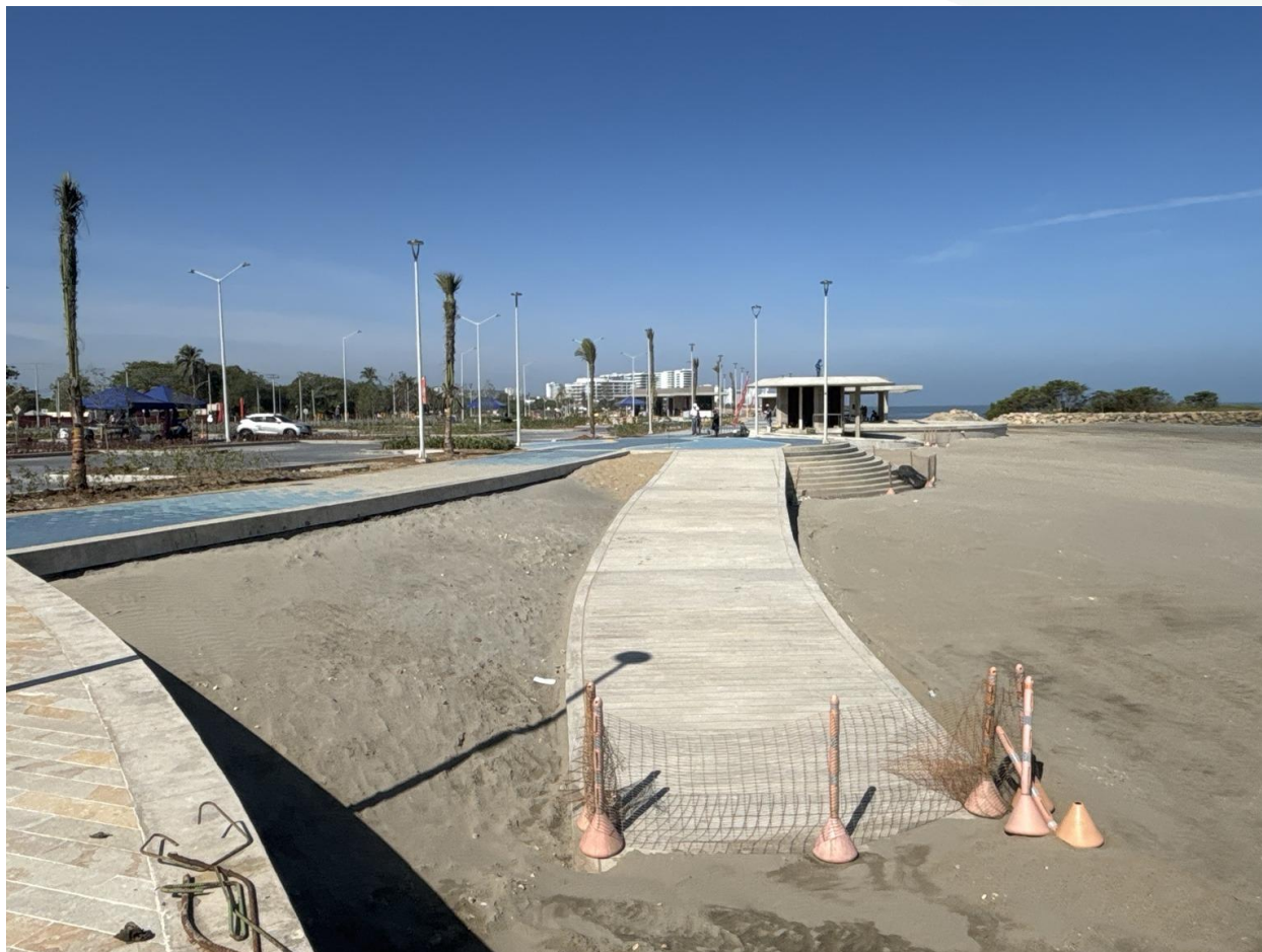
Rampa de acceso a la playa y escalinatas completamente ejecutadas.
