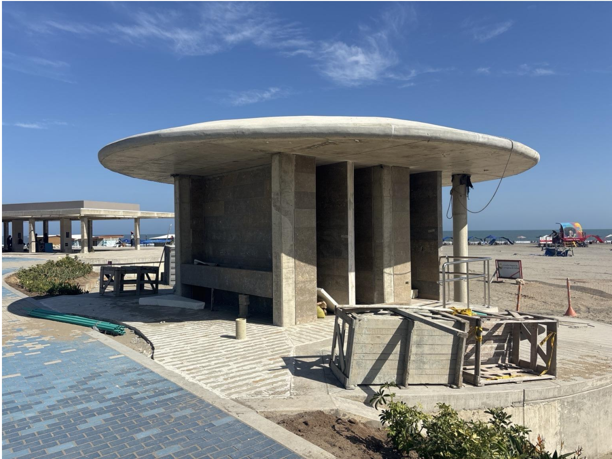
Baño público No. 1: estructura terminada, enchapes y revestimientos exteriores ejecutados.
