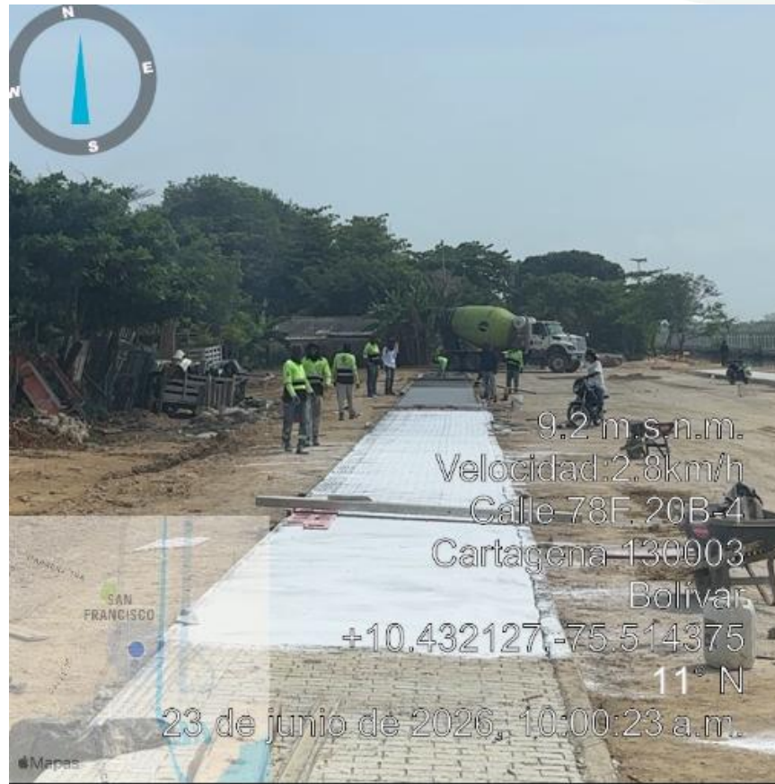
Fotografía No 2 andenes y bordillos
