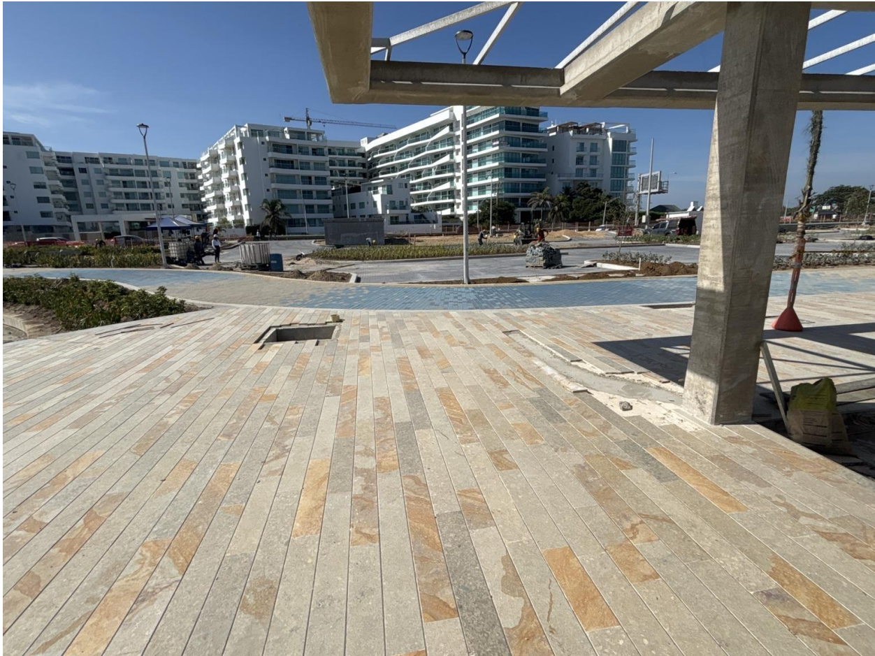
Vista interior del Chiringuito No. 1 y relación con el sendero y paisajismo.
