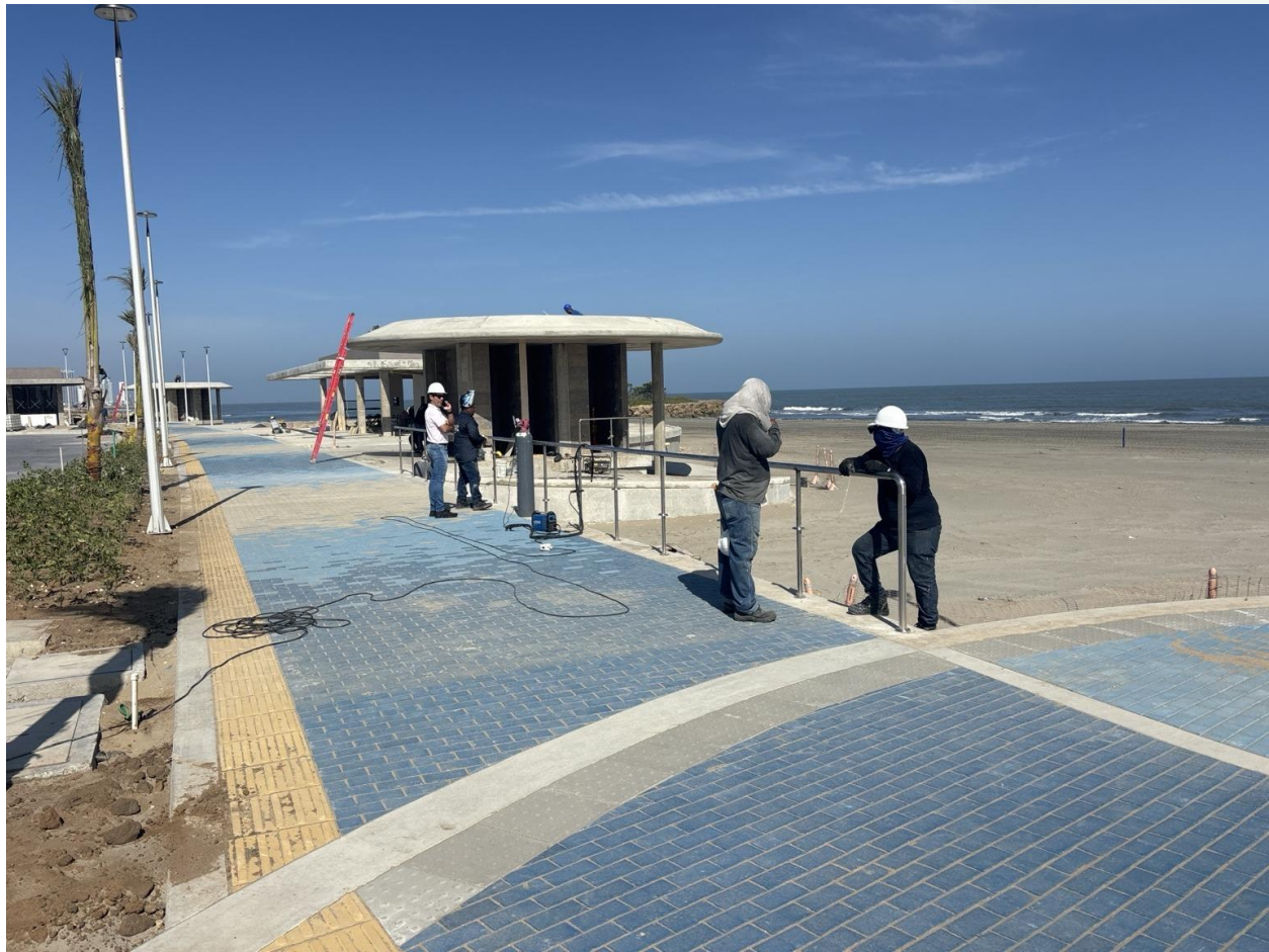
Instalación de barandas metálicas en la rampa de acceso del sector de la tortuga.
