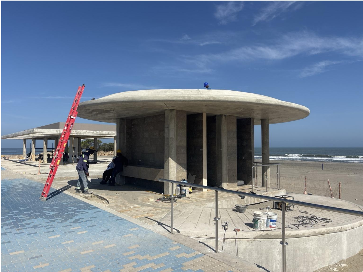
Baño público No. 2 con pasamanos en instalación y actividades sobre la cubierta.
