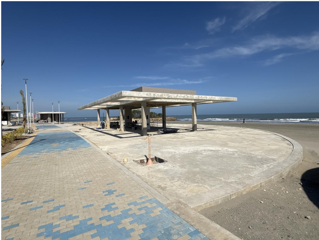
Chiringuito No. 3: estructura terminada y plazoleta exterior pendiente de revestimiento.
