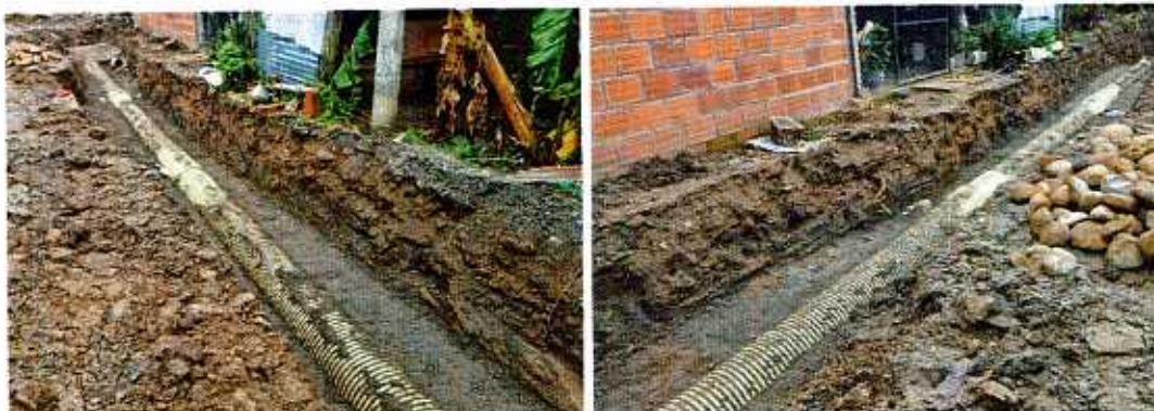
IMAGEN 9. RELLENO ZONA DE ATRAQUE DE TUBERÍA CON MATERIAL BASE GRANULAR TRITURADA (TAMAÑO MÁXIMO 1 1/2").
