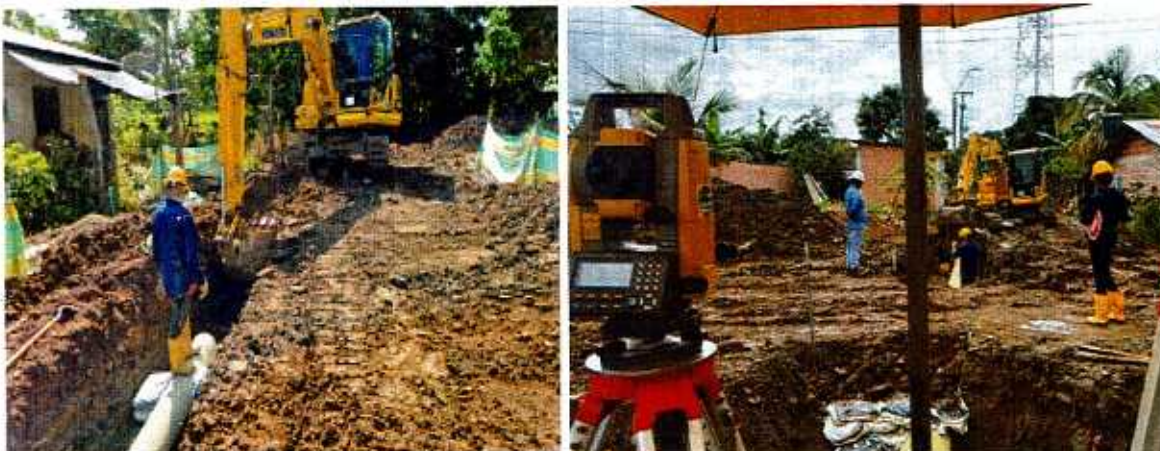
IMAGEN 7. EXCAVACIÓN MECÁNICA EN MATERIAL COMÚN 0 - 6 M (ÁREA RESTRINGIDA).
