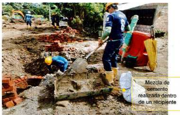
Fotografía 6.22. Mezcla de cemento realizada dentro de un recipiente para evitar contacto directo con el recurso suelo.
