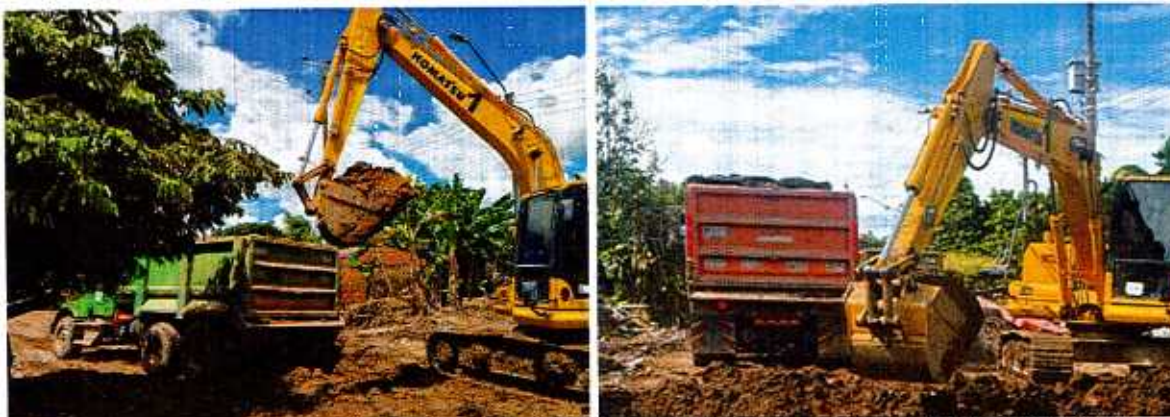
IMAGEN 11. CARGUE Y RETIRO MECÁNICO DE MATERIAL, CON ACARREO A 6 KMS.
