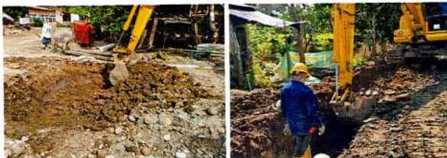
MAGEN 14. EXCAVACIÓN MECÁNICA EN MATERIAL COMÚN 0 - 6 M (ÁREA RESTRINGIDA).
