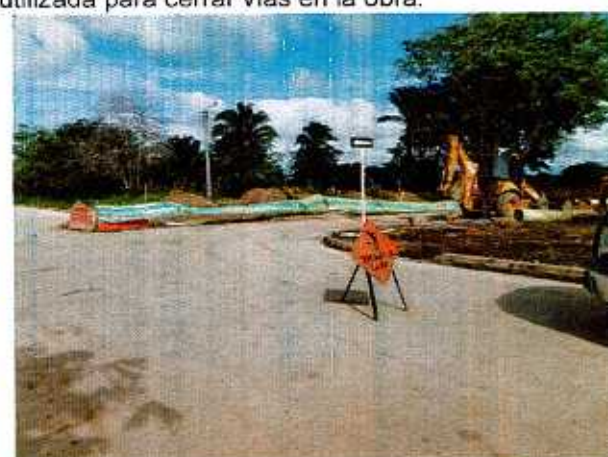
Fotografías 6.15. Señalización implementada en la obra.
