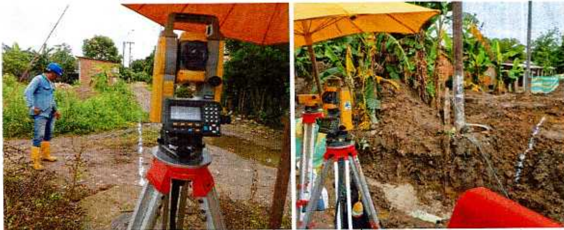
IMAGEN 6. REPLANTEO Y LOCALIZACIÓN DE TUBERÍAS DE ALCANTARILLADO.
