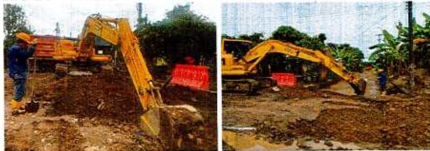
IMAGEN 16. EXCAVACIÓN DE CORTES, CANALES Y PRÉSTAMOS (ACARREO HASTA 5 KM).
