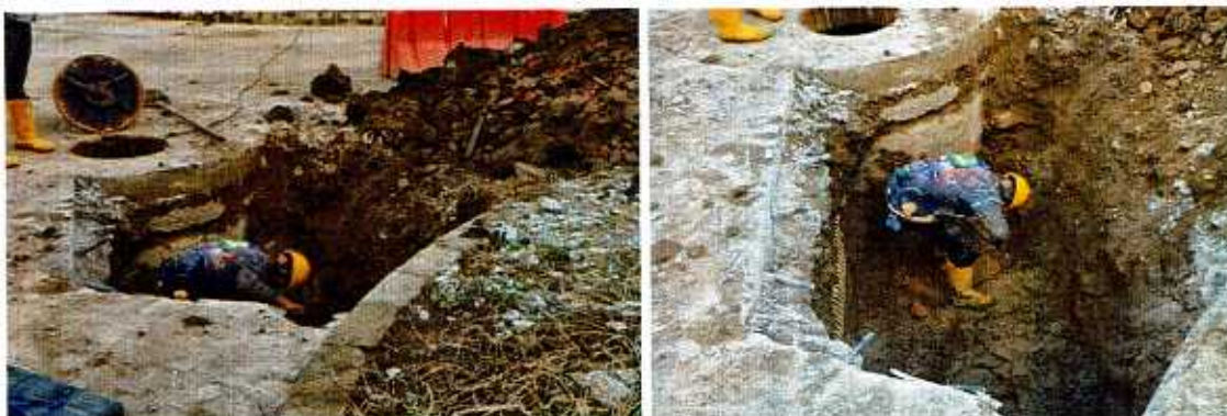
IMAGEN 8. EXCAVACIÓN A MANO EN MATERIAL COMÚN.
