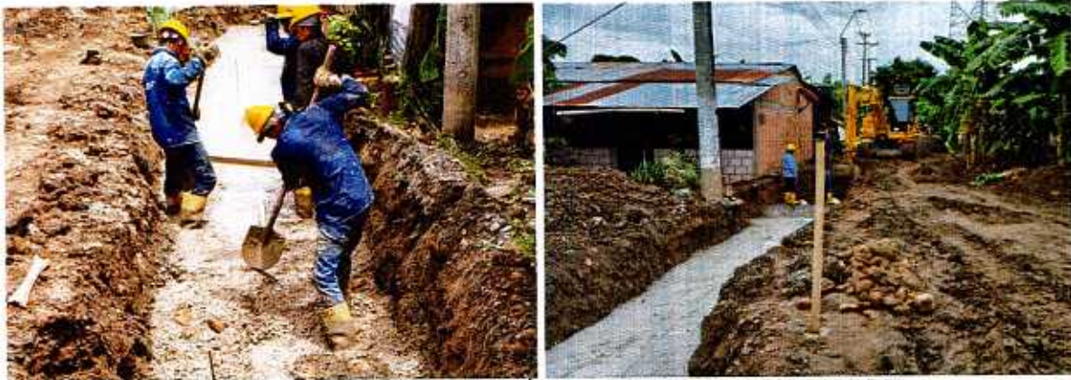
IMAGEN 13. CONCRETO CICLÓPEO DE RESISTENCIA 2500 PSI.
