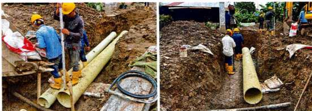
IMAGEN 10. TUBERÍA PVC ALCANTARILLADO 18". SUMINISTRO E INSTAL.
