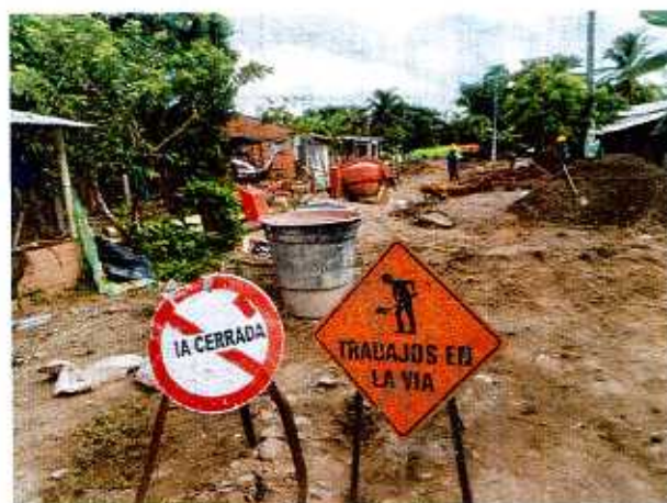
Fotografía 6.12 y 6.13. Señalización utilizada para cerrar vías en la obra.
