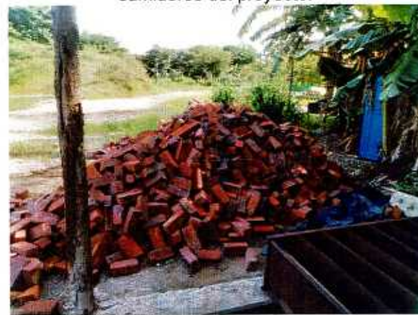
Fotografía 6.11. Descargue de elementos para la obra.
