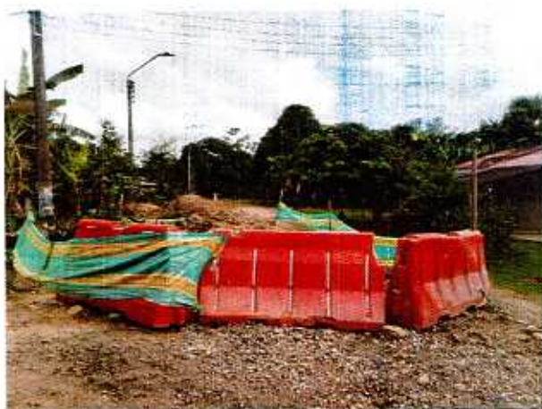
Fotografía 6.12 y 6.13. Señalización utilizada para cerrar vías en la obra.
