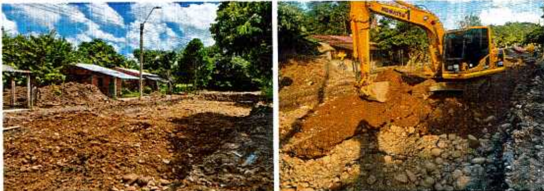
IMAGEN 17. MEJORAMIENTO DE LA SUBRASANTE CON MATERIAL CRUDO DE RÍO CLASIFICADO TMAX 3".
