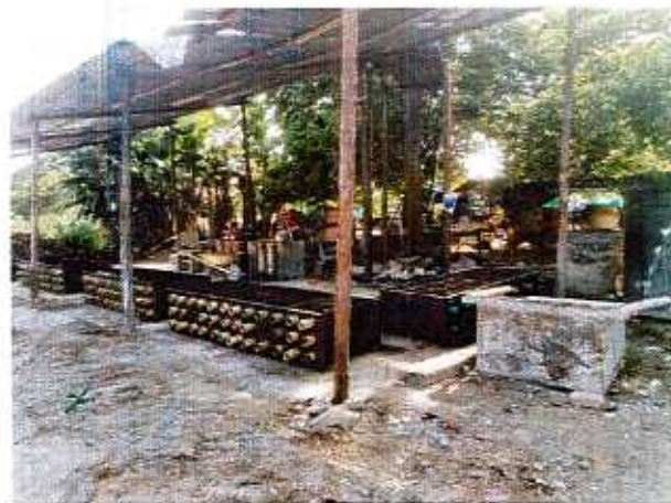
Fotografía 6.10. Área donde se elaboran tapas para sumideros del proyecto.
