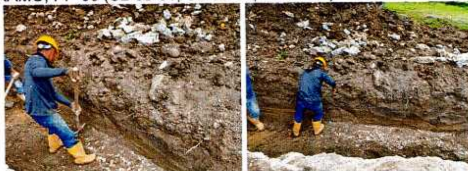
IMAGEN 15. EXCAVACIÓN A MANO EN MATERIAL COMÚN.
