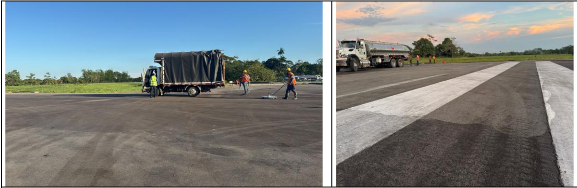
PRUEBA DE MEDICIÓN DE COEFICIENTE DE ROZAMIENTO (FRICCIÓN) EN PISTA Y/O CALLES DE RODAJE Y/O PLATAFORMA.
