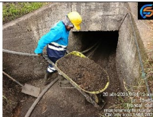
Limpeza y mantenimiento Alcantarillas
