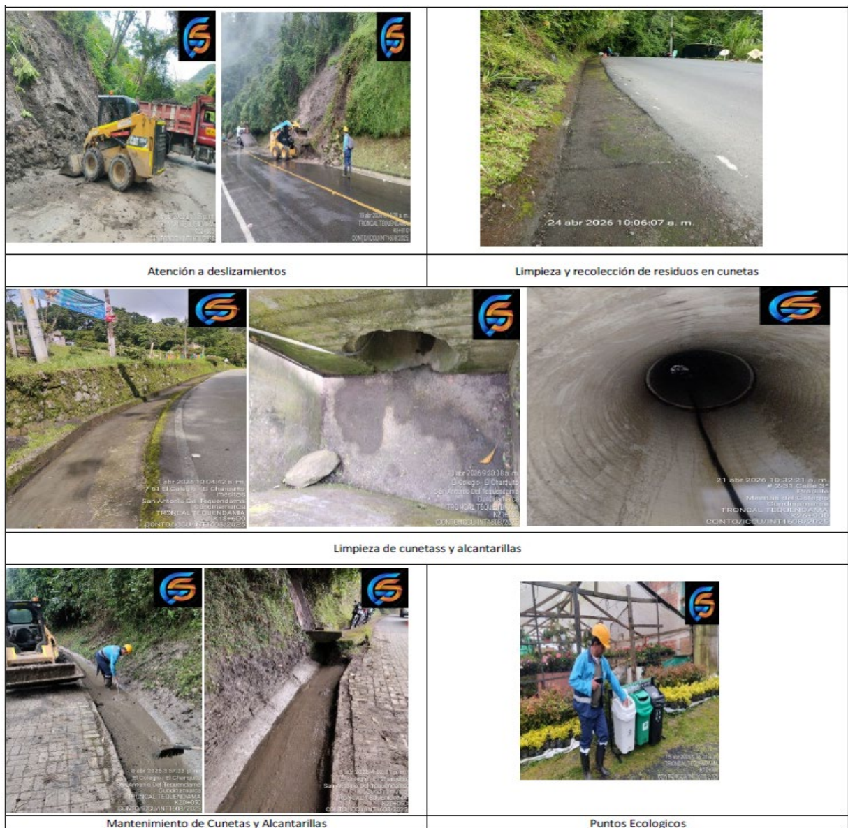
Ilustración 7. Registro Fotográfico Corredor Nuevo Salto Fuente: Propia
