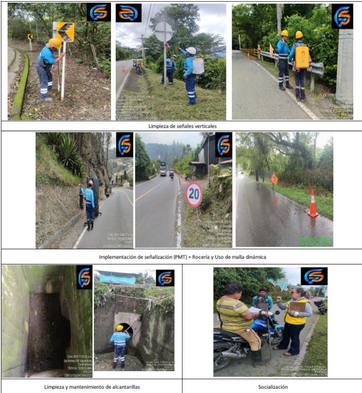
Ilustración 6. Registro Fotográfico Corredor Nuevo Salto Fuente: Propia
