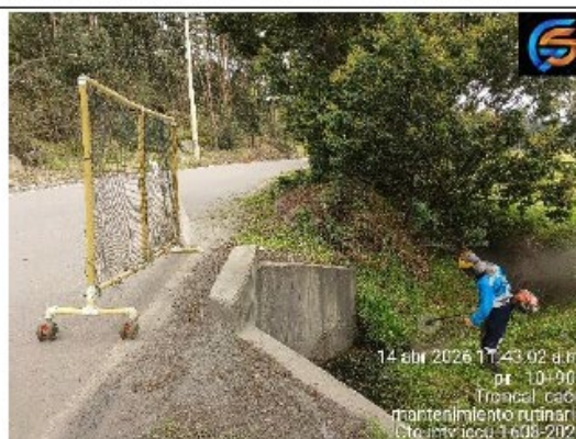
Rocería y Uso de malla dinámica
