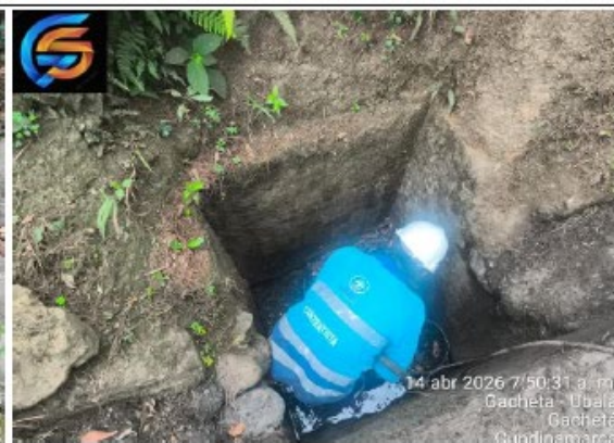
Limpieza y mantenimiento de Cunetas y Alcantarillas
