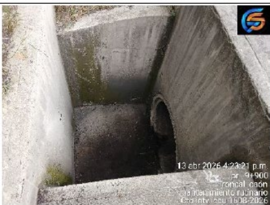
Limpeza y mantenimiento Alcantarillas
