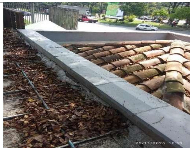
Limpieza de cubierta
