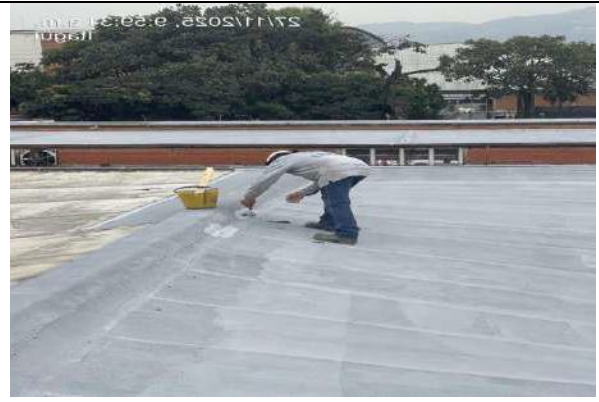
Aplicación de pintura impermeabilizante
