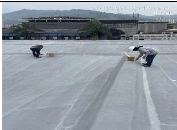
Aplicación de pintura impermeabilizante
