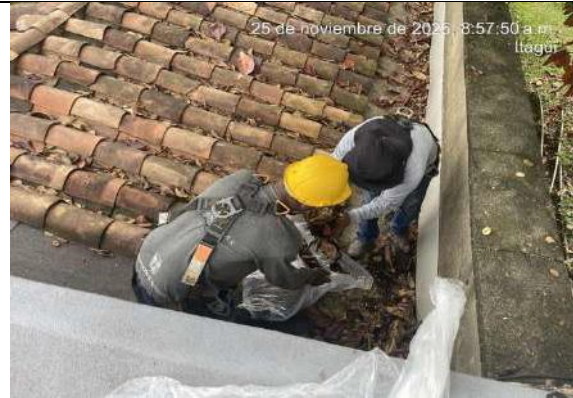
Limpieza de cubierta en teja de barro
