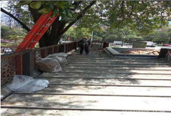
Limpieza de cubierta
