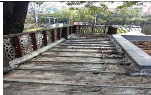
Limpieza de cubierta
