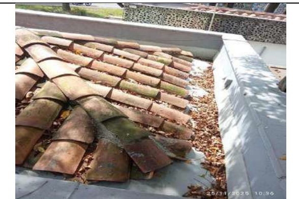
Limpieza de cubierta
