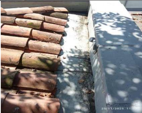
Limpieza de cubierta
