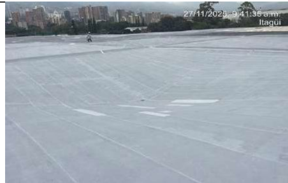
Aplicación de pintura impermeabilizante
