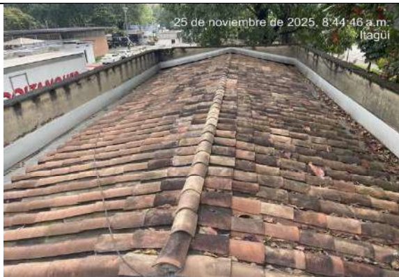
Limpieza de cubierta en teja de barro
