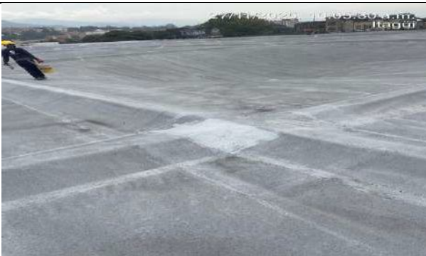
Aplicación de pintura impermeabilizante
