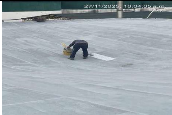
Aplicación de pintura impermeabilizante
