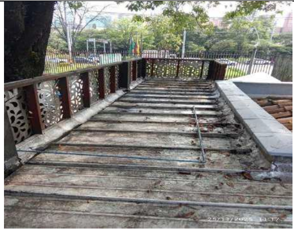
Limpieza de cubierta
