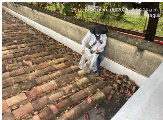
Limpieza de cubierta en teja de barro
