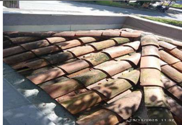
Limpieza de cubierta
