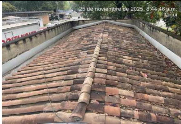
Limpieza de cubierta en teja de barro
