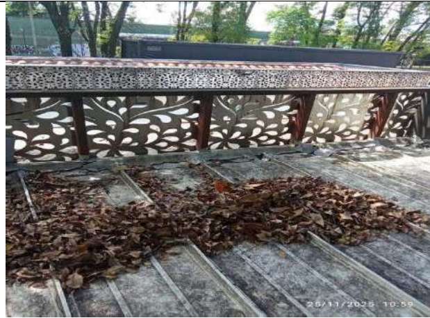
Limpieza de cubierta
