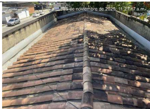
Limpieza en cubierta teja de barro
