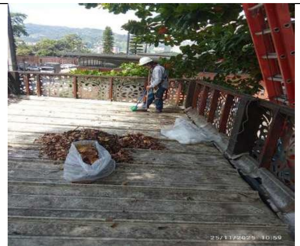
Limpieza de cubierta
