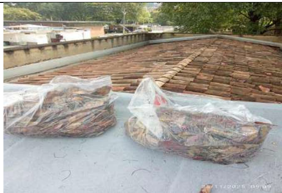
Limpieza de cubierta en teja de barro
