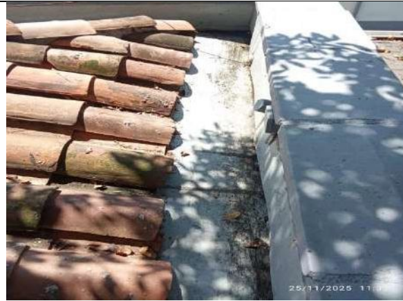
Limpieza de cubierta
