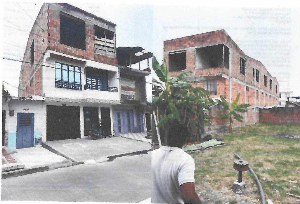
Visita Ocular: Carrera 11 No. 15-32 Visita ocular por construcción de ventanas, señora Ana luisa Mondragon
