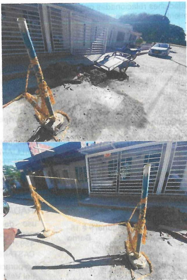
Visita Seguimiento ruptura de pavimento: Calle 13D entre Carrera 14C y 14 por daño en alcantarillado, señor Carlos Barona. (reposición de pavimento favorablemente)
