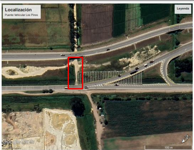
Ilustración No. 1. Localización puente vehicular existente, objeto de intervención.
