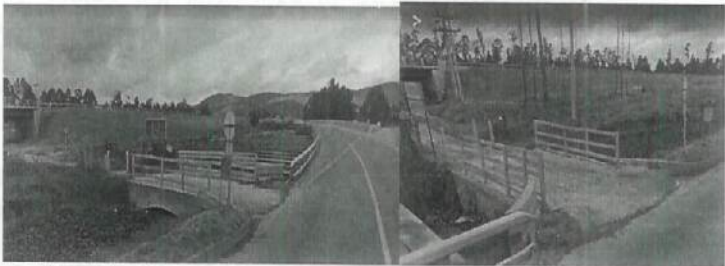
Foto No. 2 y 3. Condiciones puente vehicular existente los Pinos
