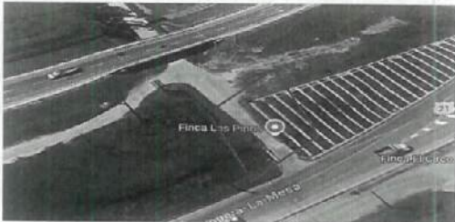
Foto No. 6. Condiciones puente vehicular existente los Pinos
