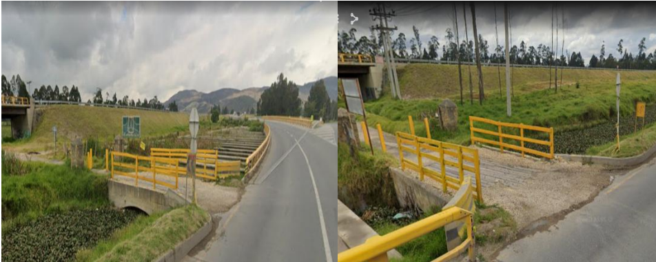
Foto No. 2 y 3. Condiciones puente vehicular existente los Pinos
