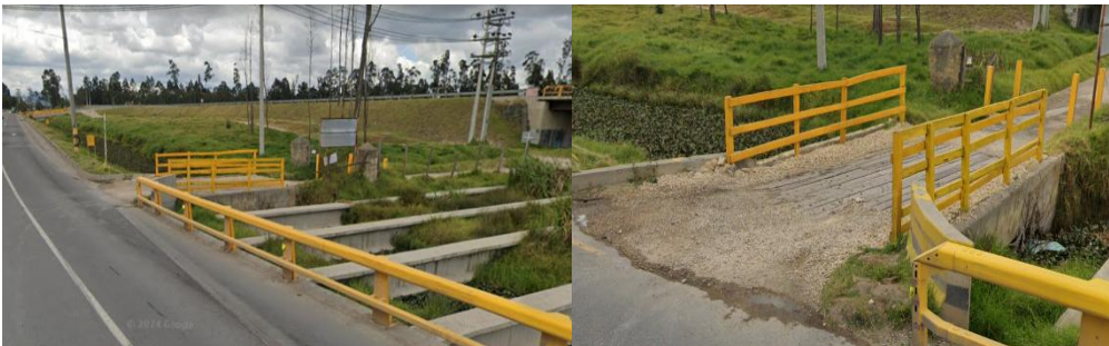
Foto No. 4 y 5. Condiciones puente vehicular existente los Pinos
