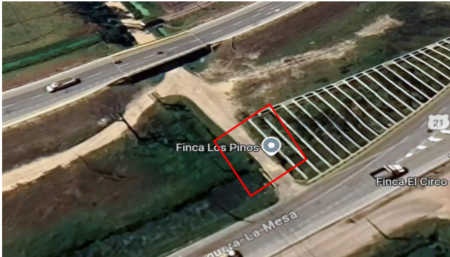
Foto No. 6. Condiciones puente vehicular existente los Pinos
