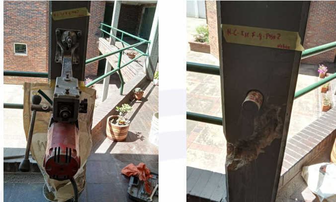
Imagen 8 Ensayo de extracción de núcleos de concreto. Fuente: Propia
