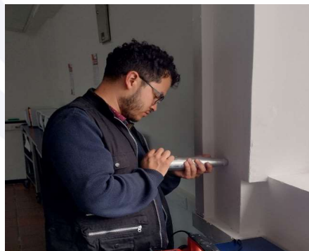
Imagen 17 Ensayo de Esclerometría. Fuente: Propia
