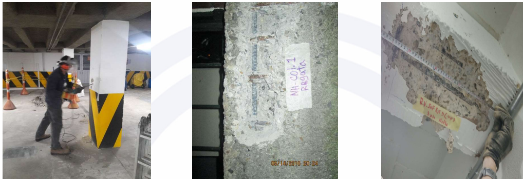
Imagen 12 Regatas de inspección. Fuente: Propia
