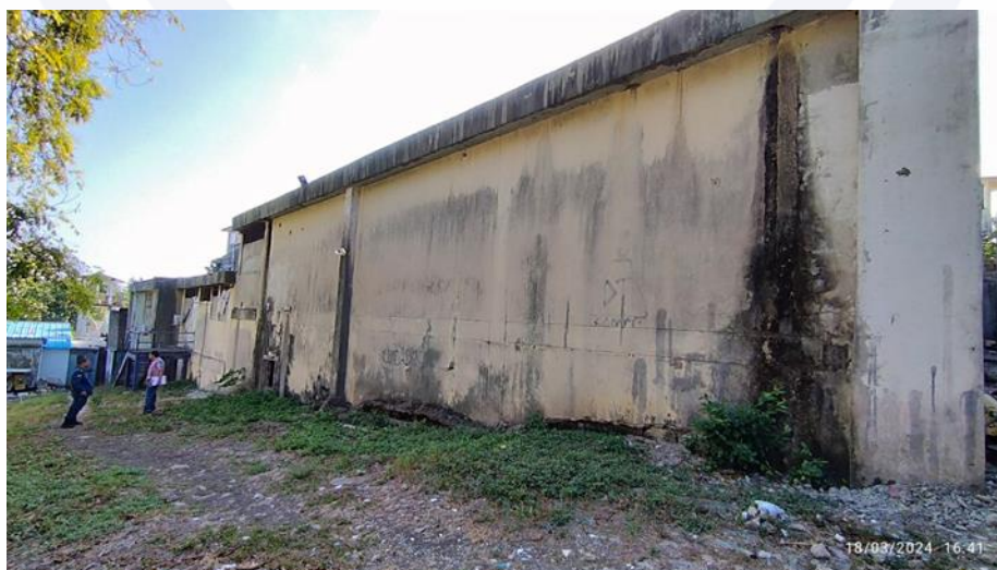
Imagen 12 Fachada oriental. Fuente: Registro fotográfico propio.
