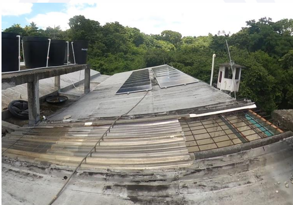
Imagen 20 Vista cubiertas (4). Fuente: Registro fotográfico propio.
