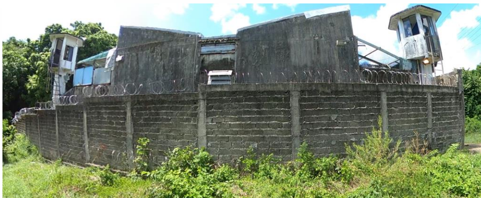
Imagen 15 Fachada principal norte. Fuente: Registro fotográfico propio.
