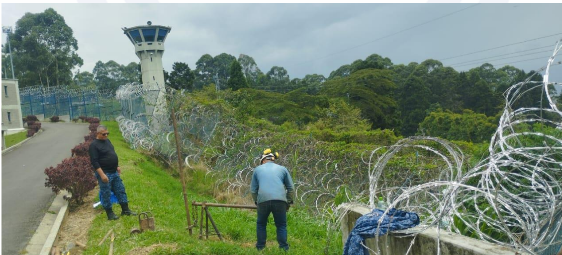
Ilustración 2. Estado actual del cerramiento. Fuente: Adaptado de Google Maps.
