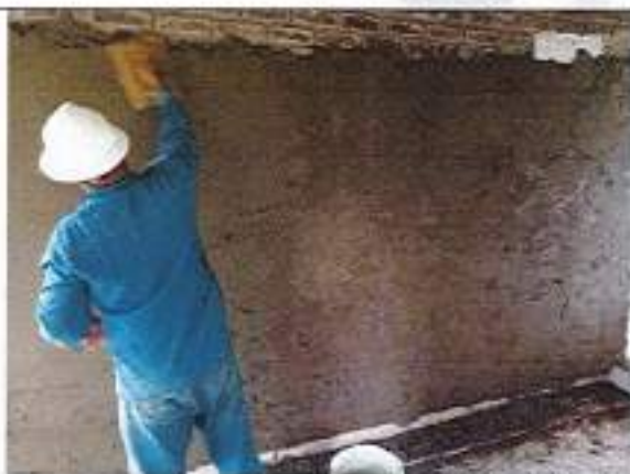
Aplicación de pañete liso 1:4 en muros
