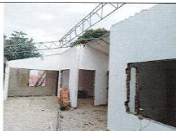
Desmonte de cubiertas de asbesto cemento.
