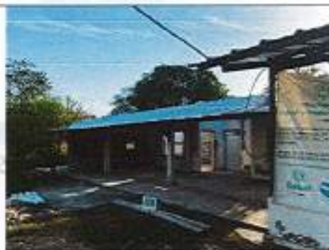
Suministro e Instalación de Cubierta tipo sandwich Deck 333C.
