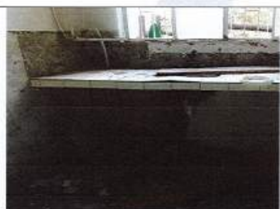
Demolición manual de mesón.
