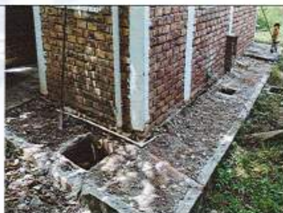
Demolición manual de placa de piso
