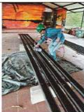
Correa metálica en perfil PHR -C 120 x 60 x 2 mm
