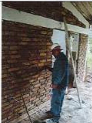
Limpieza de muros y aplicación de pañete liso 1:4 en muros
