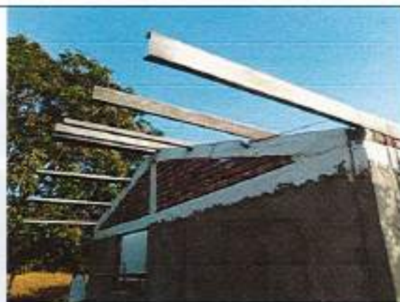
Correa metálica en perfil PHR -C 120 x 60 x 2 mm
