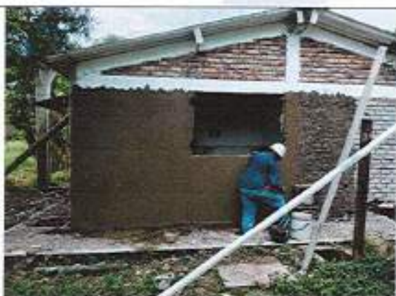
Aplicación de pañete liso 1:4 en muros
