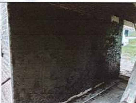
Aplicación de pañete liso 1:4 en muros
