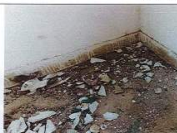
Demolición manual de enchape de pisos y muros.
