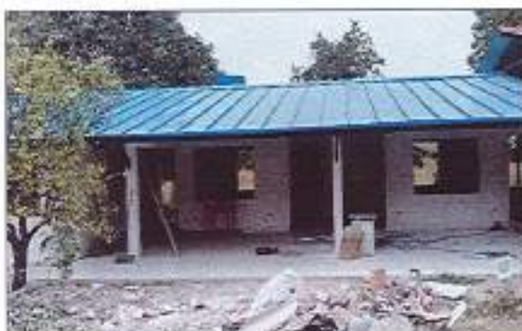
Fotografía No. 103 – Vista acceso 1
