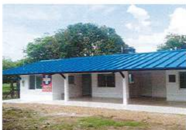
Cubierta tipo sandwich Deck 333C.
