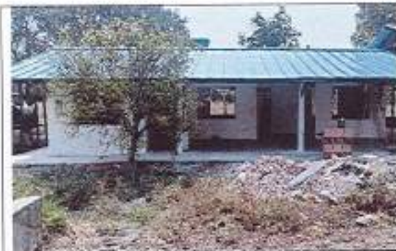
Fotografía No. 91 – Vista acceso 1
