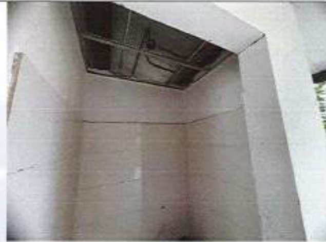
Salida para iluminación de techo.
