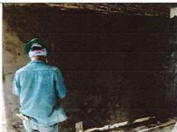
Aplicación de pañete liso 1:4 en muros
