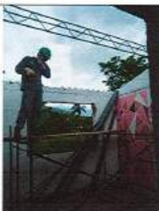
Desmonte de cubiertas de asbesto cemento.
