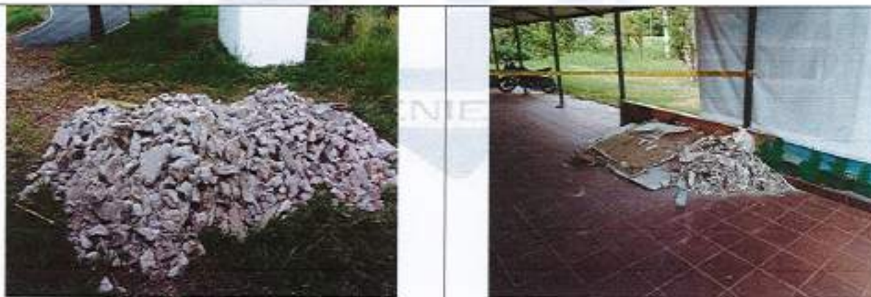
Acopio de material de demolición.
