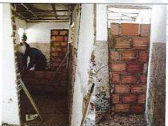
Construcción de muro en bloque No.5
