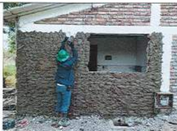
Aplicación de pañete liso 1:4 en muros
