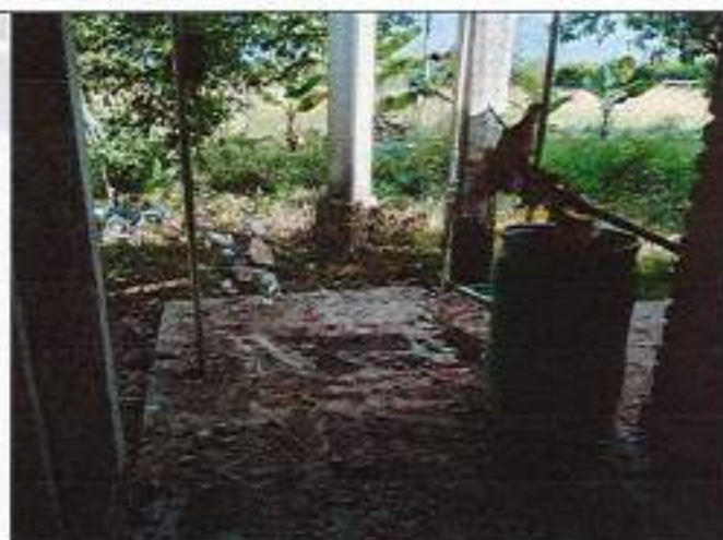
Desmante lavaderos prefabricados
