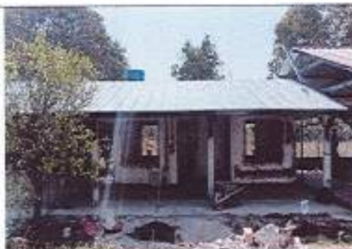
Fotografía No. 79 – Vista acceso 1
