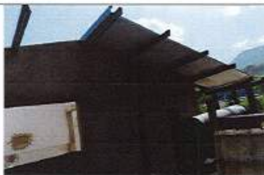
Suministro e Instalación de Cubierta tipo sandwich Deck 333C
