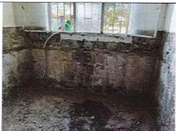
Demolición manual de mesón en concreto.
