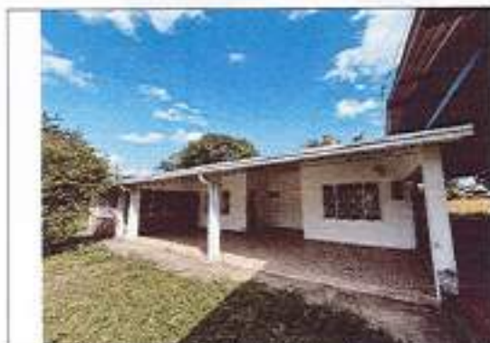
Fotografía No. 03 – Fachada principal
