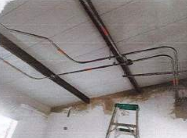
Salida para iluminación de techo.
