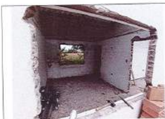
Fotografía No. 43 – Cuarto enfermería
