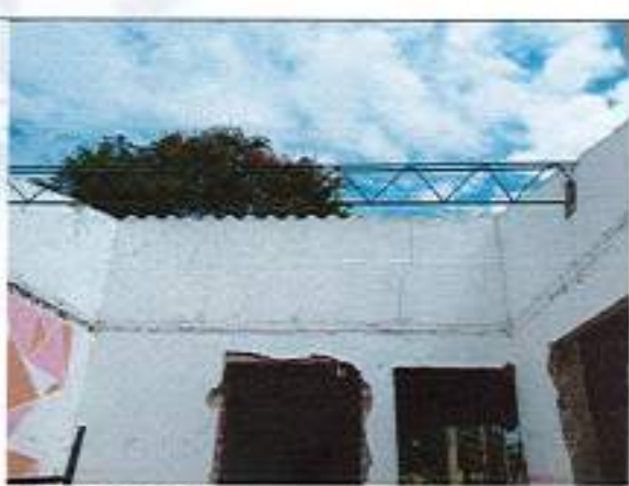
Desmonte de cubiertas de asbesto cemento.
