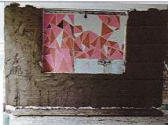
Limpieza de muros y aplicación de pañete liso 1:4 en muros
