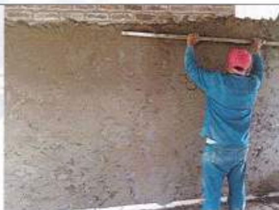
Aplicación de pañete liso 1:4 en muros
