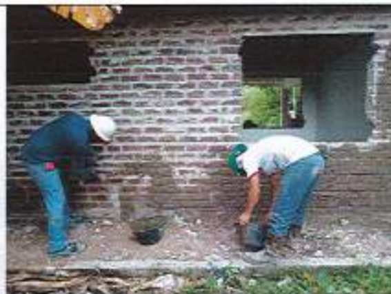
Aplicación de pañete liso 1:4 en muros
