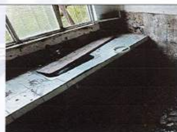
Demolición manual de mesón.
