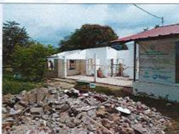
Desmonte de cubiertas de asbesto cemento
