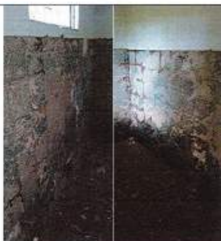
Demolición manual de enchape de pisos y muros.
