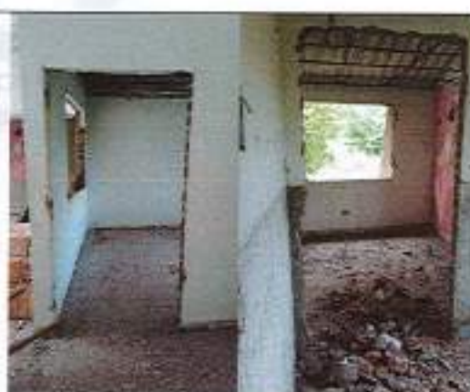
Corte y demolición manual de muros en ladrillo.
