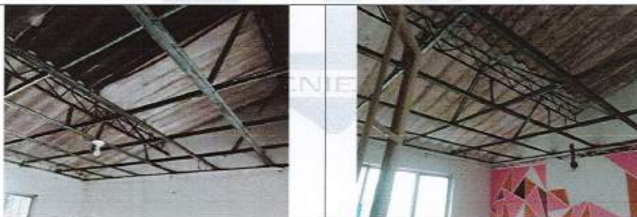
Desmante de cielo raso
