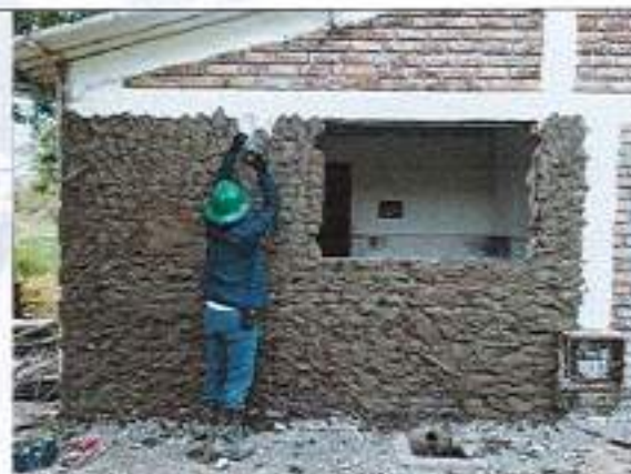
Aplicación de pañete liso 1:4 en muros
