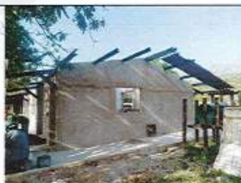
Correa metálica en perfil PHR -C 120 x 60 x 2 mm
