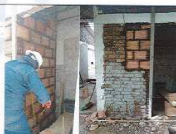
Construcción de muro en bloque No.5
