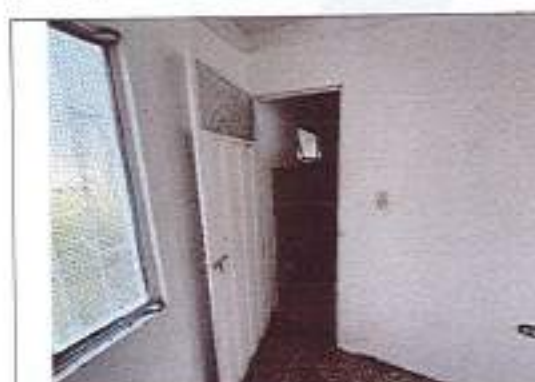
Fotografía No. 23 – Acceso baño consultorio
