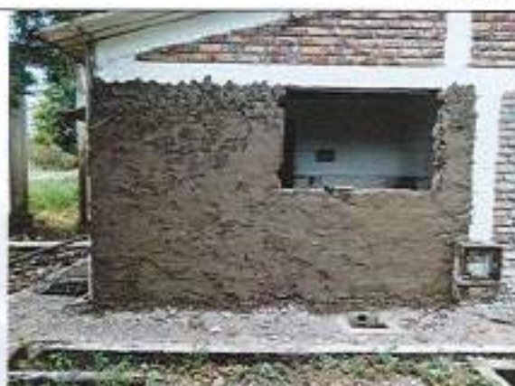
Aplicación de pañete liso 1:4 en muros
