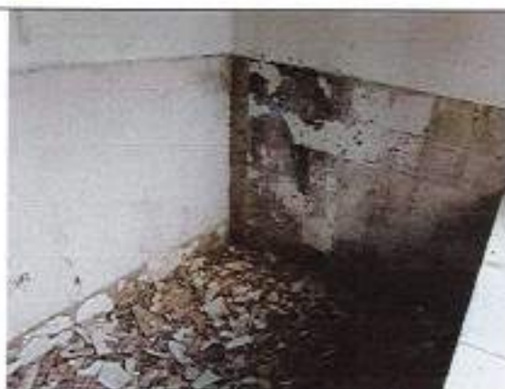
Demolición manual de enchape de pisos y muros.
