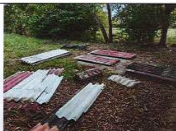
Desmonte de cubiertas de asbesto cemento, cargue y acopio.
