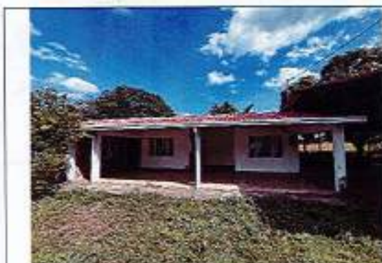
Fotografía No. 01 – Vista acceso
