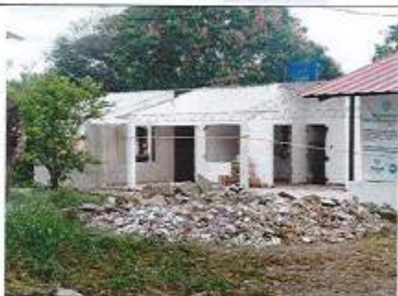
Desmonte de cubiertas de asbesto cemento
