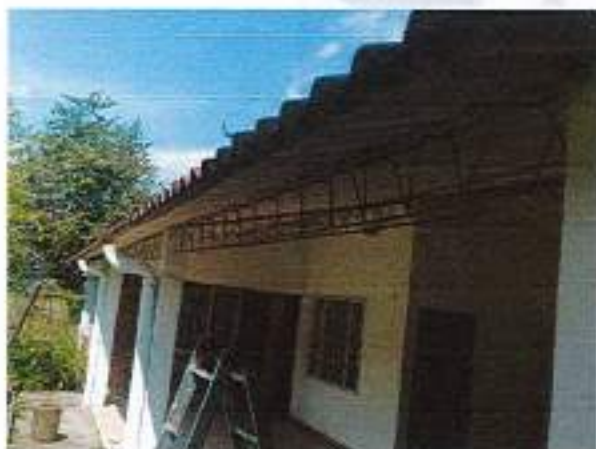
Desmante de canales y bajantes de agua lluvia.
