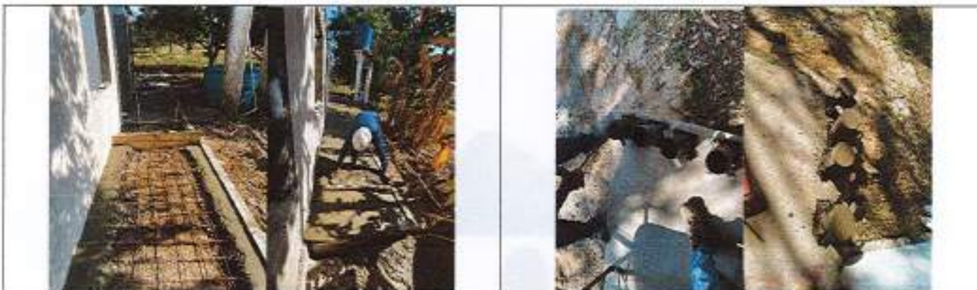
Construcción de andén perimetral.
