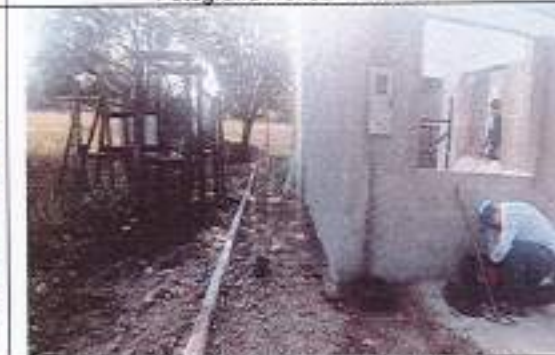
Fotografía No. 54 – Andén Lateral Izquierdo
