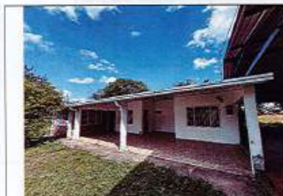
Fotografía No. 03 – Fachada principal
