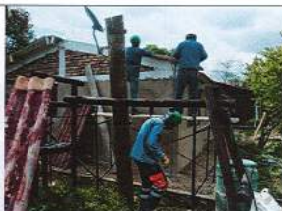
Desmonte de cubiertas de asbesto cemento.
