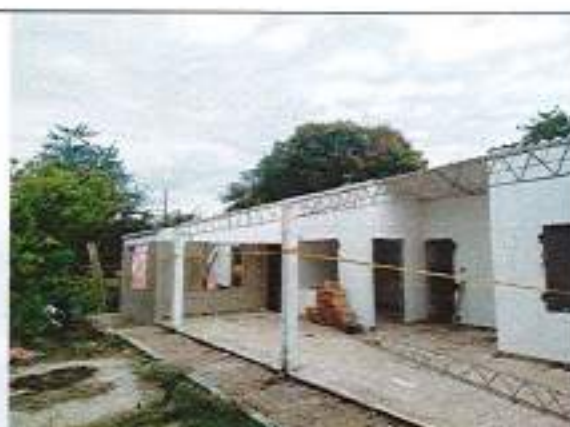
Desmonte de cubiertas de asbesto cemento.
