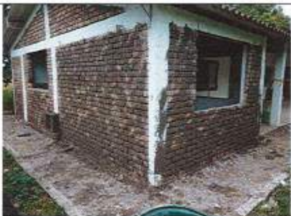
Aplicación de pañete liso 1:4 en muros
