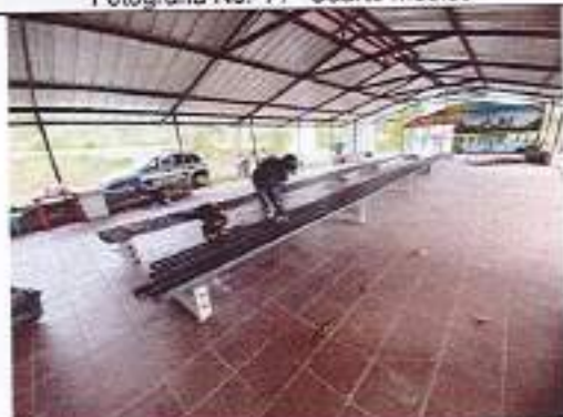
Fotografía No. 46 – Alistamiento correas cubierta
