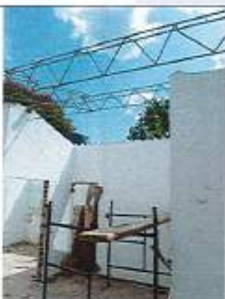
Desmonte de cubiertas de asbesto cemento.
