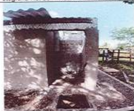
Fotografía No. 40 – Cuarto de Aseo
