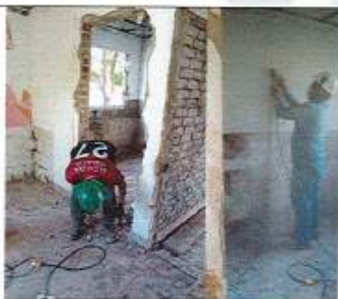
Corte y demolición manual de muros en ladrillo.
