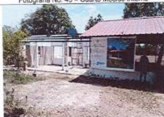
Fotografía No. 47 – Vista acceso
