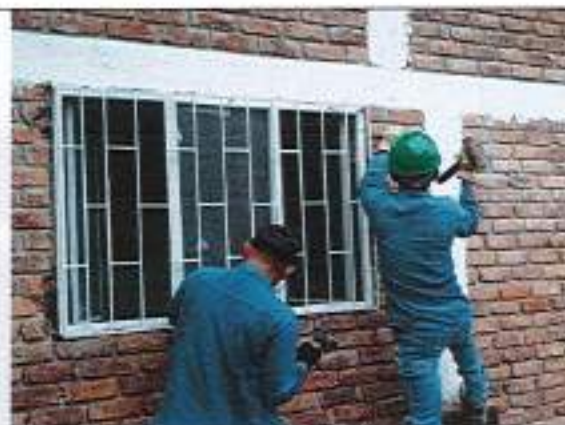
Desmonte de puertas y ventanas.
