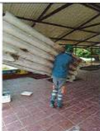
Desmonte de cubiertas de asbesto cemento, cargue y acopio.
