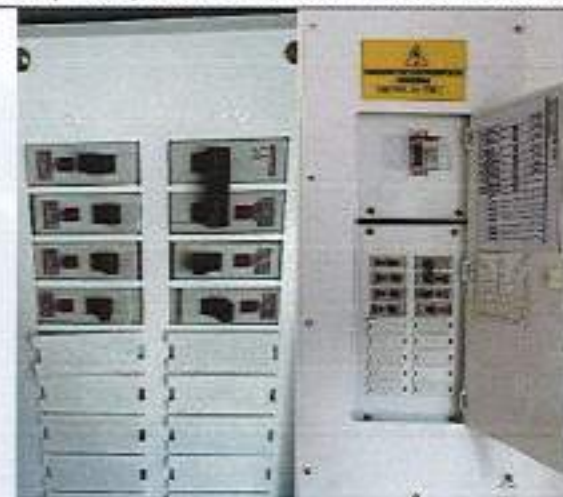
Instalación trifásica, totalizador y cortacircuitos.
