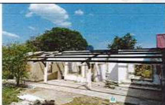
Correa metálica en perfil PHR -C 120 x 60 x 2 mm
