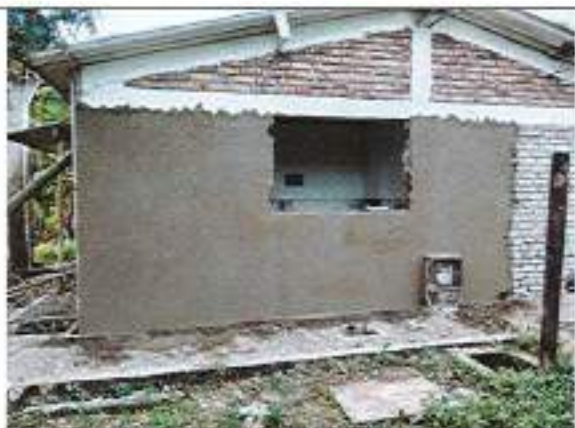
Aplicación de pañete liso 1:4 en muros.
