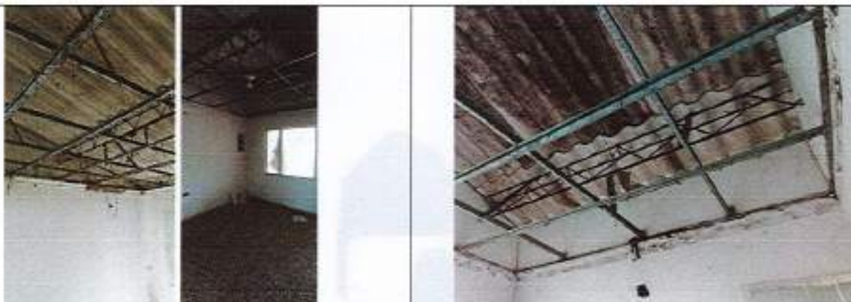
Desmante de cielo raso
