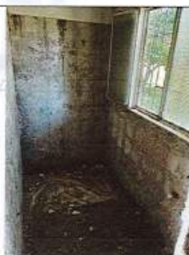
Demolición manual de enchape de pisos y muros.
