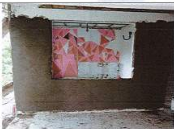
Aplicación de pañete liso 1:4 en muros
