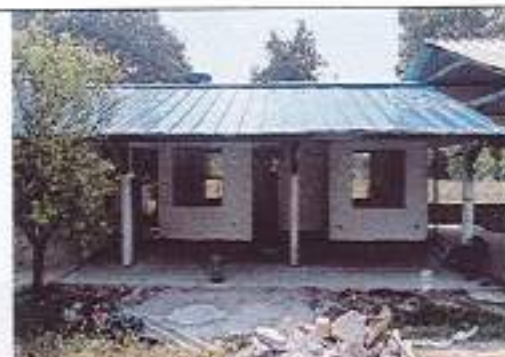
Fotografía No. 80 – Vista Acceso 2
