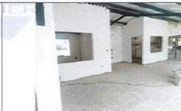
Pintura exterior acrílica tipo koraza.
