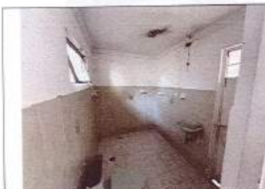
Fotografía No. 21 – Interior baño consultorio 1 y 2
