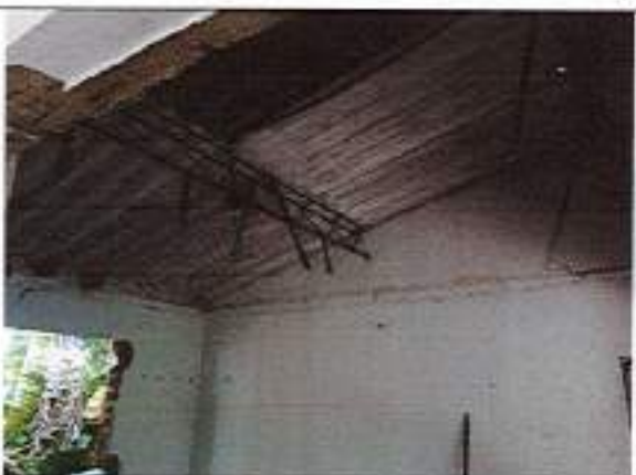
Desmonte de cubiertas de asbesto cemento.
