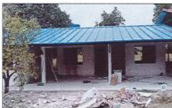
Fotografía No. 115 – Vista acceso 1
