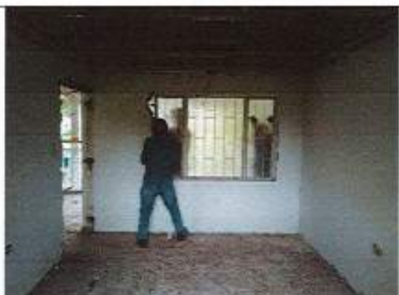
Desmonte de puertas y ventanas.
