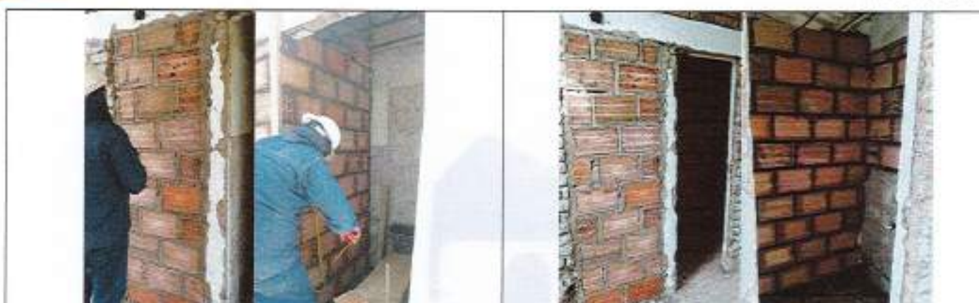
Construcción de muro en bloque No. 5
