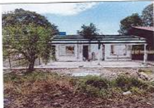
Fotografía No. 67 – Vista acceso
