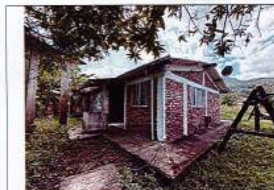
Fotografía No. 05 – Fachada posterior
