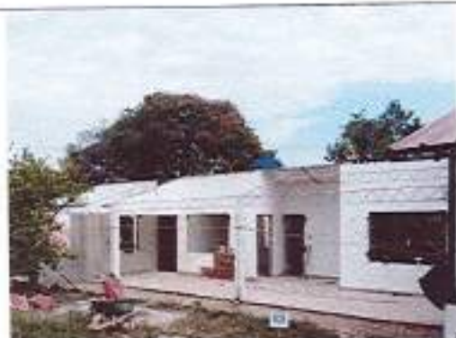
Fotografía No. 37 – Vista acceso
