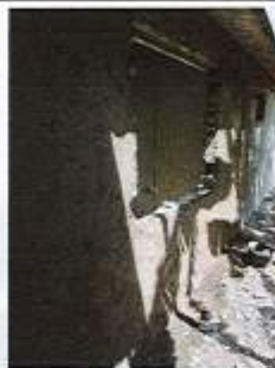
Aplicación de pañete liso 1:4 en muros.
