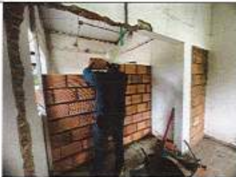
Construcción de muro en bloque No. 5.
