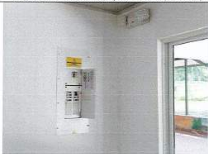
Instalación trifásica, totalizador y cortacircuitos.
