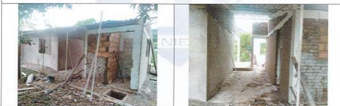
Construcción de muro en bloque No. 5
