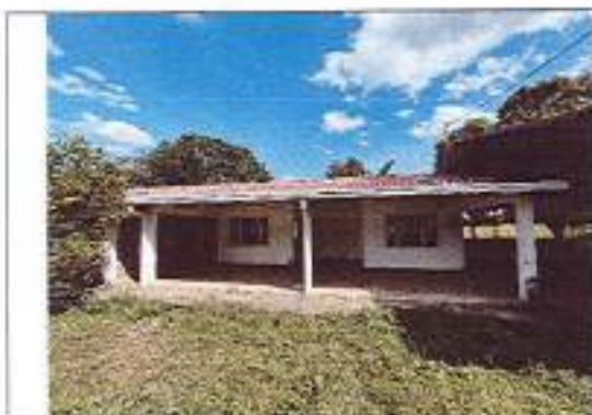
Fotografía No. 01 – Vista acceso
