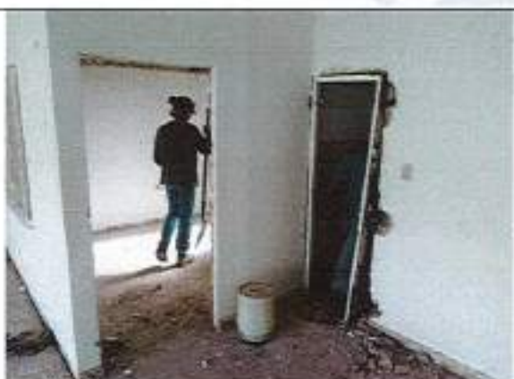
Desmonte de puertas y ventanas, incluye marco.
