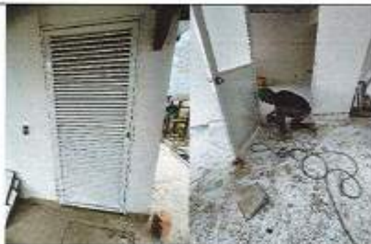
Instalación de puertas y ventanas en aluminio.
