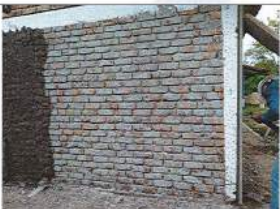
Aplicación de pañete liso 1:4 en muros
