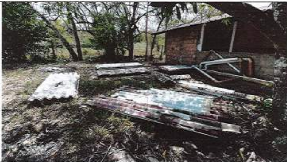
Evidencia fotográfica del almacenamiento adecuado de los materiales retirados.
