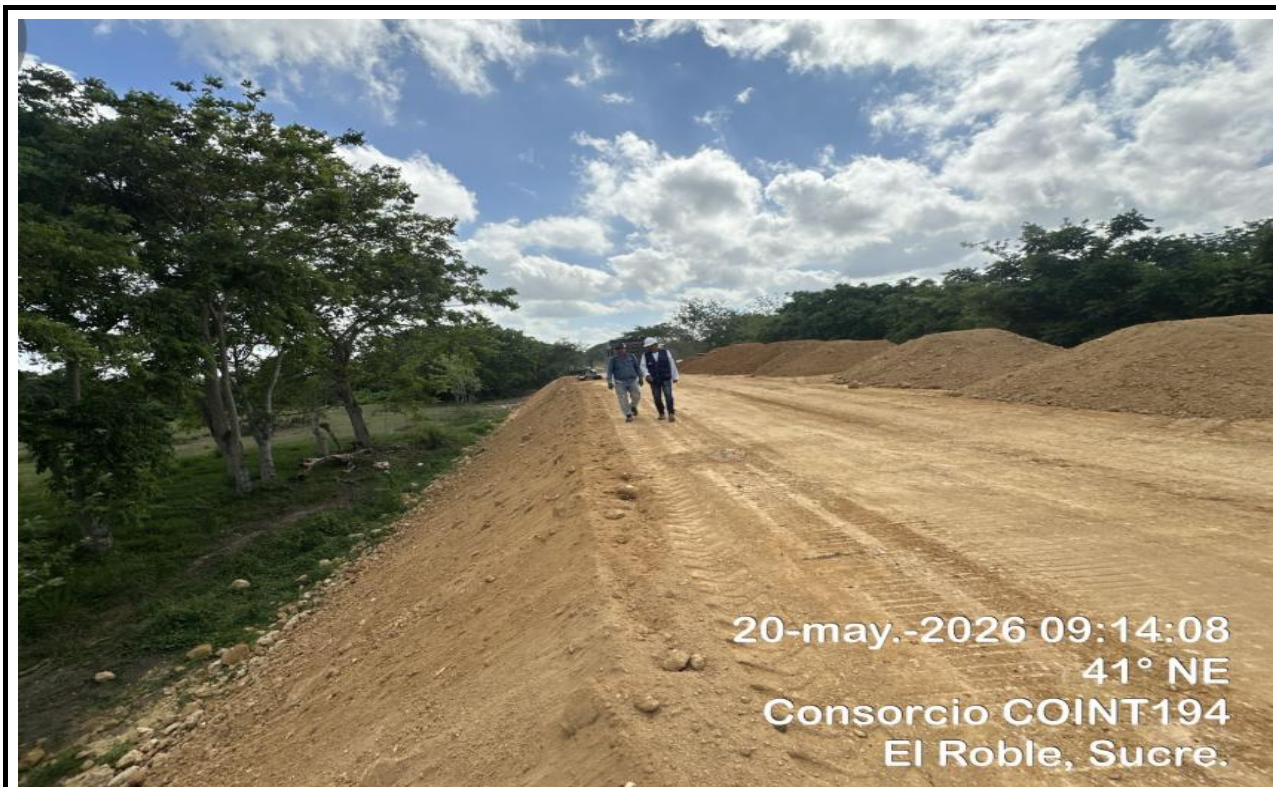
Imagen No.5: Conformación de terrplén entre las abscisas K1+700 hasta K1+860.
