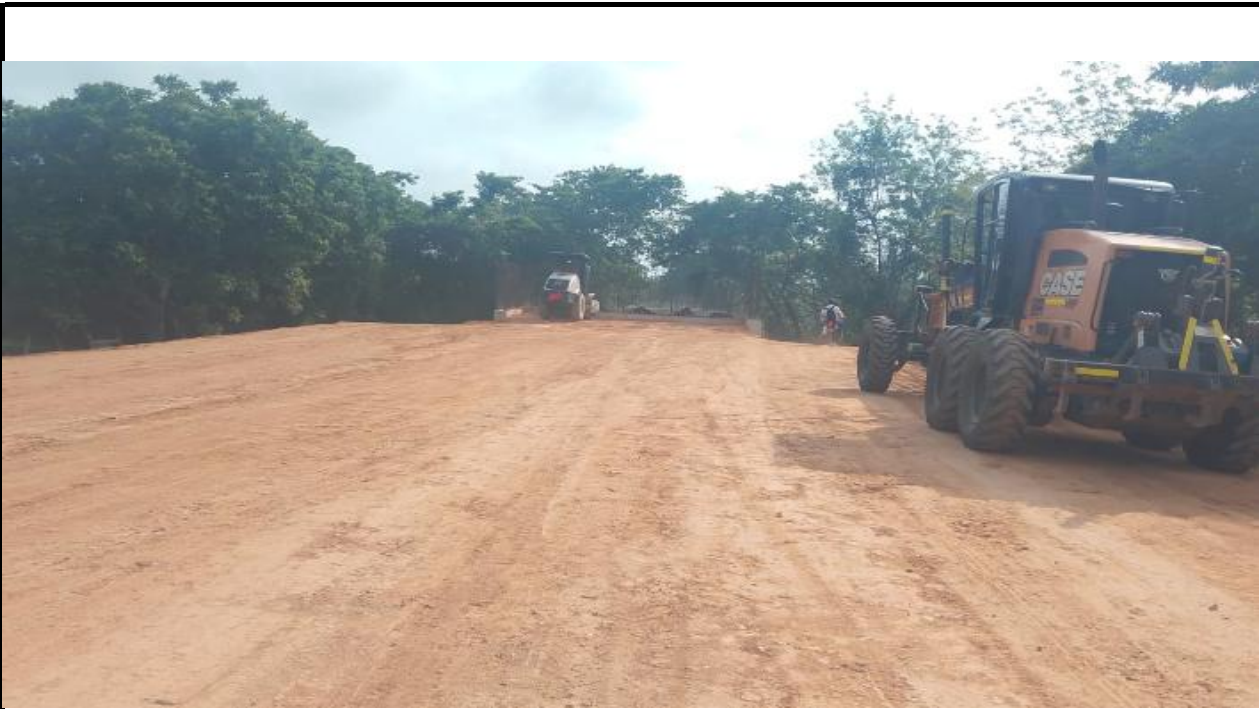
Imagen No.4: Conformación de terrplén entre las abscisas K1+700 hasta K1+860.
