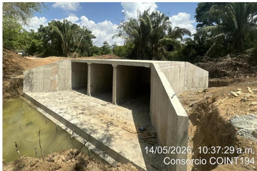
Estado actual box coulvert triple (K3+220)
