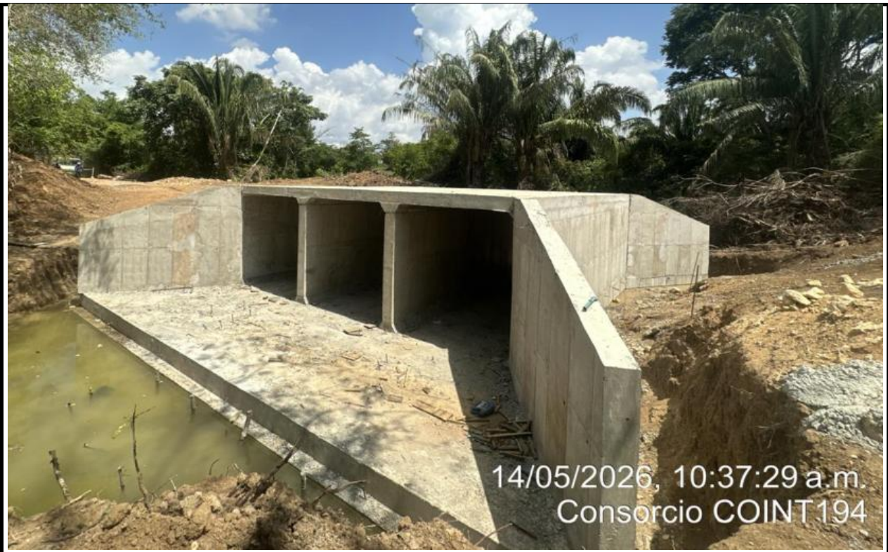
Imagen No.1: Estado del Box culvert triple celda en la abscisa K3+220.
