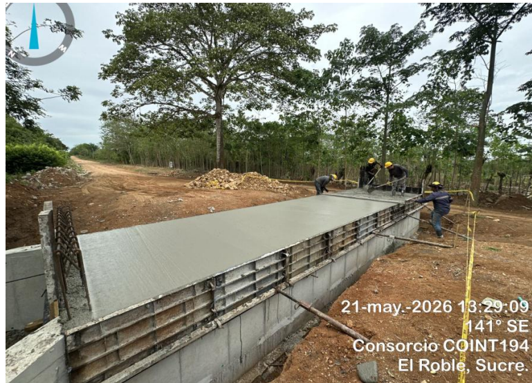
Estado actual box coulvert 2.5X1 (K2+275)
