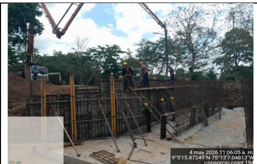
Imagen No.2: Construcción de Box culvert triple K3+220, con la fundida de los muros exteriores y aletas.
