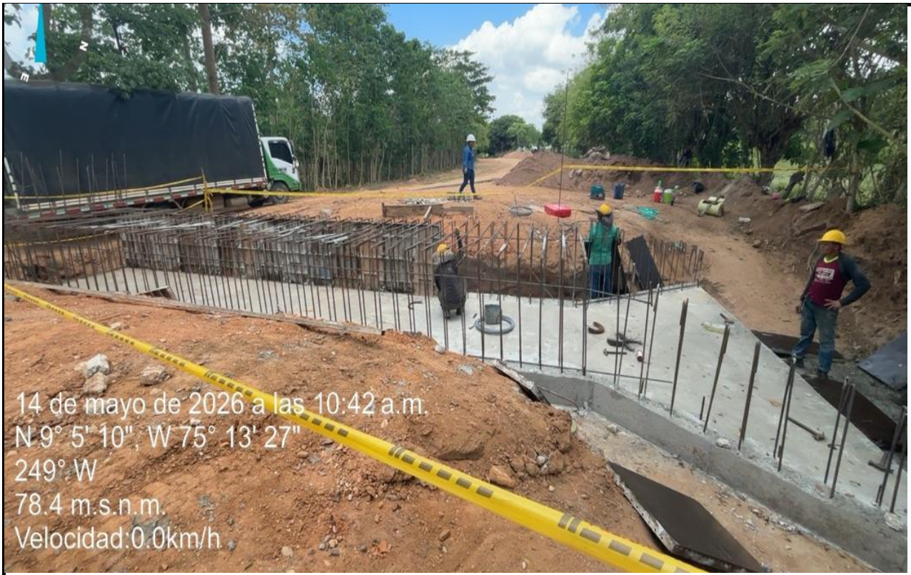
Imagen No.2: Instalación del acero de refuerzo muros laterales en box coulvert 2m x1m de la abscisa K1+570.
