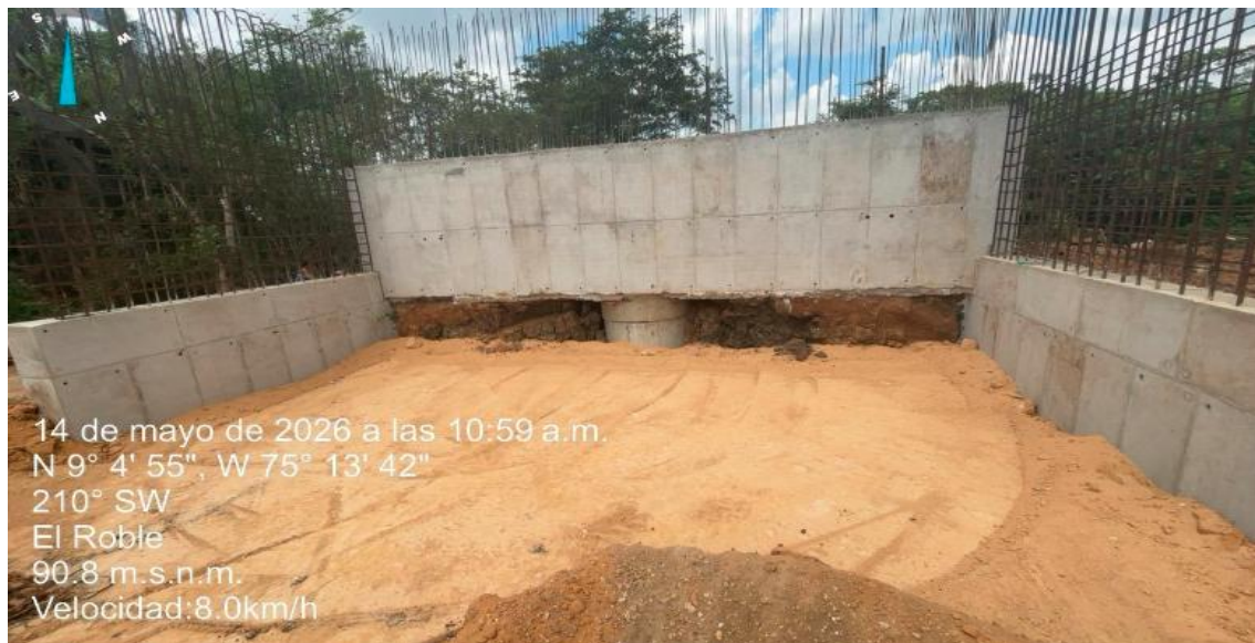
Imagen No.6: Relleno estructural en Puente No. 2 K1+880.
