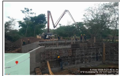
Imagen No.6: Construcción de Box culvert triple K3+220, con la fundida de los muros interiores.
