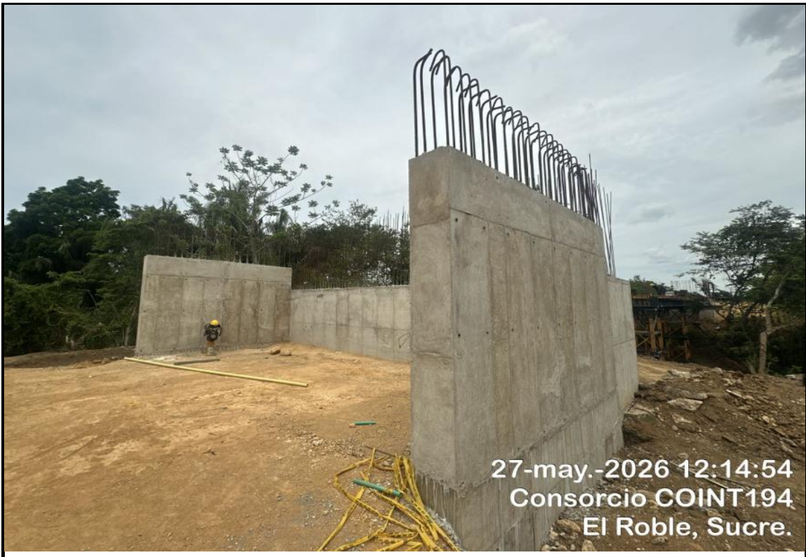
Imagen No.2: Fundida en concreto de 28 MPa de las Aletas 4 y 5 (segundo nivel de 3m a 6m).
