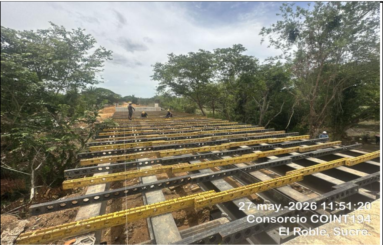
Imagen No.1: Portabilidad para vigas soportes longitudinales en puente 2 (K1+880)
