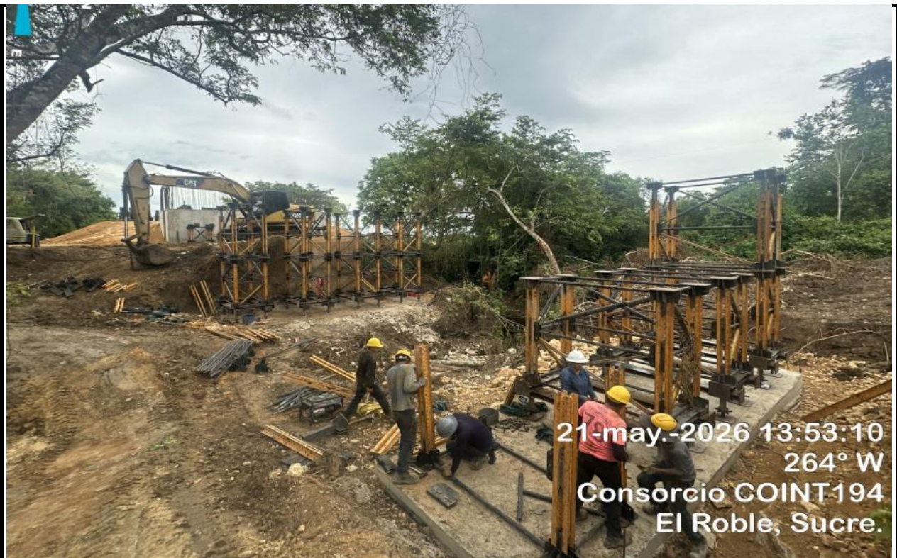
Imagen No.4: Instalación de estructura de soporte para vigas longitudinales en el puente N°2 K1+880.
