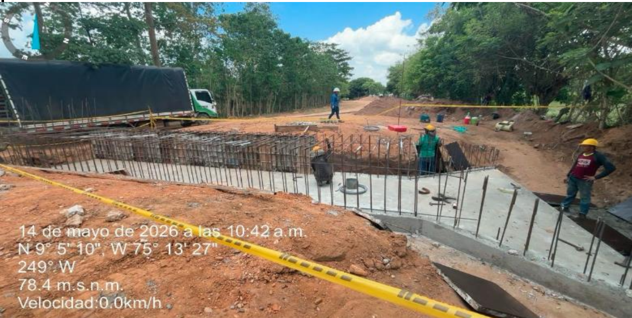
Imagen No.5: Placa inferior del box culvert en la asbsica K2+570.
