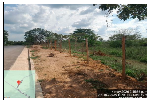
Imagen No.3: Instalación de cercas con la utilización de estacas de madera y alambre de púas.
