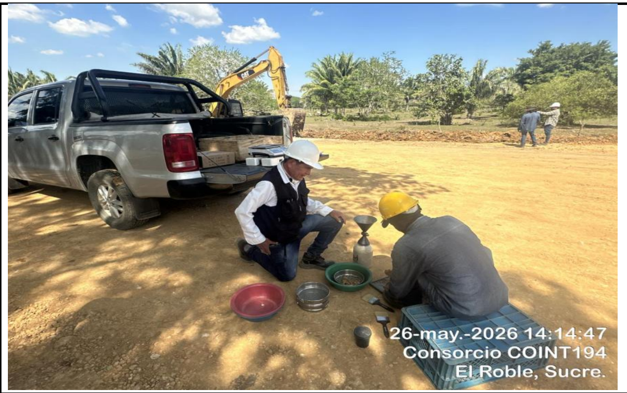
Imagen No.5: Toma de densidades en terraplén de aproche salida puente N2 K1+975 CI capa 4
