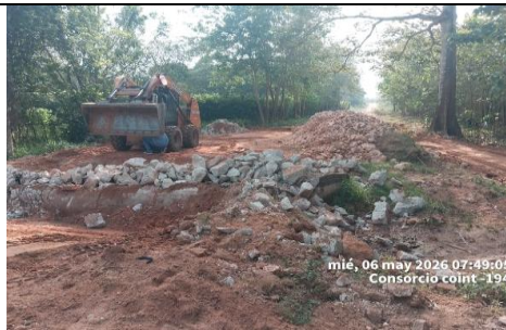
Imagen No.5: Demolición de alcantarilla existente en la abscisa K2+570.
