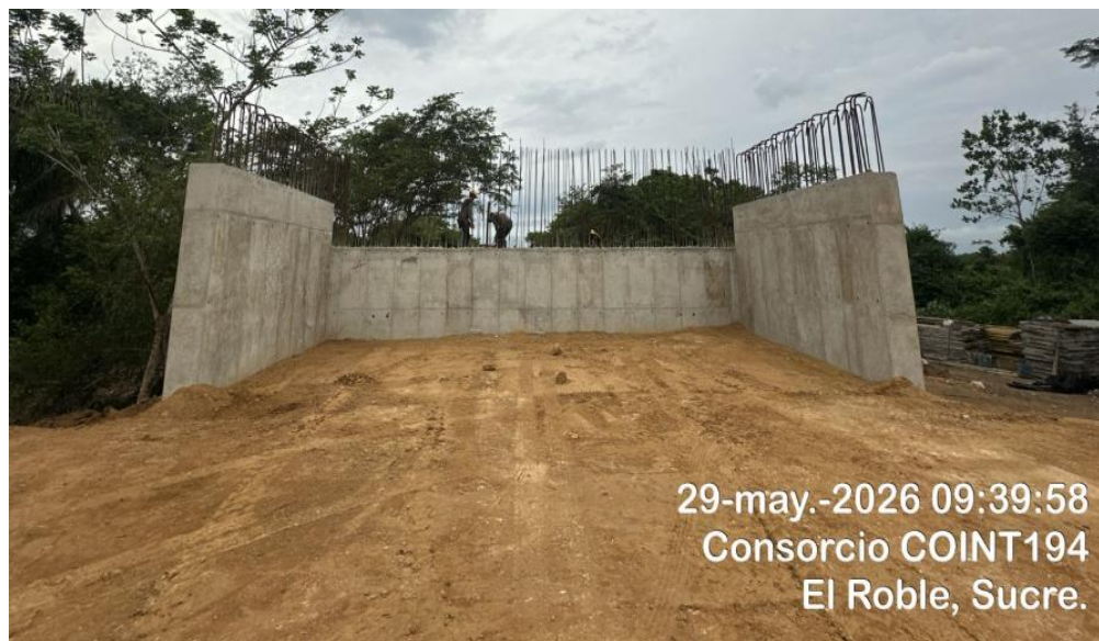
Avance en las aletas en segundo nivel (3 a 6m) en puente 2 (K1+880)
