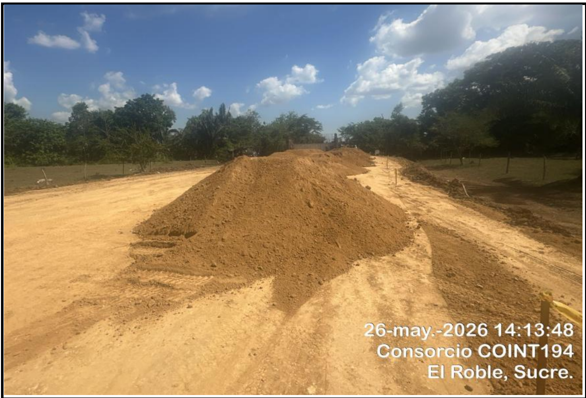
Imagen No.6: Conformación de terraplén de salida aproche puente 2 K1+910 al K2+010
