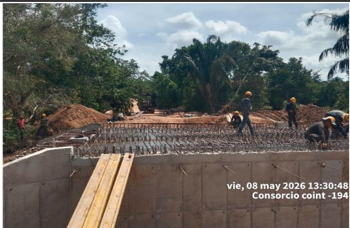
Imagen No.1: Instalación del acero de refuerzo de la placa superior del Box culvert K3+220.
