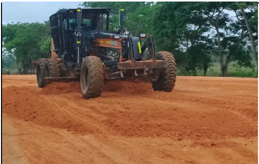
Imagen No.1: Extendida y compactación de material de Base granular entre las abscisas K1+600 - K1+700.
