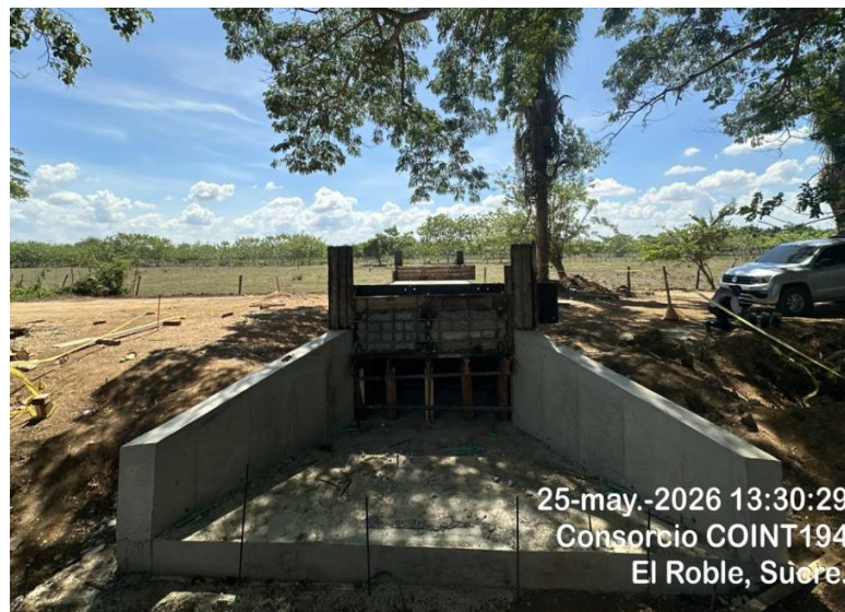
Estado actual box coulvert 2X1 (K2+570)
