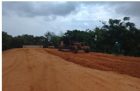
Imagen No.4: Conformación de terrplén entre las abscisas K1+700 hasta K1+860.
