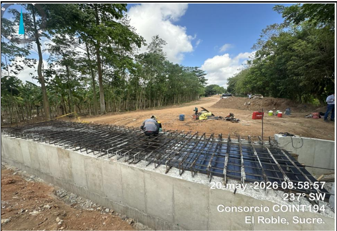
Imagen No.2: Instalación del acero de refuerzo placa superior en box coulvert 2mX1m de la abscisa K1+570.
