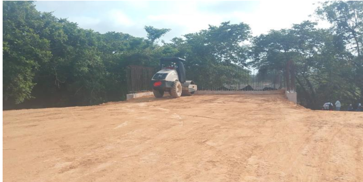
Imagen No.2: Conformación de Terraplén y relleno estructural .
