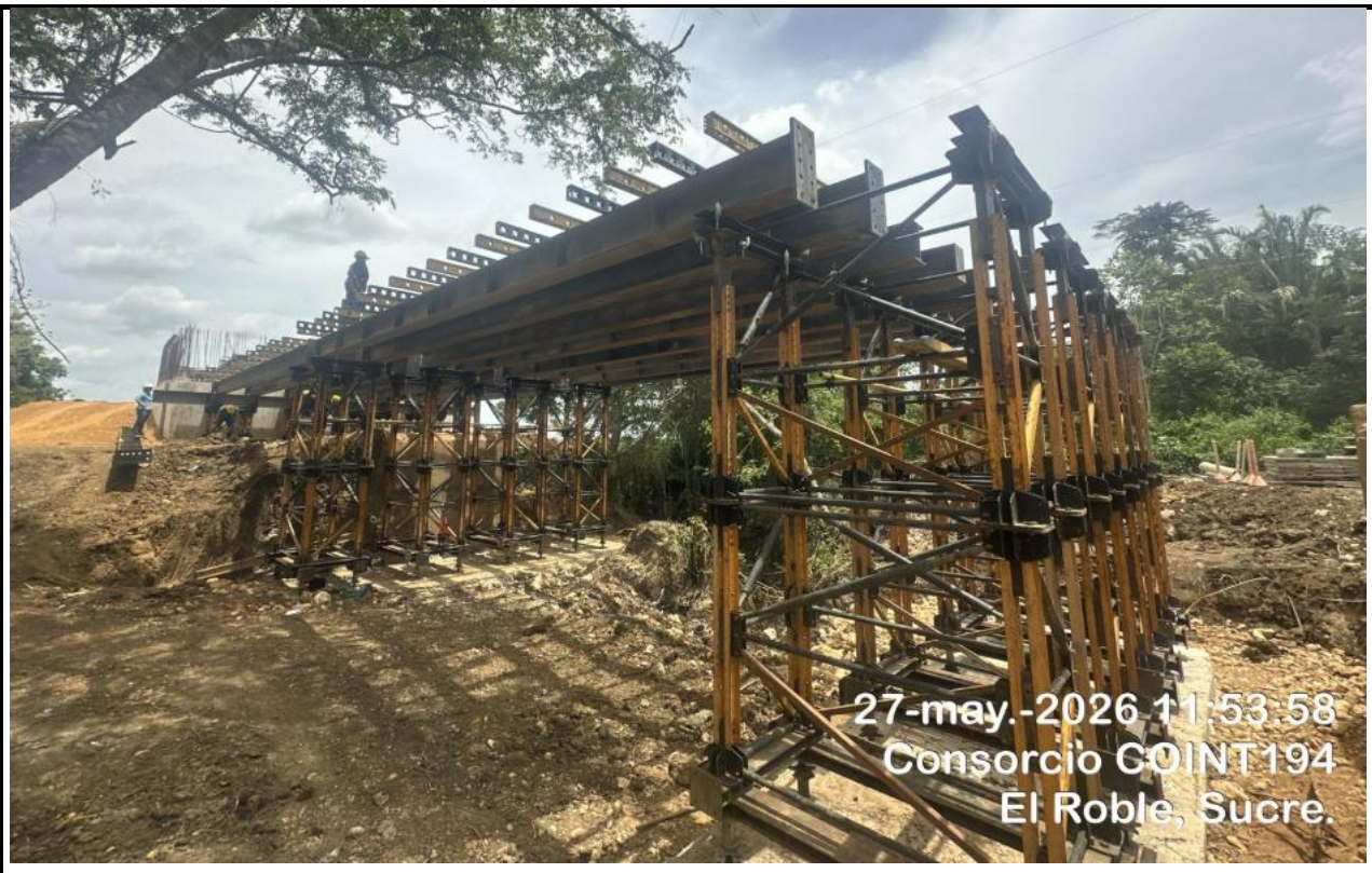
Imagen No.2: Portabilidad para vigas soportes longitudinales en puente 2 (K1+880)
