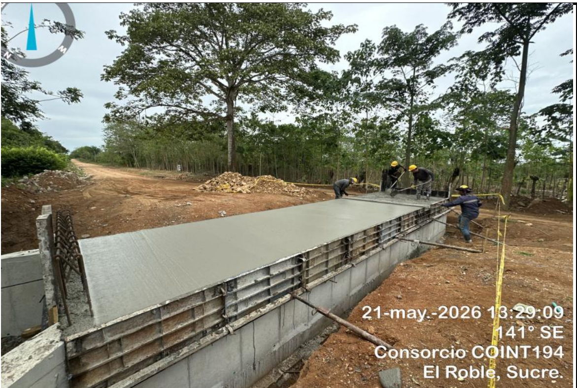
Imagen No.6: Fundida de placa superior del box coulvert 2mX1m de la abscisa K1+570.
