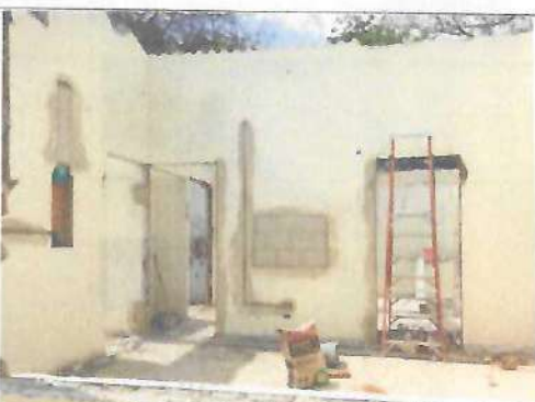
Fotografía No. 29 – resane de puertas, instalación de salida de toma corriente
