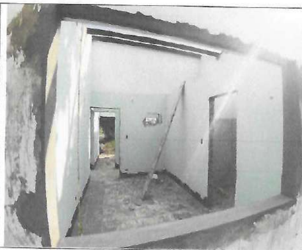
Fotografía No. 08 – consultorio 1
