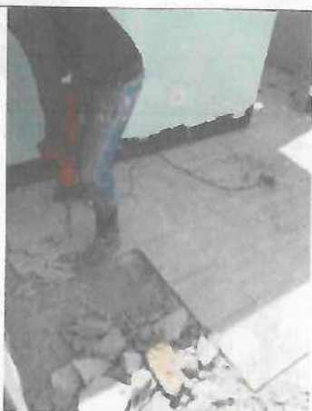
Fotografía No. 37 – Desmonte de baldosas
