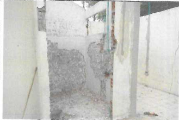
Fotografía No. 25 – Desmonte de baldosa baños
