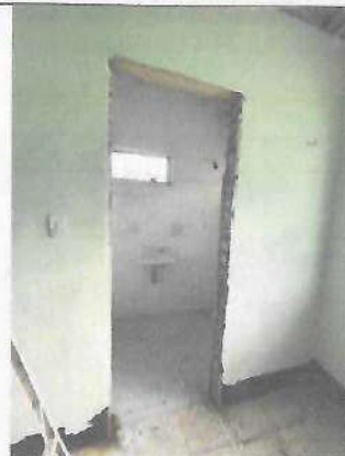
Fotografía No. 28 – Desmonte de marco y puerta de baño
