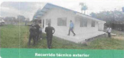
Recorrido técnico exterior
