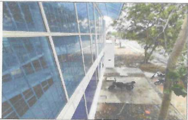
Fotografía No. 06 – Vista Ventana Posterior
