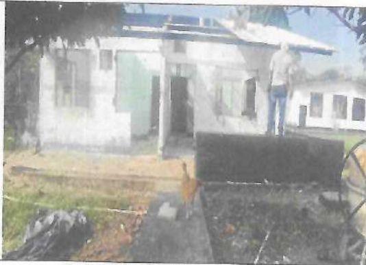
Fotografía No. 01 – Vista acceso
