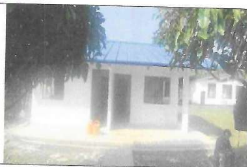
Fotografía No. 01 – Vista acceso
