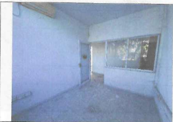
Fotografía No. 27 – Cuarto 4
