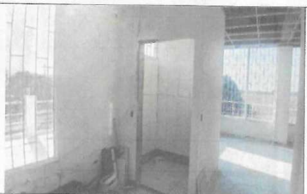
Fotografía No. 05 – Baño Consultorio 3 –Piso 2
