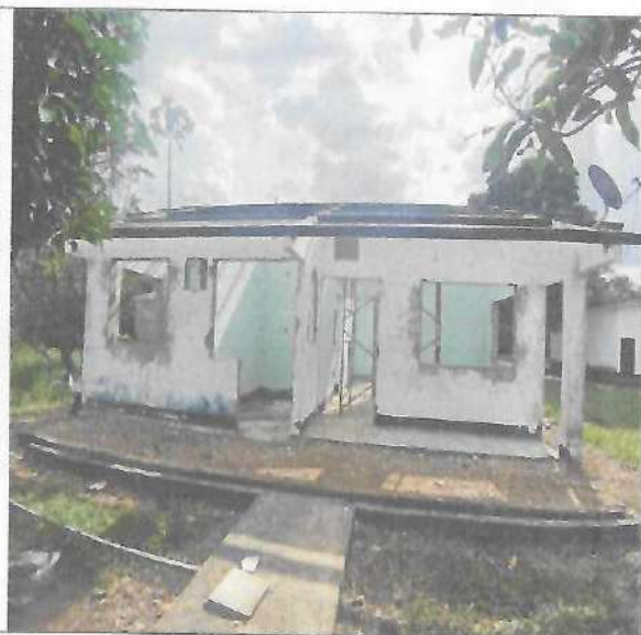
Fotografía No. 01 – Vista acceso
