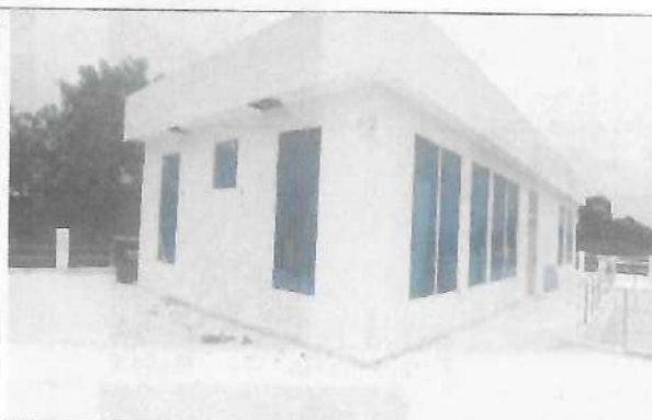
Fotografía No. 04 – Balcón, Pasillo, lado izquierdo
