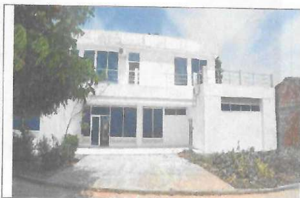
Fotografía No. 01 – Vista Fachada principal
