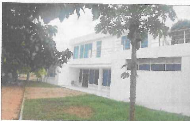
Fotografía No. 03 – Vista Lateral Der.
