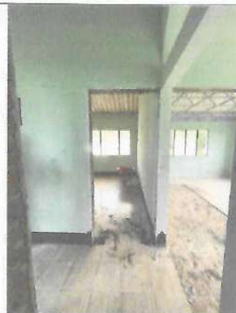
Fotografía No. 28 – Desmonte de marco y puerta de baño
