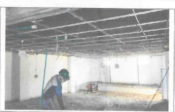
Fotografía No. 40 – Desmonte de cielo raso auditorio
