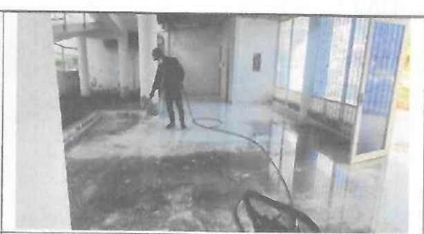
Fotografía No. 38 – Lavado de áreas
