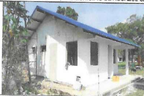
Fotografía No. 07 – Vista Lateral izquierda
