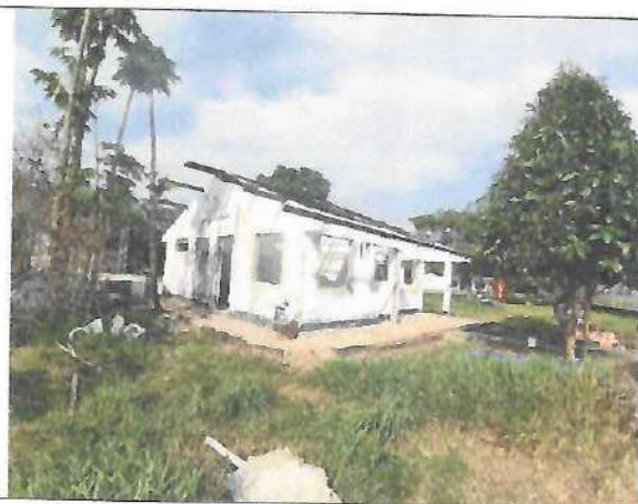
Fotografía No. 03 – vista lateral izquierda
