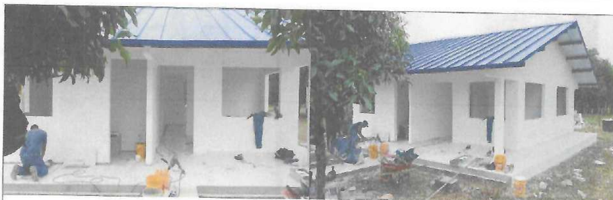
Fotografía No. 01 – Vista acceso
