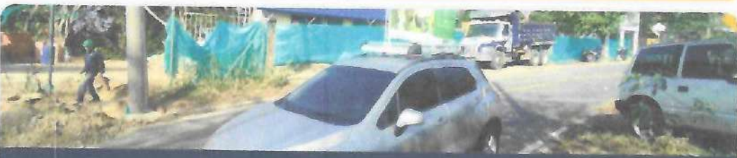
Presencia de interventoría y recurso logístico en obra
