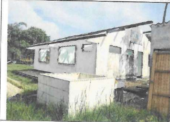
Fotografía No. 05 – Fachada posterior izquierda
