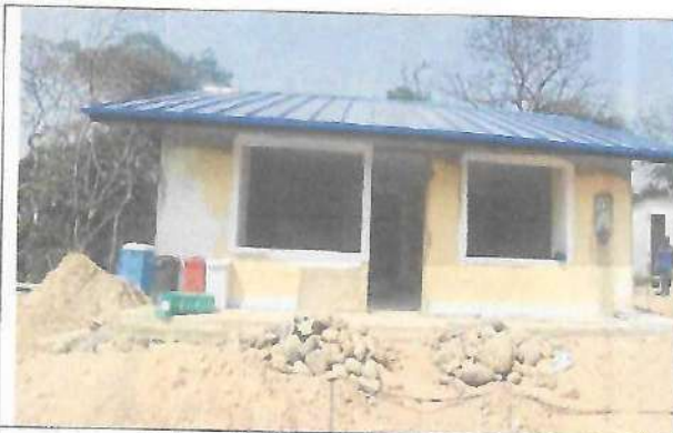
Fotografía No. 01 – Vista Frontal
