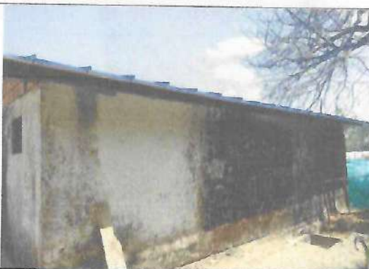
Fotografía No. 04 – Vista Posterior trasera
