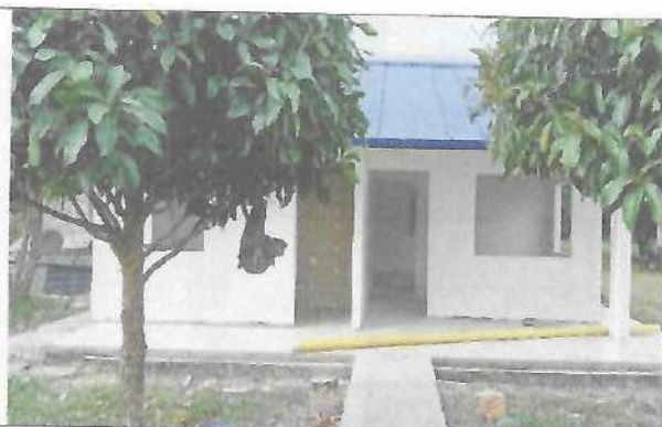
Fotografía No. 01 – Vista acceso
