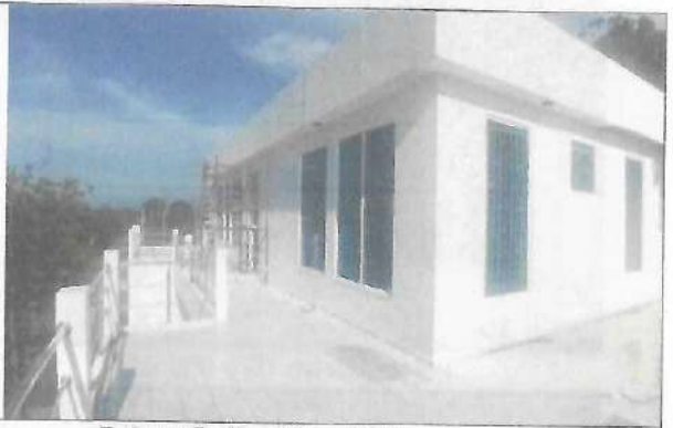
Fotografía No. 04 – Pasillo – terraza 2
