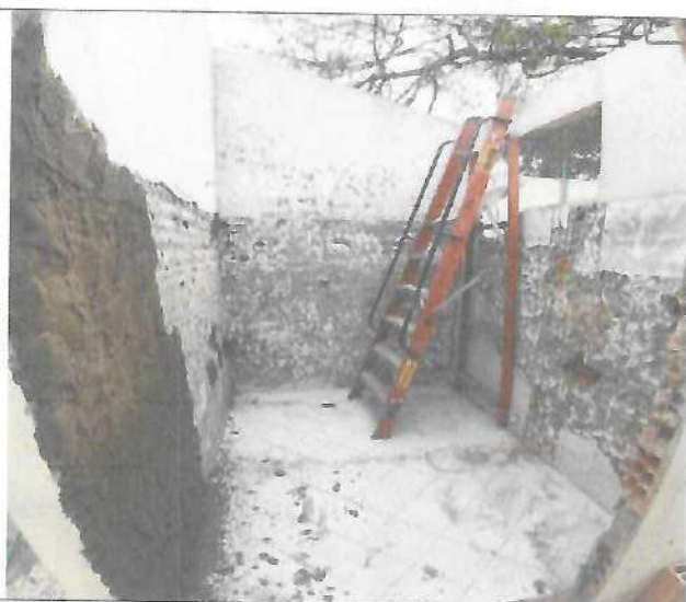
Fotografía No. 11 - baño
