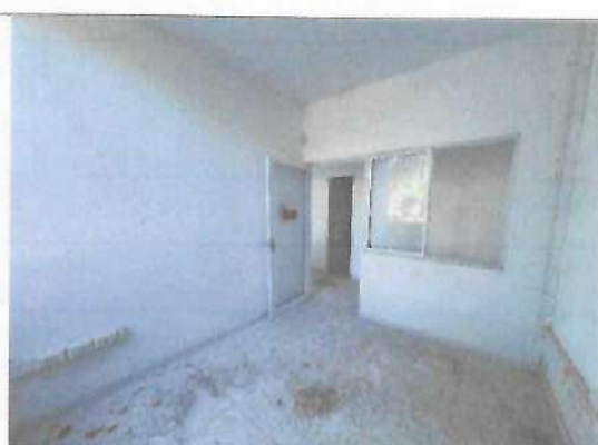
Fotografía No. 16 – Interior cuarto 3
