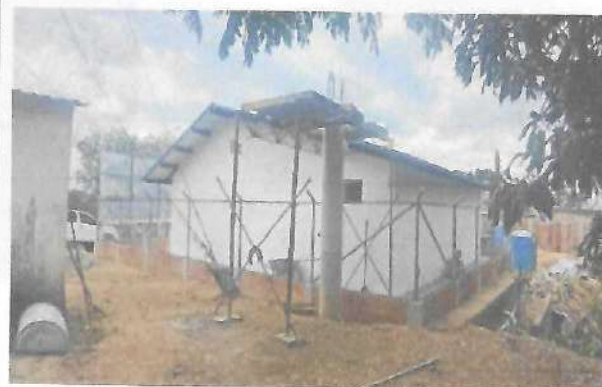
Fotografía No. 05 – Vista Posterior Izq
