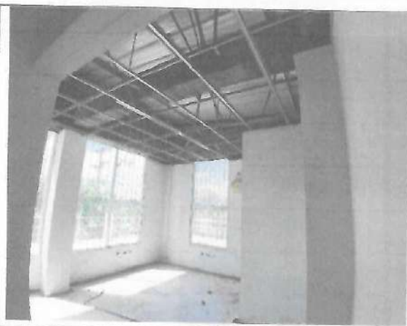
Fotografía No. 11 – Consultorio 2 segundo piso
