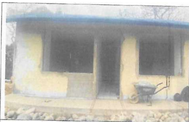
Fotografía No. 01 – Vista Frontal
