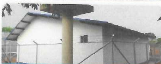
Verificación exterior y cerramiento
