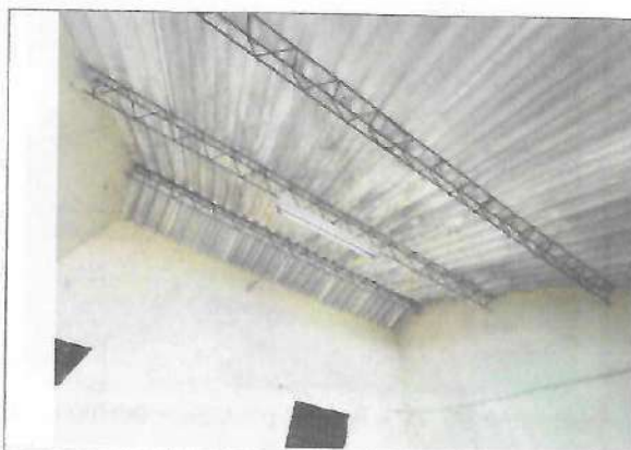
Fotografía No. 13 – Cubierta sala de espera
