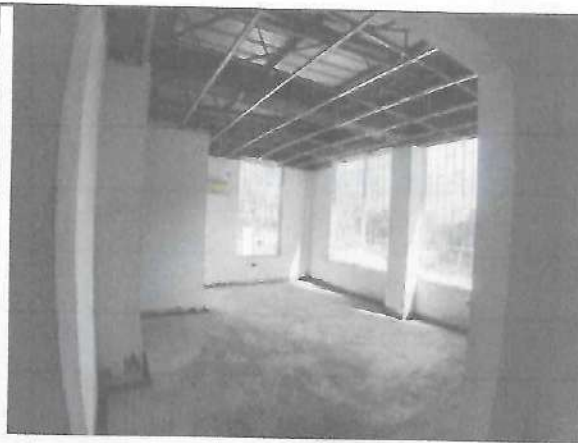
Fotografía No. 10 – consultorio 1 segundo piso
