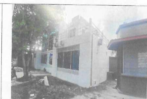
Fotografía No. 02 – Fachada trasera derecha
