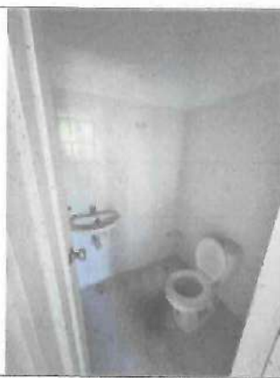
Fotografía No. 17 – Baño 1
