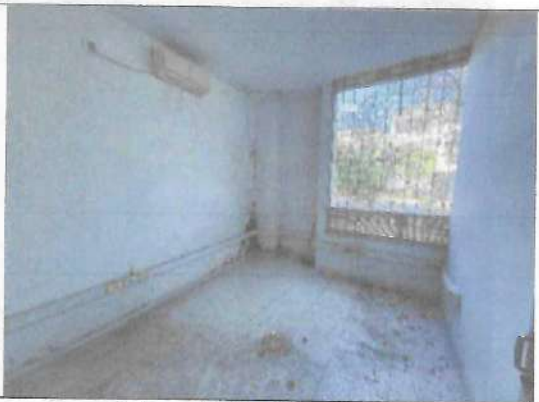
Fotografía No. 28 – Cuarto 5
