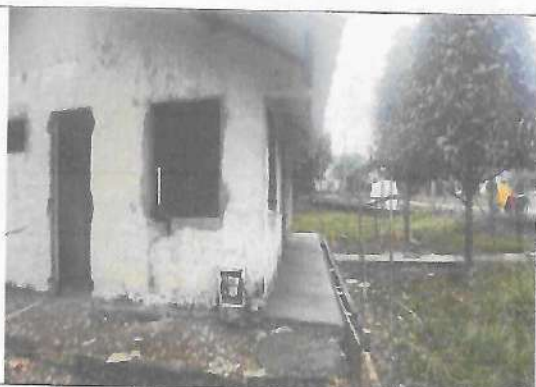
Fotografía No. 03 – vista lateral izquierda2
