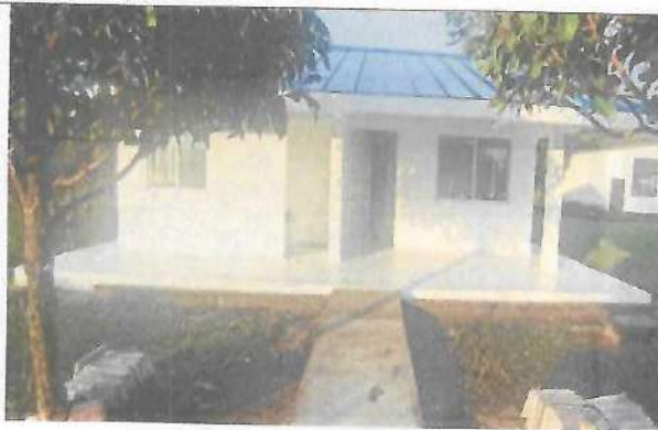
Fotografía No. 01 – Vista acceso
