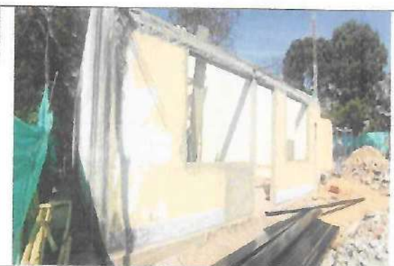
Fotografía No. 05 – Vista Lateral izquierda
