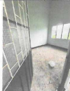
Fotografía No. 26 – Desmonte de baldosa consultorio
