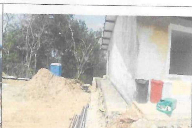
Fotografía No. 06 – Anden Parte Izquierda
