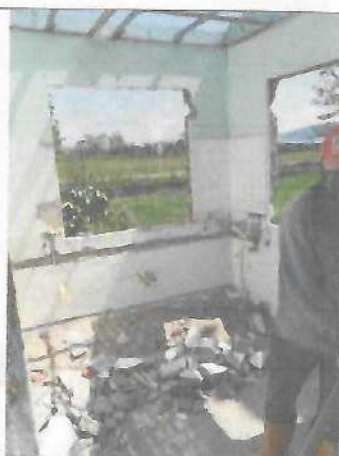
Fotografía No. 38 – Desmonte de mesón de cocina
