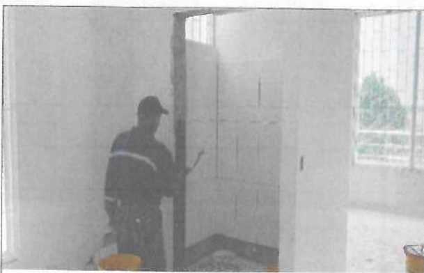
Fotografía No. 05 – Baño Consultorio 3 –Piso 2
