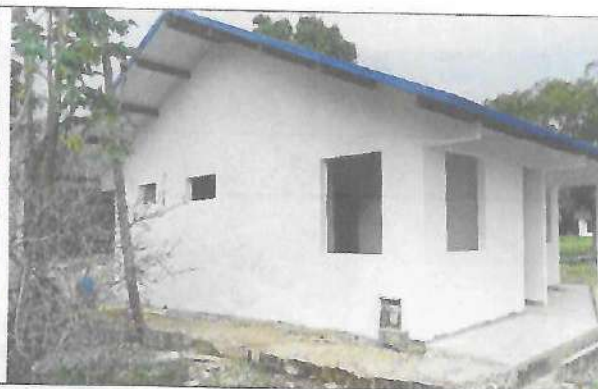
Fotografía No. 02 – Vista Lateral Izquierda
