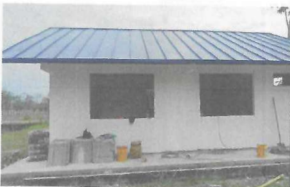
Fotografía No. 05 – Vista Posterior
