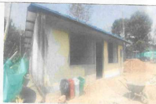
Fotografía No. 01 – Vista Lateral Izquierda
