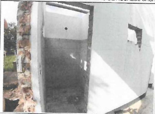
Fotografía No. 09 – Baño
