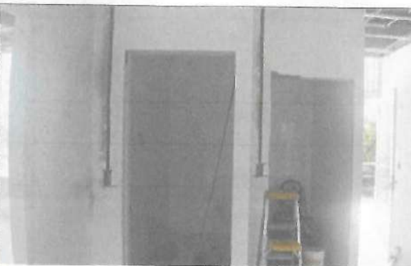
Fotografía No. 06 – Baños -Piso 2
