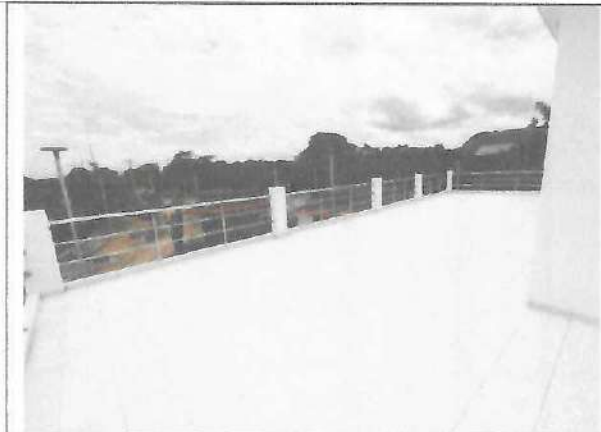
Fotografía No. 13 - Terraza
