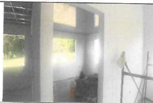
Fotografía No. 08 – Consultorio 1- Cielo Raso
