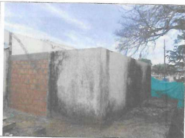
Fotografía No. 03 – Fachada parte trasera
