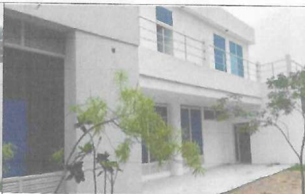
Fotografía No. 04 – Vista Lateral Izq.
