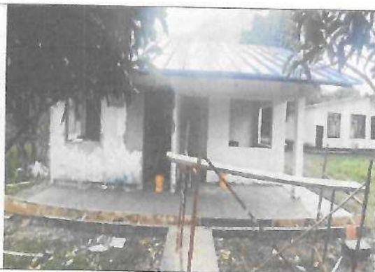
Fotografía No. 01 – Vista acceso
