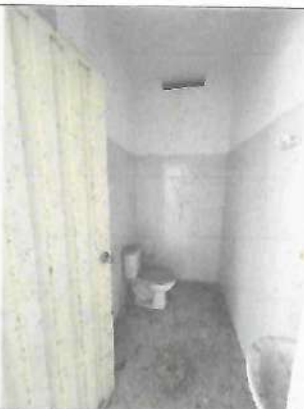
Fotografía No. 18 – Baño 2
