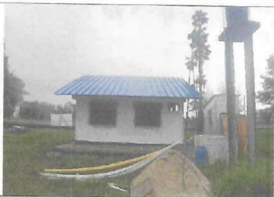
Fotografía No. 05 – Fachada posterior
