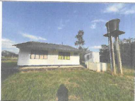
Fotografía No. 05 – Fachada posterior
