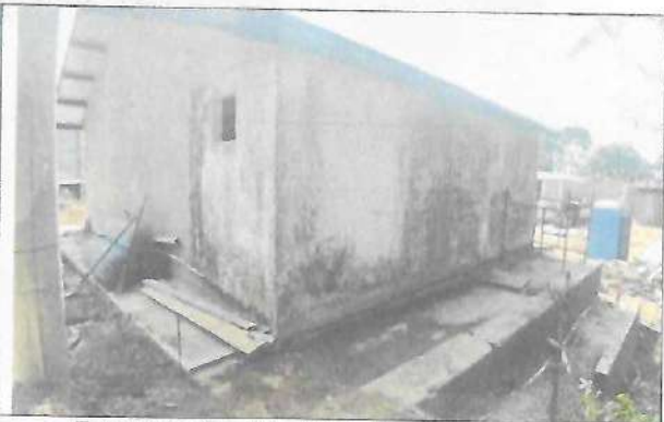
Fotografía No. 04 – Vista Posterior trasera1
