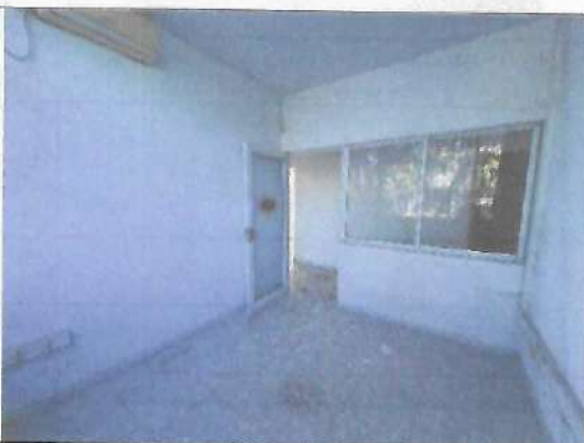
Fotografía No. 27 – Cuarto 4
