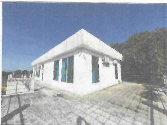
Fotografía No. 05 – Balcón - Terraza
