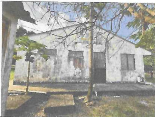
Fotografía No. 06 – Fachada lateral izquierda
