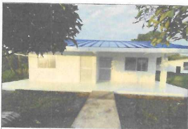
Fotografía No. 01 – Vista acceso
