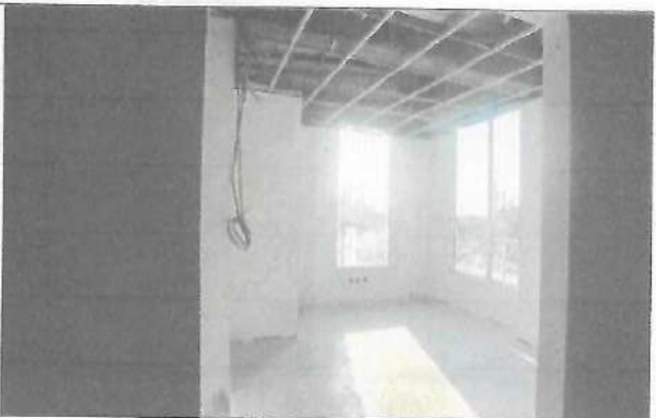
Fotografía No. 06 – Consultorio 3 –piso 2
