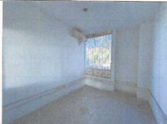
Fotografía No. 13 – Interior cuarto 1
