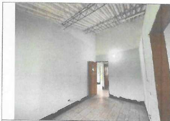
Fotografía No. 13 - Consultorio 2
