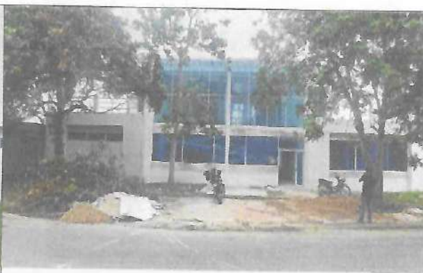
Fotografía No. 02 – Vista Posterior
