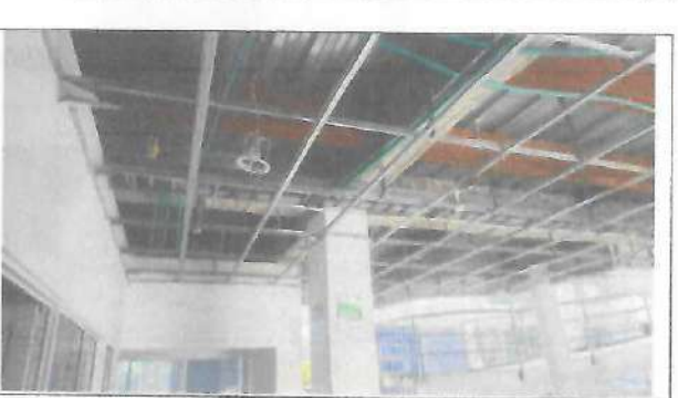
Fotografía No. 42 – Desmonte de cielo raso primer piso
