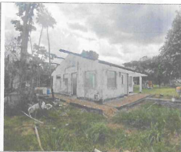
Fotografía No. 03 – vista lateral izquierda
