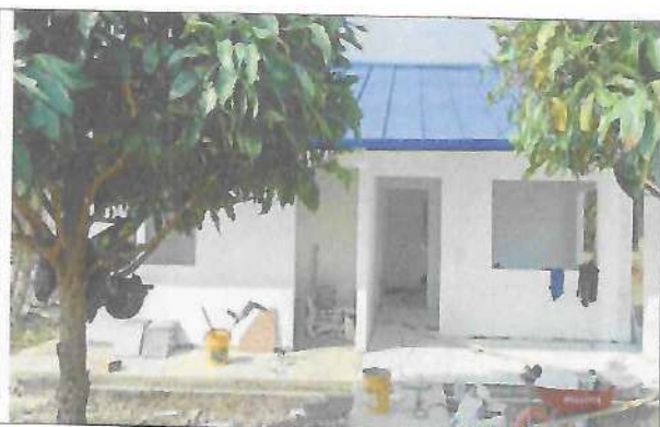
Fotografía No. 01 – Vista acceso
