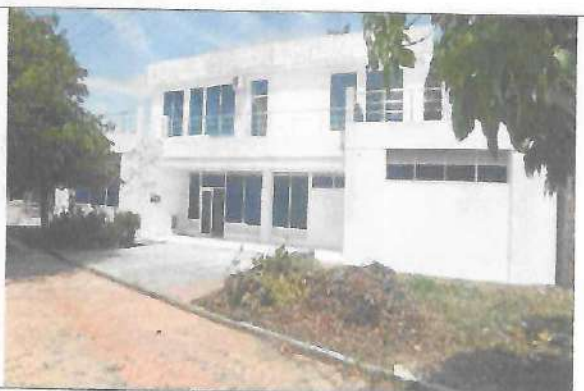
Fotografía No. 02 – vista Fachada principal derecha
