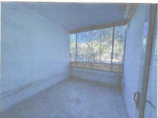
Fotografía No. 15 – Interior cuarto 2
