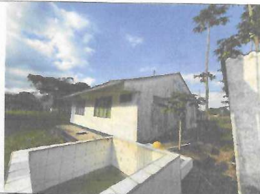
Fotografía No. 02 – Vista posterior
