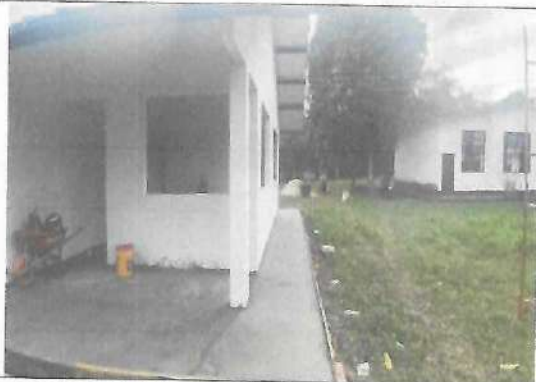
Fotografía No. 05 – Anden Lateral Derecha1
