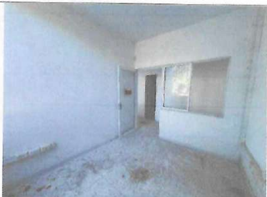
Fotografía No. 16 – Interior cuarto 3
