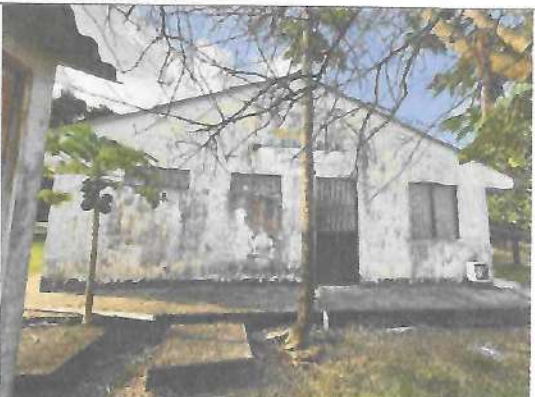
Fotografía No. 06 – Fachada lateral izquierda
