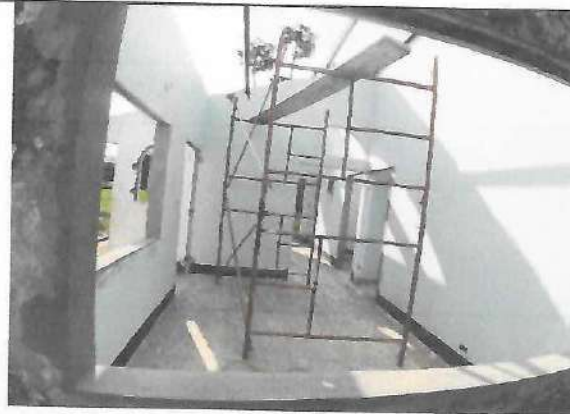
Fotografía No. 06 – Sala De Espera
