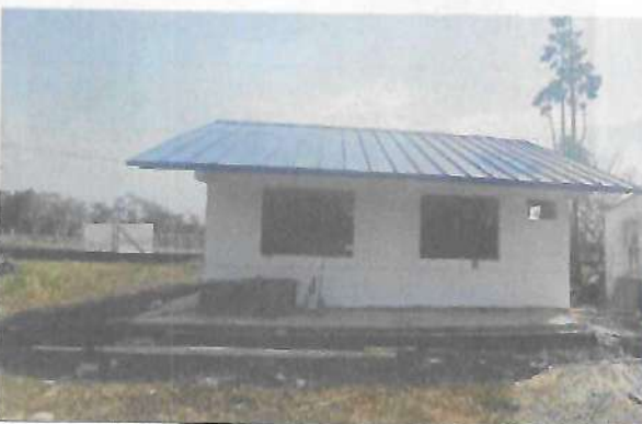
Fotografía No. 05 – Vista Posterior
