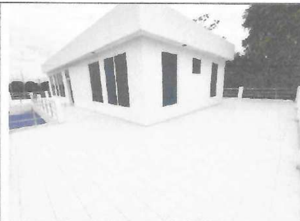
Fotografía No. 14 – Terraza
