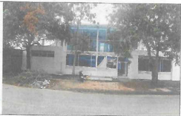
Fotografía No. 02 – Vista Posterior
