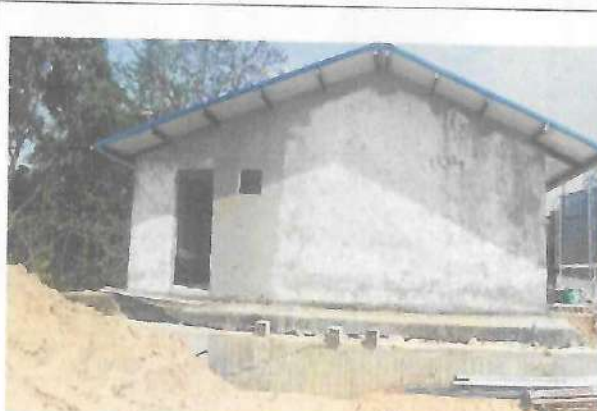
Fotografía No. 05 – Vista lateral izquierda 1
