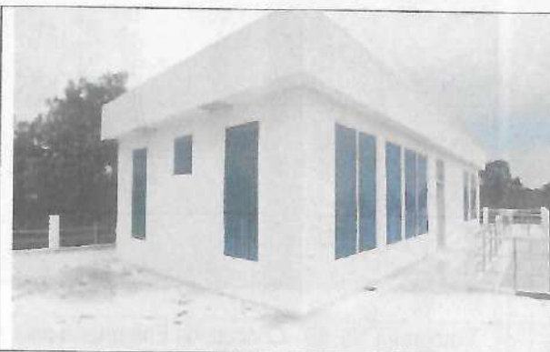
Fotografía No. 03 – Pasillo – terraza 1
