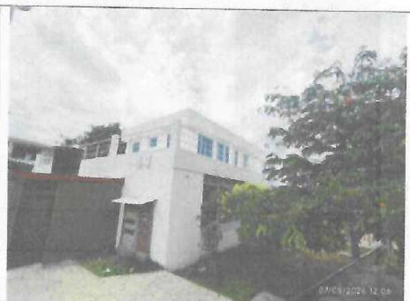
Fotografía No. 03 – Fachada Principal
