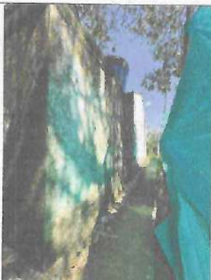
Fotografía No. 05 – Fachada lateral izquierda
