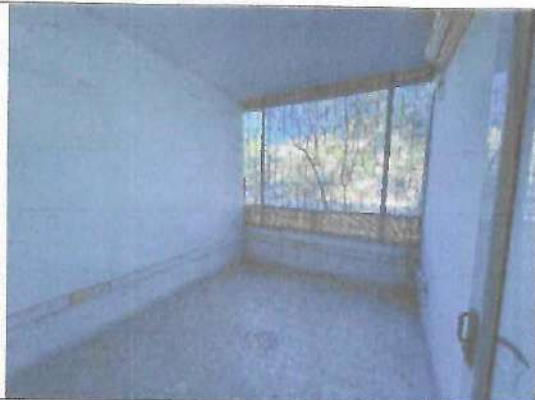
Fotografía No. 15 – Interior cuarto 2
