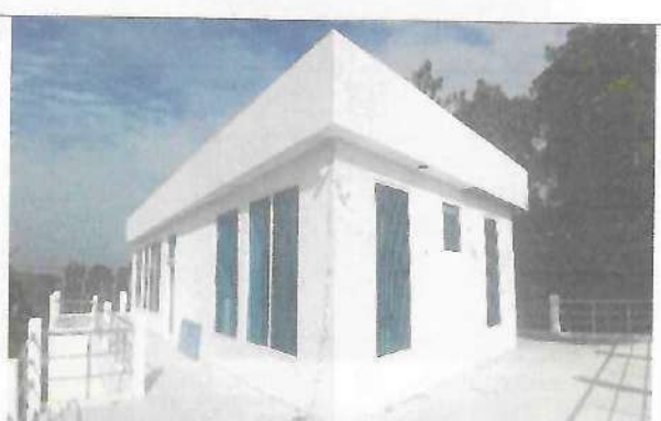
Fotografía No. 04 – balcón , pasillo
