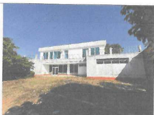
Fotografía No. 02 – Fachada posterior
