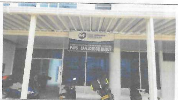
Fotografía No. 05 – Señalización
