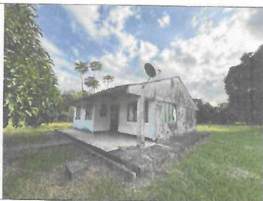
Fotografía No. 01 – Vista acceso
