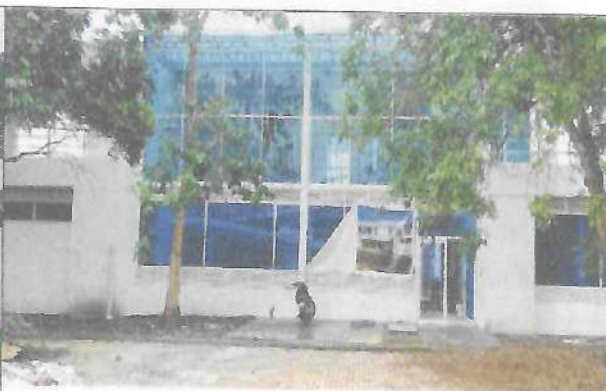
Fotografía No. 02 – Vista Posterior
