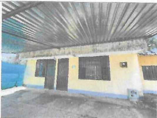
Fotografía No. 03 – Fachada principal
