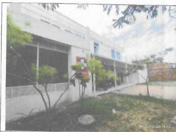
Fotografía No. 01 – Fachada Principal
