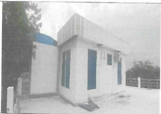
Fotografía No. 06 – Balcón – Terraza- derecha
