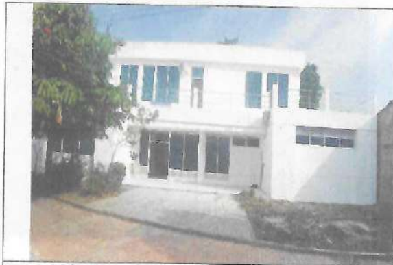
Fotografía No. 01 – Fachada principal
