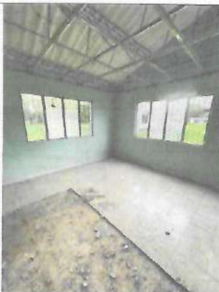
Fotografía No. 27 – Desmonte de baldosa y cielo raso
