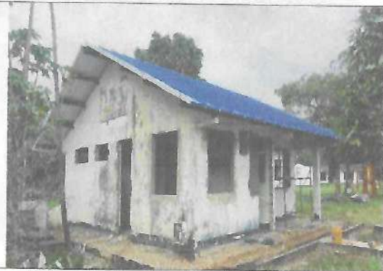
Fotografía No. 04 – Vista Lateral izquierda 2
