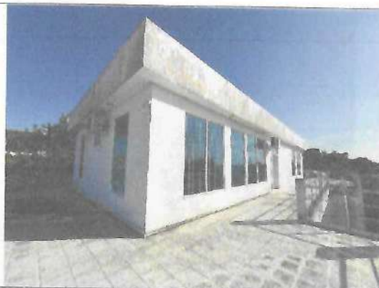
Fotografía No. 06 – Balcón - Terraza
