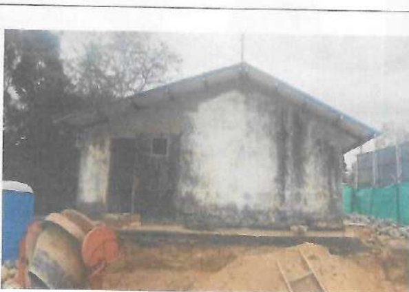
Fotografía No. 05 – Vista lateral izquierda 1
