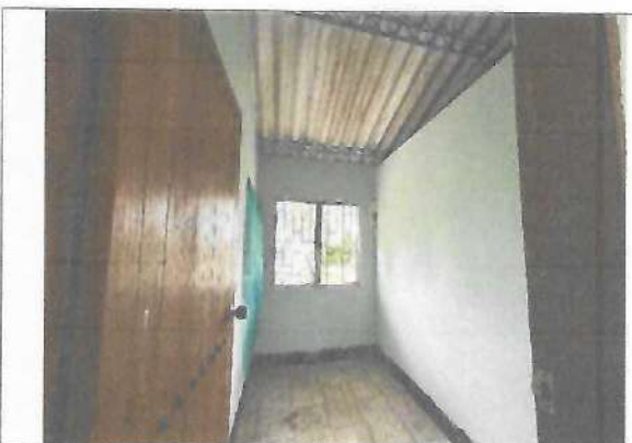
Fotografía No. 17 – Consultorio 3
