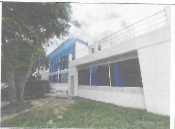
Fotografía No. 04 - Fachada Posterior
