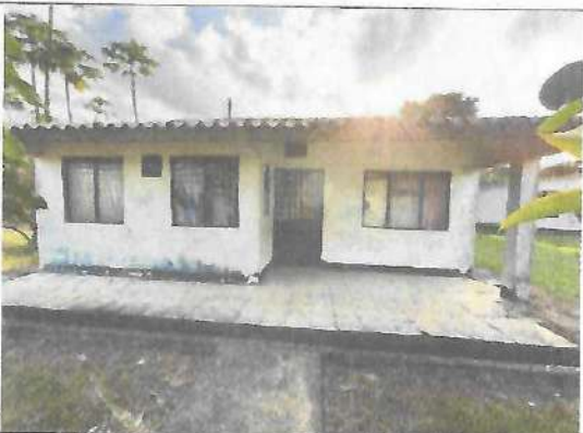
Fotografía No. 03 – Fachada principal
