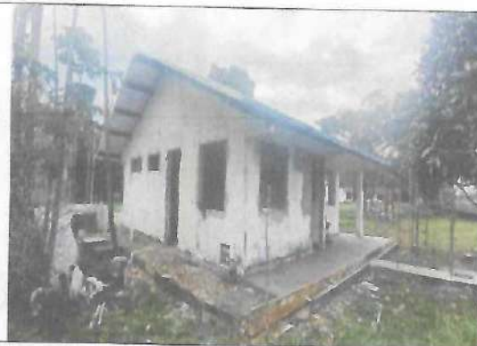
Fotografía No. 02 – Vista Lateral Izquierda 1
