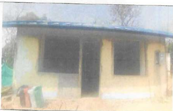
Fotografía No. 01 – Vista Frontal
