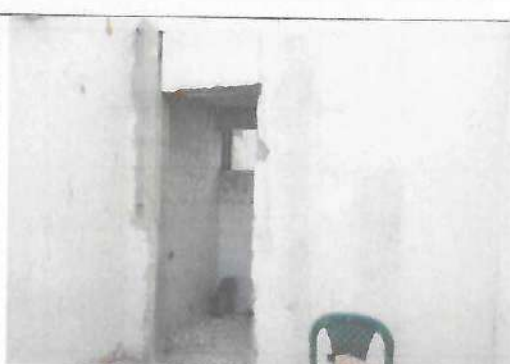
Fotografía No. 28 – Desmonte de puerta baño
