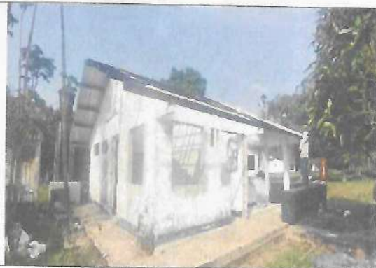
Fotografía No. 03 – vista lateral izquierda
