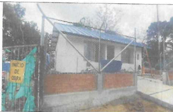
Fotografía No. 02 – Vista Lateral Izq
