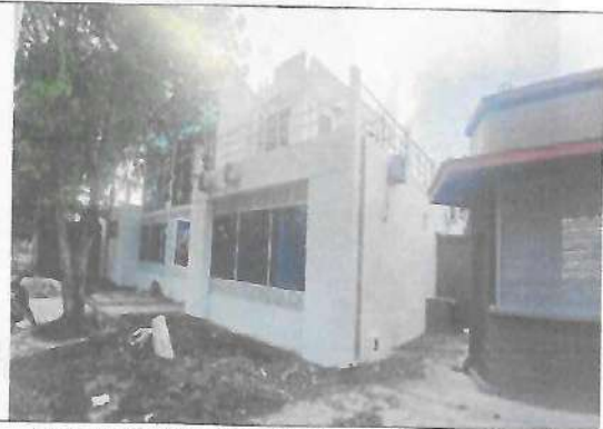
Fotografía No. 02 – Fachada trasera derecha
