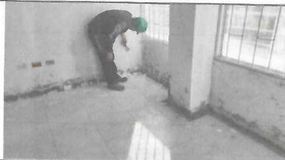
Fotografía No. 50 - Demolición parcial de baldosa para media caña
