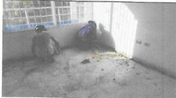
Fotografía No. 49 – Demolición parcial de baldosa para media caña
