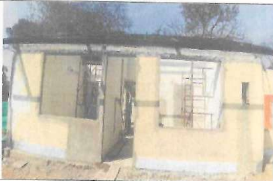
Fotografía No. 01 – Vista acceso
