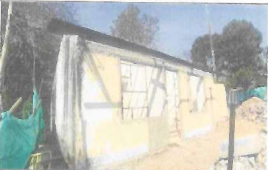
Fotografía No. 03 – Vista lateral izquierda
