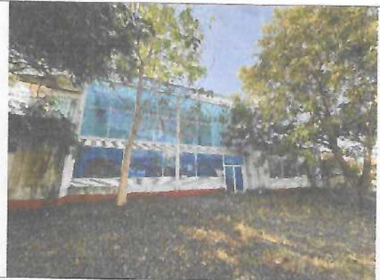
Fotografía No. 01 – Fachada principal
