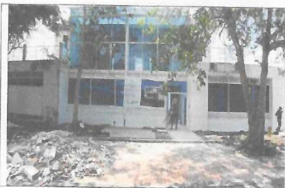
Fotografía No. 03 – Fachada Trasera Frente
