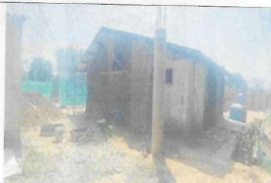
Fotografía No. 04 – Vista Posterior trasera1
