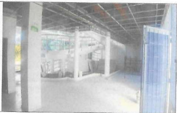
Fotografía No. 06 – Sala Espera - Piso 1
