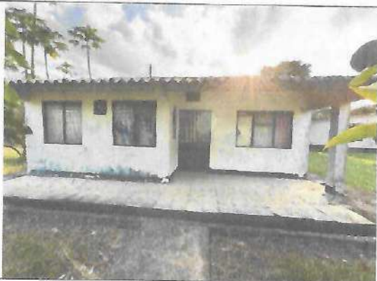
Fotografía No. 03 – Fachada principal
