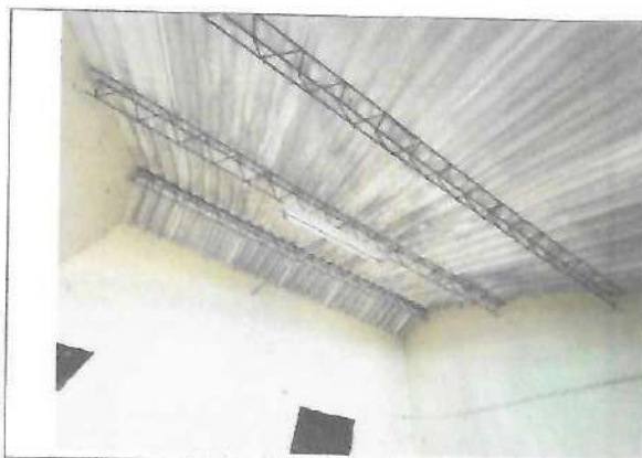
Fotografía No. 13 – Cubierta sala de espera
