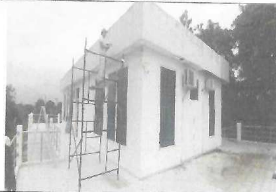
Fotografía No. 04 – balcón , pasillo
