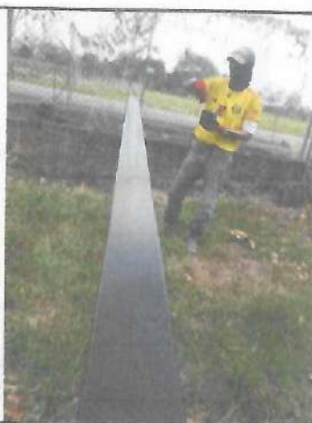
Fotografía No. 36 – Estructura metálica cubierta
