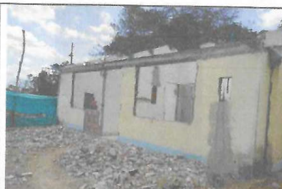
Fotografía No. 26 - Demolición de viga canal fachada
