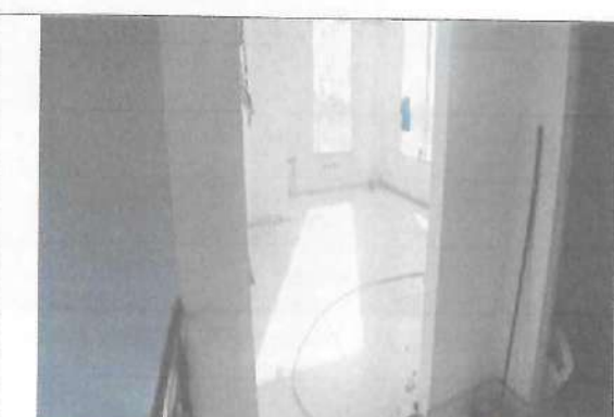
Fotografía No. 06 – Consultorio 4 Segundo Piso
