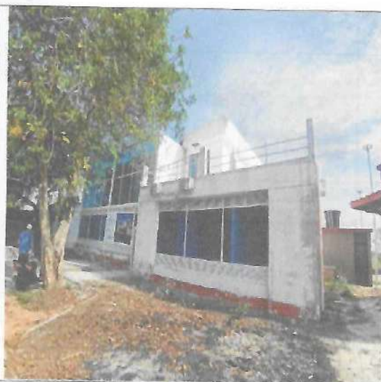
Fotografía No. 02 – Fachada trasera derecha
