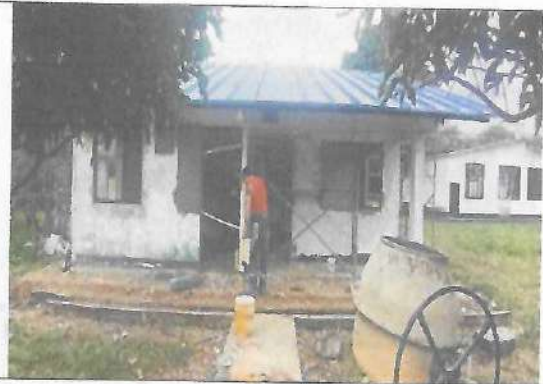
Fotografía No. 02 – Vista Acceso 2
