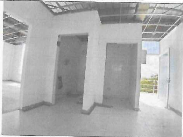
Fotografía No. 09 – baños segundo piso
