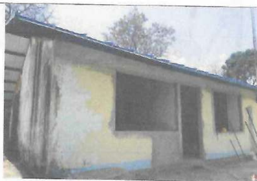
Fotografía No. 02 – Vista Lateral izquierda
