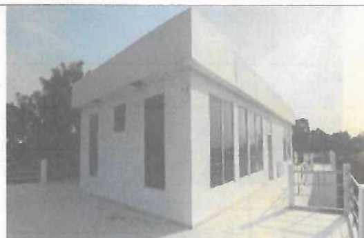
Fotografía No. 06 – Vista Lateral Derecha Balcón, Pasillo
