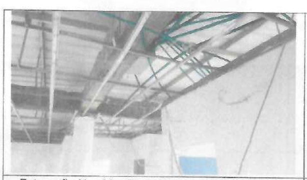
Fotografía No. 41 – Desmonte cielo raso segundo piso
