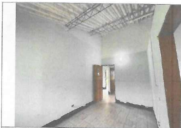
Fotografía No. 13 - Consultorio 2
