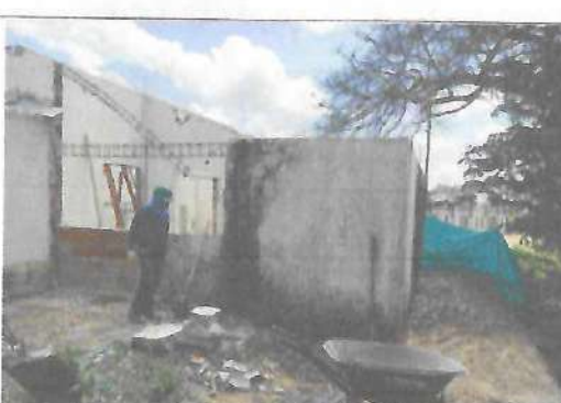
Fotografía No. 30 – Demolición de muro
