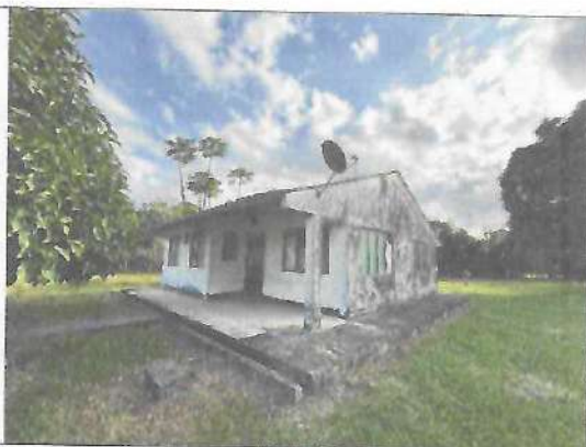
Fotografía No. 01 – Vista acceso
