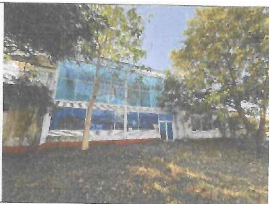
Fotografía No. 01 – Fachada principal
