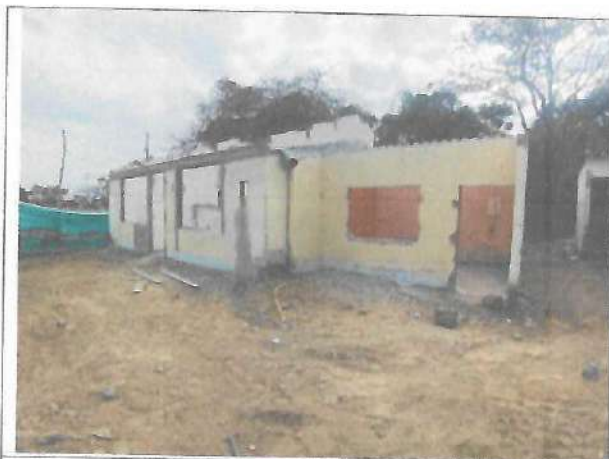
Fotografía No. 01 – Vista acceso derecha
