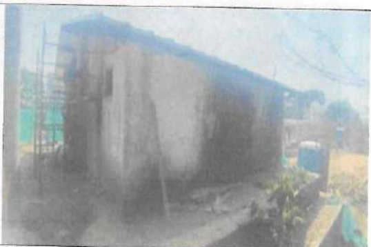
Fotografía No. 05 – Vista Posterior trasera 2
