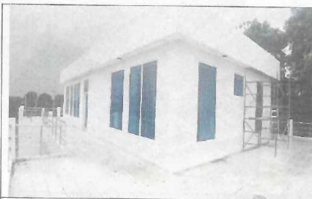
Fotografía No. 05 – Pasillo – terraza 3
