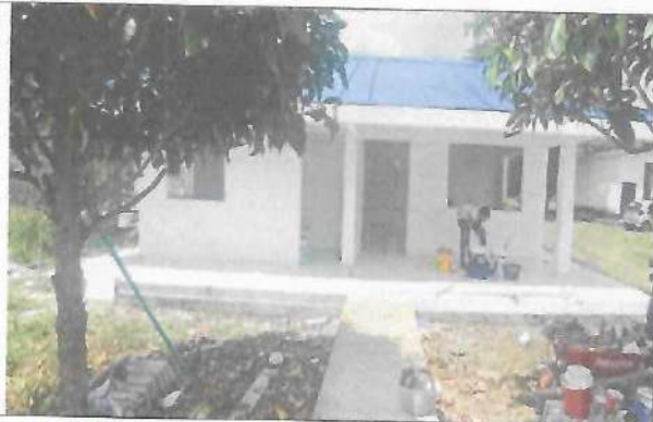
Fotografía No. 01 – Vista acceso
