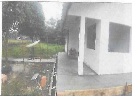
Fotografía No. 06 – Anden lateral derecha 2
