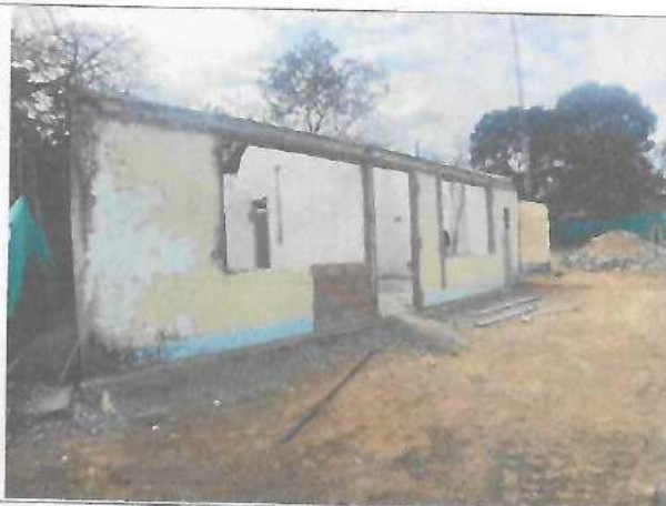
Fotografía No. 02 – Lateral izquierdo
