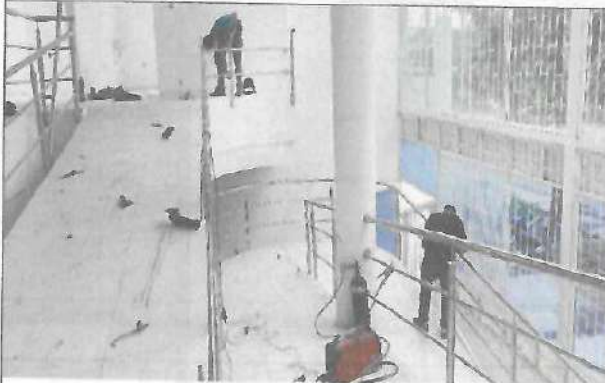
Fotografía No. 05 – Barandas Escaleras
