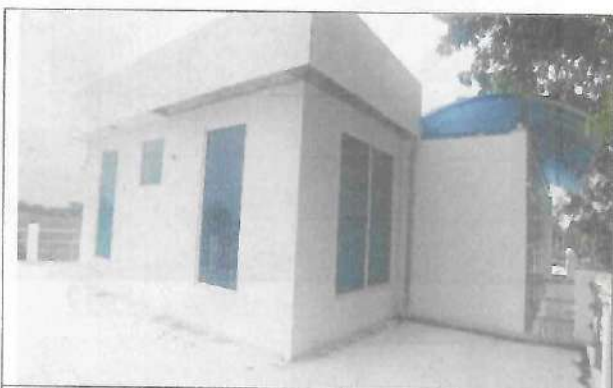
Fotografía No. 05 – Vista trasera Pasillo, Balcón
