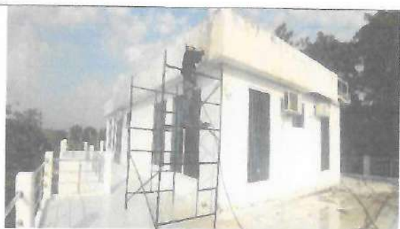
Fotografía No. 06 – Balcón – Terraza- derecha
