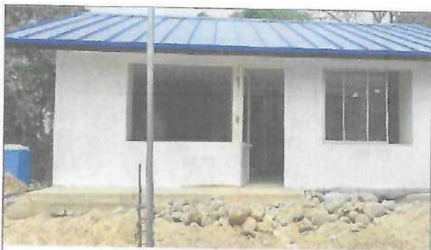
Fotografía No. 01 – Vista Frontal
