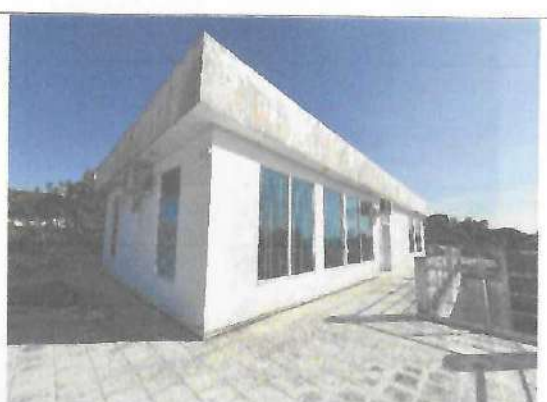
Fotografía No. 06 – Balcón - Terraza
