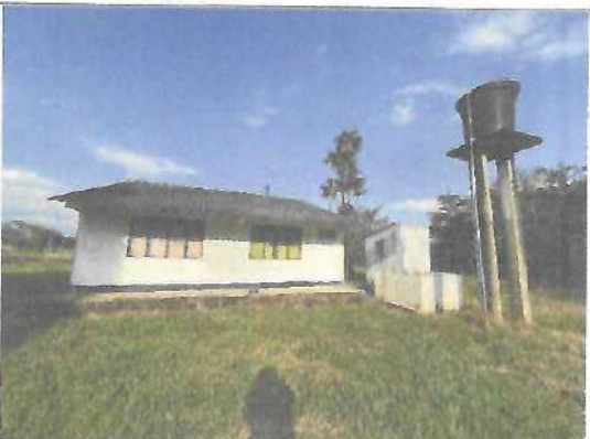
Fotografía No. 05 – Fachada posterior
