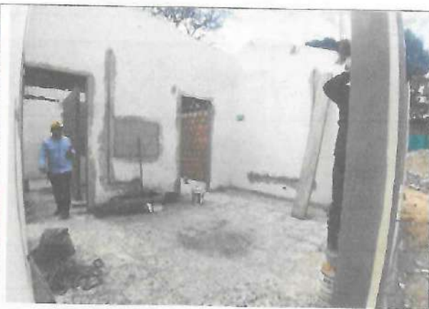
Fotografía No. 04 – sala de espera
