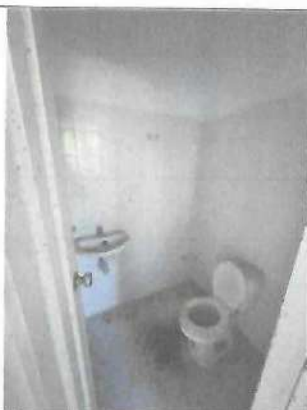
Fotografía No. 17 – Baño 1
