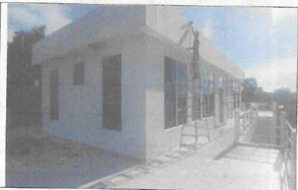
Fotografía No. 03 – Pasillo – terraza 1
