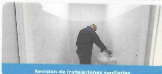
Revisión de instalaciones sanitarias
