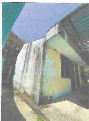
Fotografía No. 02 – Lateral izquierdo
