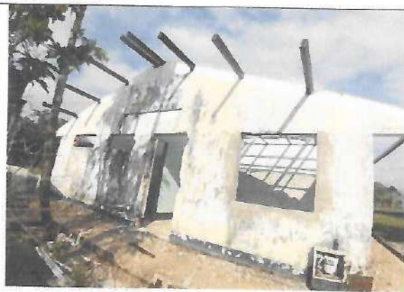
Fotografía No. 04 – Fachada lateral izquierda
