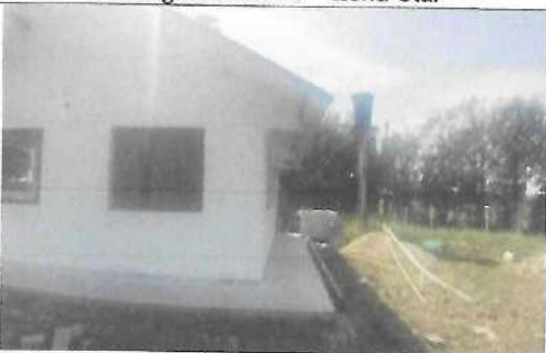
Fotografía No. 12 – Parte posterior Anden
