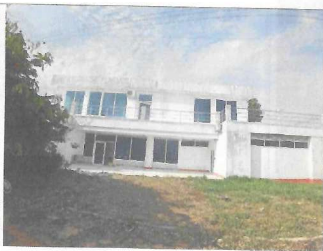
Fotografía No. 01 – Fachada principal
