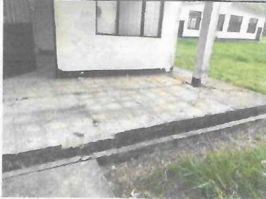
Fotografía No. 25 – Desmonte de baldosa acceso
