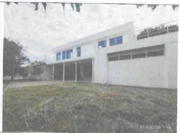
Fotografía No. 02 - Fachada Principal
