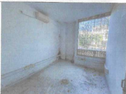
Fotografía No. 28 – Cuarto 5
