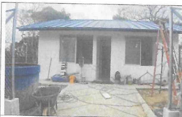
Fotografía No. 01 – Vista Frontal
