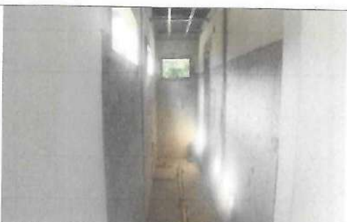
Fotografía No. 09 – Vista Baños
