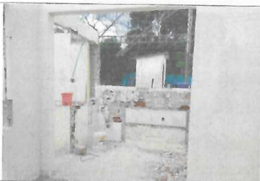
Fotografía No. 27 – Desmonte de enchape cocina
