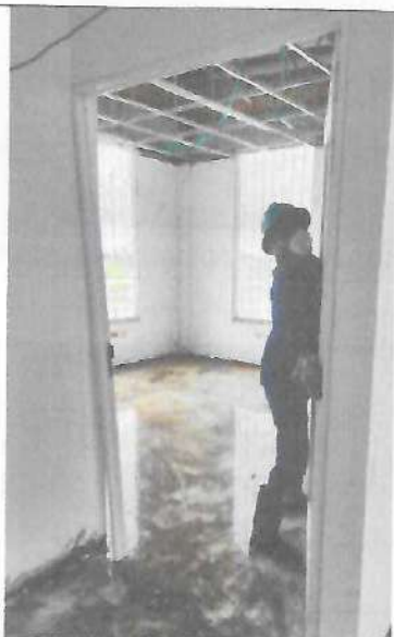
Fotografía No. 51 – Desmonte de puertas de acceso a consultorios
