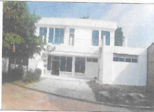
Fotografía No. 01 – Fachada principal
