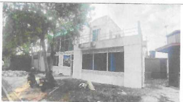
Fotografía No. 04 – Fachada Trasera Derecha
