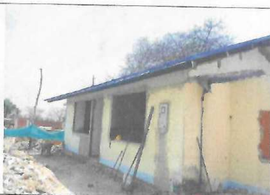
Fotografía No. 01 – Vista lateral derecha Cubierta 1
