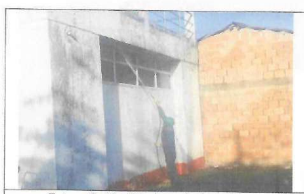
Fotografía No. 39 – Lavado de fachadas
