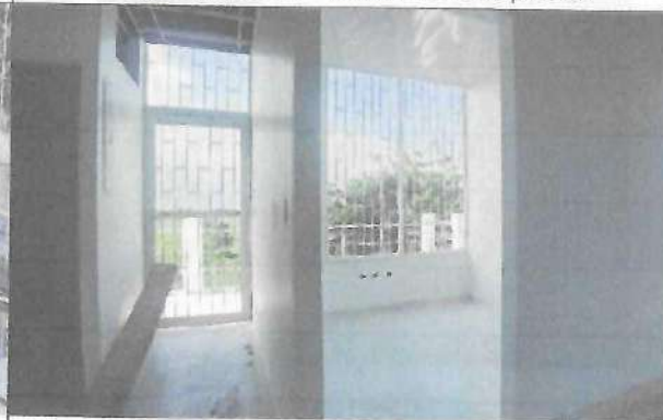
Fotografía No. 06 – Consultorio 2 - Piso 2
