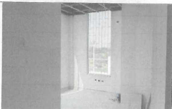
Fotografía No. 04 – Consultorio Enfermería –Piso 2
