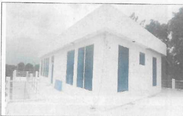
Fotografía No. 03 – Balcón, Pasillo, Lado Derecho
