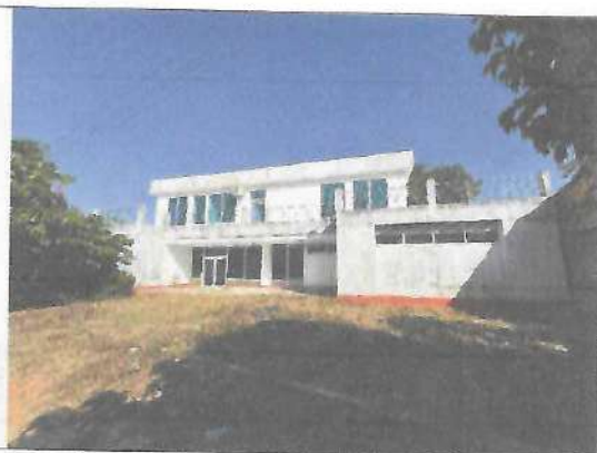
Fotografía No. 02 – Fachada posterior
