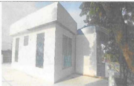
Fotografía No. 05 – Vista trasera Pasillo, Balcón
