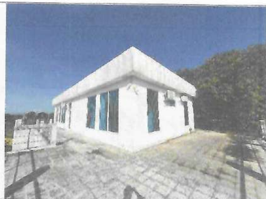
Fotografía No. 05 – Balcón - Terraza
