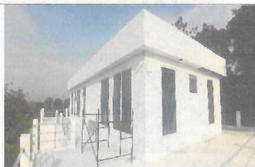
Fotografía No. 04 – Balcón, Pasillo
