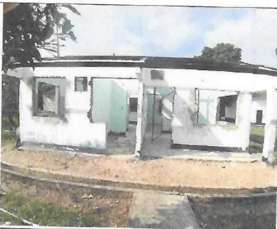
Fotografía No. 01 – Vista acceso
