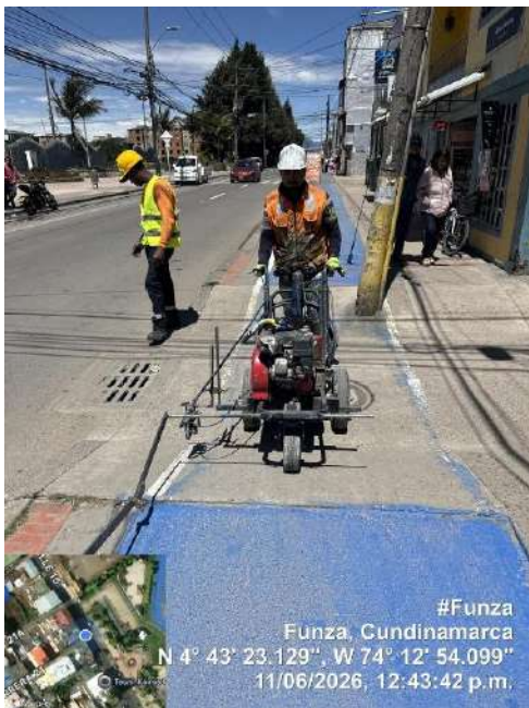
Ilustración 5, Implementación 11 de junio de 2026, Funza-Tres Esquinas
