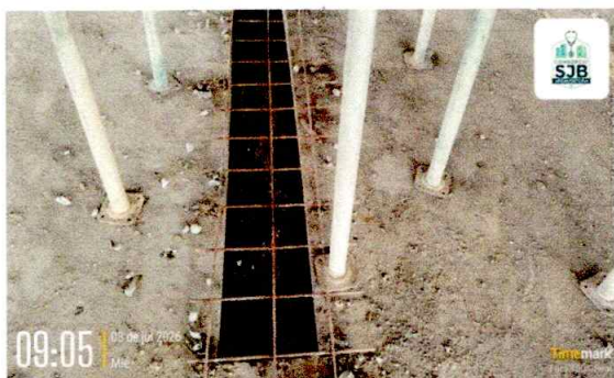
Ilustración 38 Instalación de barreras provisionales de acero en aberturas en placa 1.
