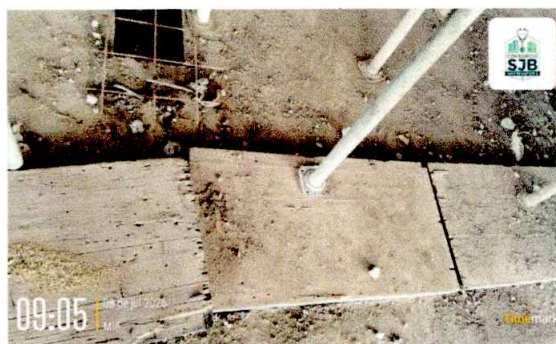
Ilustración 38 Instalación de barreras provisionales de acero en aberturas en placa 1.
