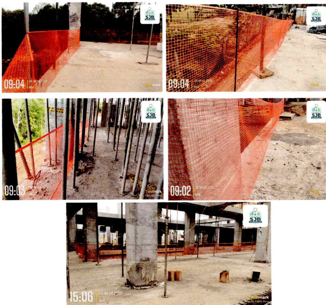
Ilustración 39 Cerramiento en malla de seguridad a placa 1. Fuente: elaboración propia
