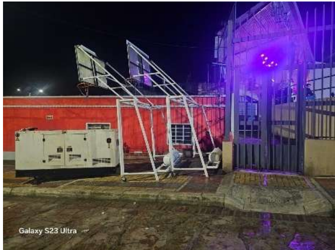
Ítem 11: Planta Eléctrica - Generador Eléctrico De 100 Kva Trifásico 110 Voltios X Fases Sistema De Encendido Y Apagado Electrónico Y Acometida De 50m
