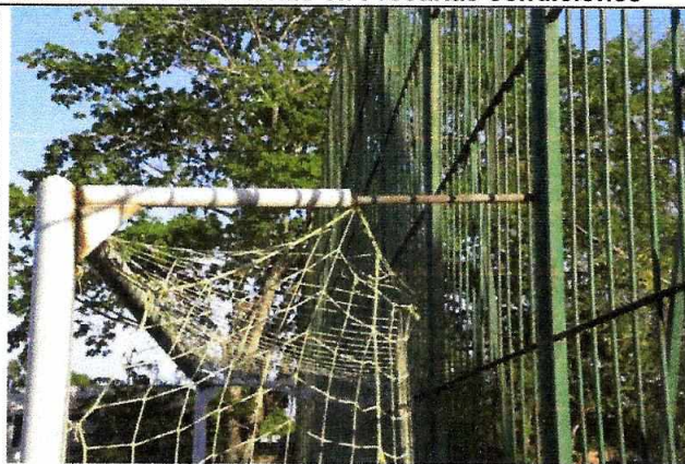
Ilustración 11. Porterías en Precarias condiciones
