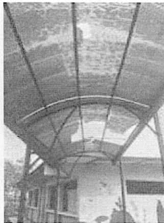
Policarbonato de las pasarelas exteriores en notable deterioro.
