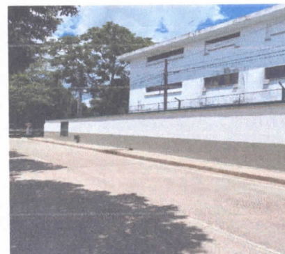
DEGUV-18 (Pinturas muro de cerramiento por deterioro y desprendimiento e instalación de reflectores fuera de servicio)
