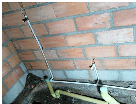
REF. Img. 041_DEMOLICION - CRA 28 CON CALLE 27_SANTA ROSA
