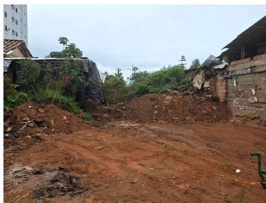
REF. Img. 009_DEMOLICION - CRA 28 CON CALLE 27_SANTA ROSA
