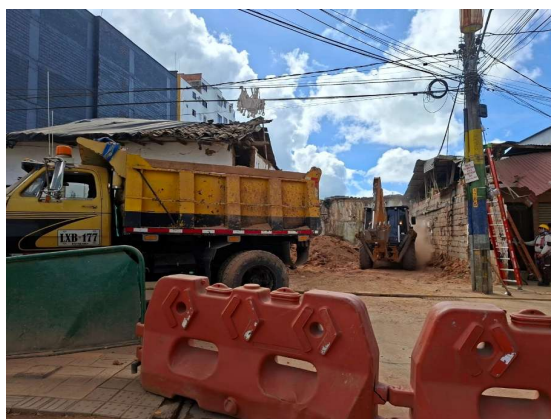
REF. Img. 006_DEMOLICION - CRA 28 CON CALLE 27_SANTA ROSA
