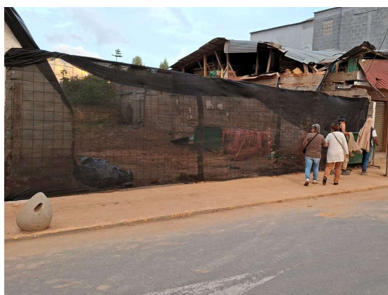
REF. Img. 014_DEMOLICION - CRA 28 CON CALLE 27_SANTA ROSA
