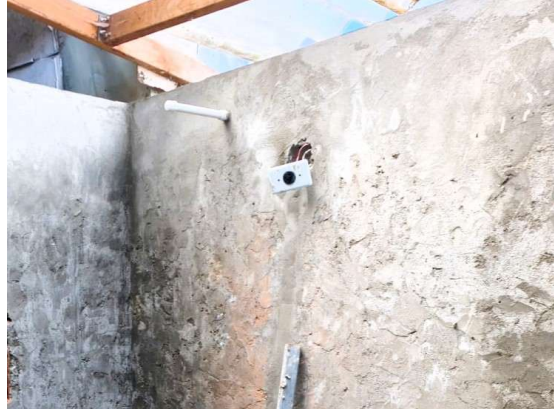
REF. Img 081_DEMOLICION - CRA 28 CON CALLE 27_SANTA ROSA
