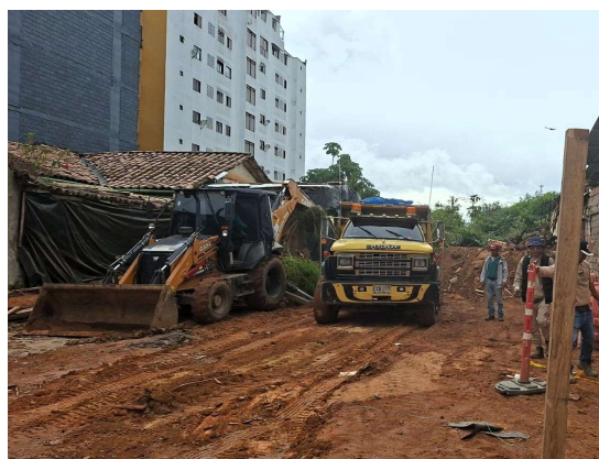
REF. Img. 007_DEMOLICION - CRA 28 CON CALLE 27_SANTA ROSA
