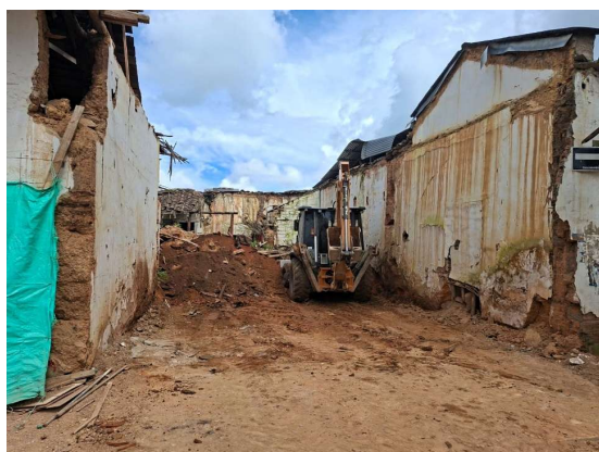
REF. Img. 008_DEMOLICION - CRA 28 CON CALLE 27_SANTA ROSA
