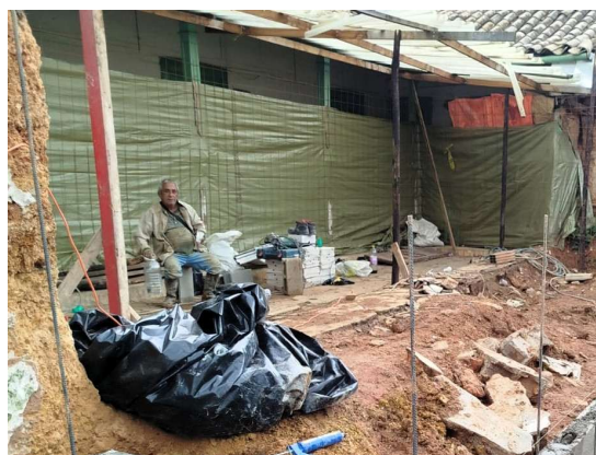
REF. Img. 017_DEMOLICION - CRA 28 CON CALLE 27_SANTA ROSA
