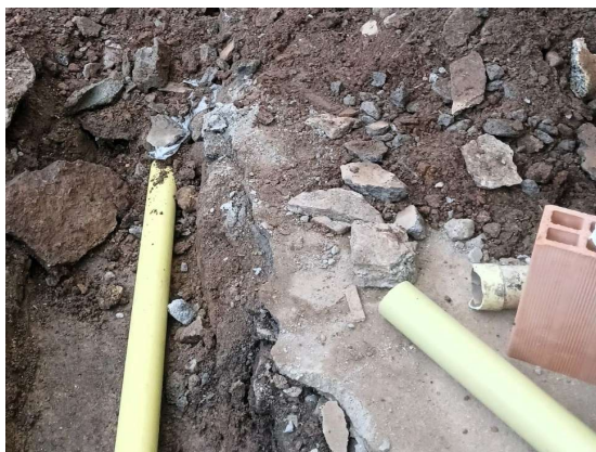
REF. Img. 040_DEMOLICION - CRA 28 CON CALLE 27_SANTA ROSA
