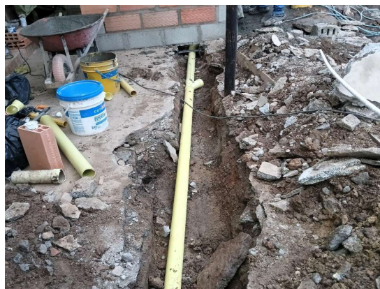
REF. Img. 043_DEMOLICION - CRA 28 CON CALLE 27_SANTA ROSA
