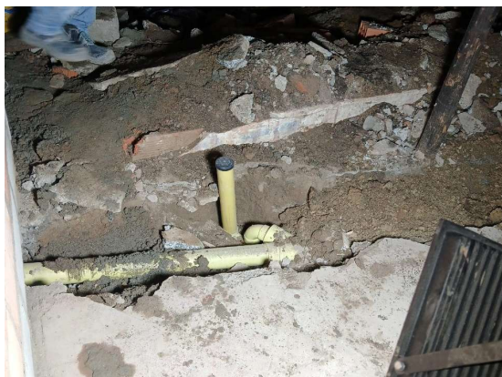
REF. Img. 042_DEMOLICION - CRA 28 CON CALLE 27_SANTA ROSA
