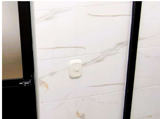
REF. Img 083_DEMOLICION - CRA 28 CON CALLE 27_SANTA ROSA
