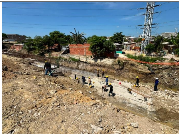
Imagen 3: Se observó la presencia de tres cuadrillas realizando actividades de armado de acero de refuerzo, carpintería para sistemas de formaleta y mantenimiento de aseo en el frente de obra.
