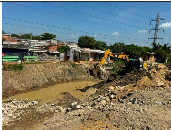
IMAGEN 2: Se observó la remoción y cargue de material mediante retroexcavadora.
