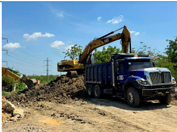
Imagen 1: Realizando actividades de movimiento de tierras, asociadas al retiro y transporte de material producto de excavación.
