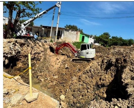
Imagen 4: Se evidenció la ejecución de actividades de excavación para la instalación de la red de agua potable.
