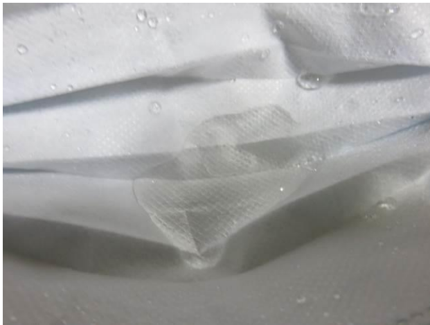
Prueba de impermeabilidad
