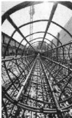
Vista interna de Canastas para Pilotes
