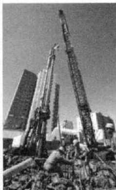
Uso de pilotes en construcción
